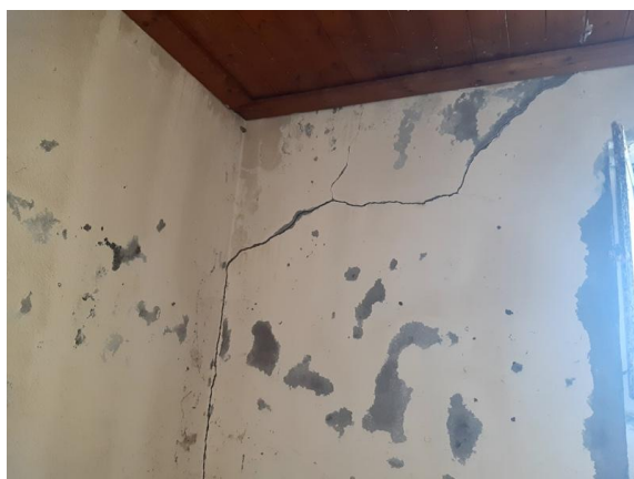
Part. 811 sub 2 - Vista interna
