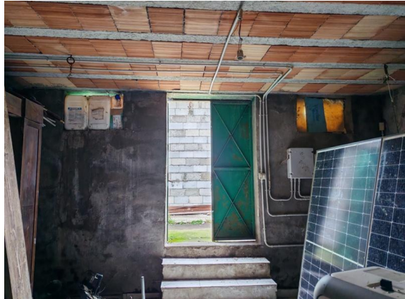
Vista interna cantina
