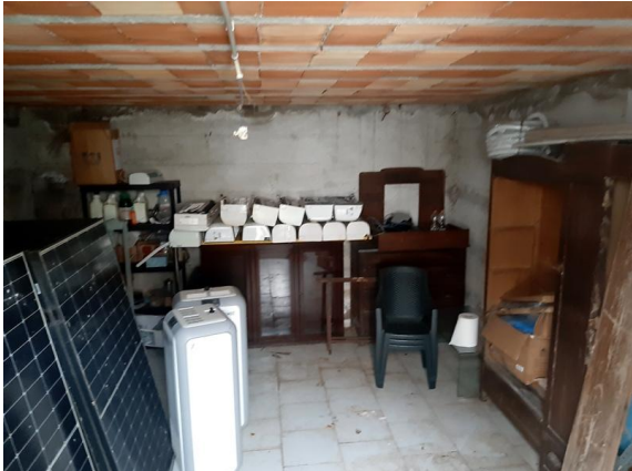
Vista interna cantina
