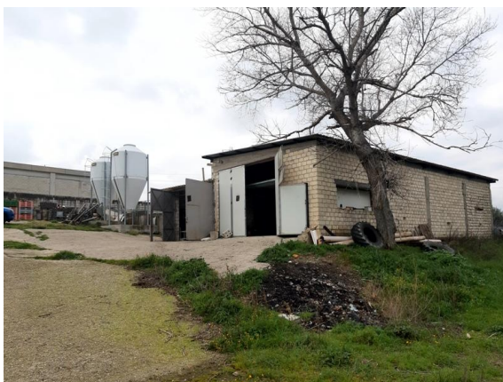
Vista esterna fabbricati
