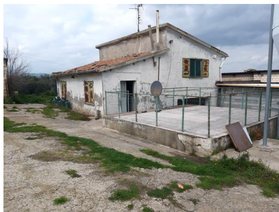
Vista esterna fabbricati
