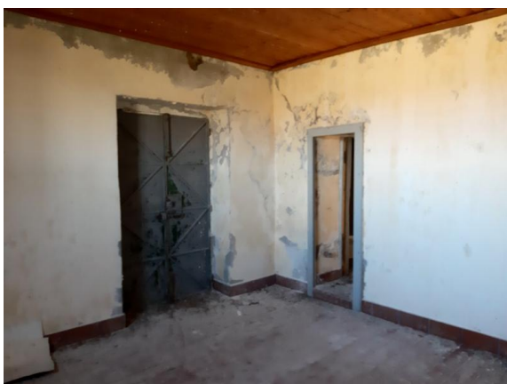
Part. 811 sub 2 - Vista interna
