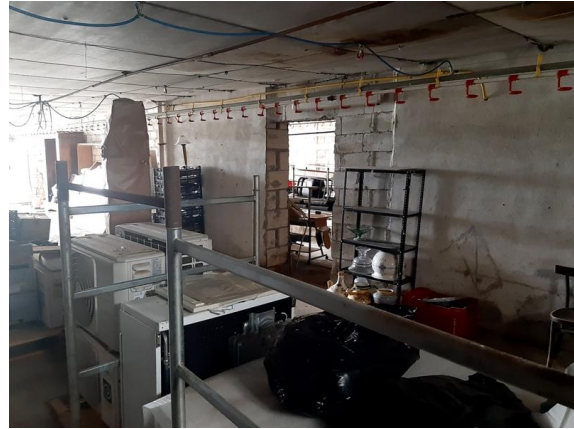
Vista interna rimessa-deposito
