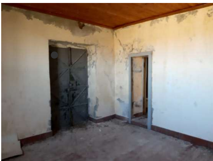
Foto n. 28 – Fg. 14 part. 811 sub 2 - Vista interna
