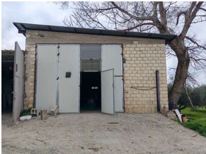
Foto n. 47 – Fg. 14 part. 538 sub 18 – Vista deposito-rimessa
