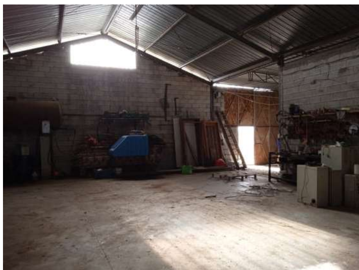
Foto n. 14 – Fg. 14 part. 798 - Vista interna
