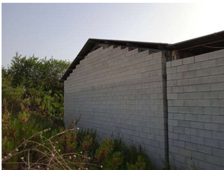
Foto n. 10 – Fg. 14 part. 798 - Vista esterna
