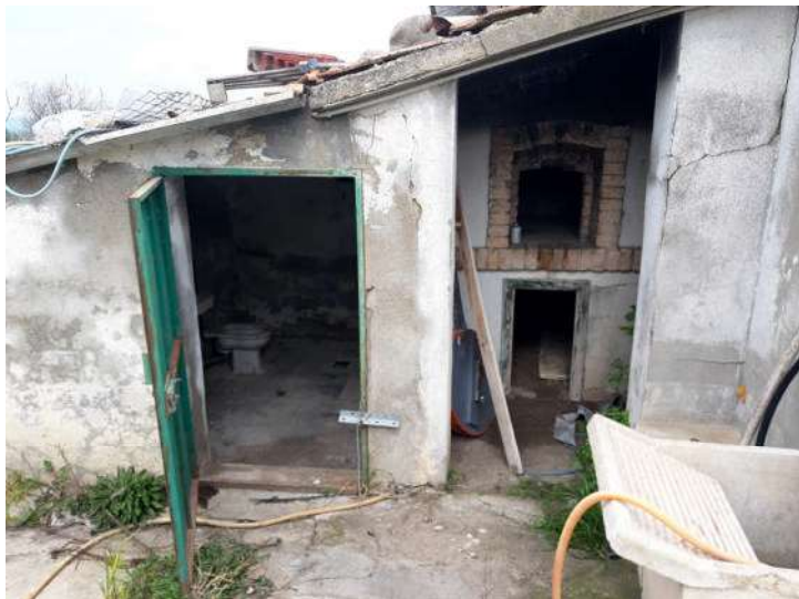
Foto n. 77 – Fg. 14 part. 538 sub 19 – Vista forno e deposito
