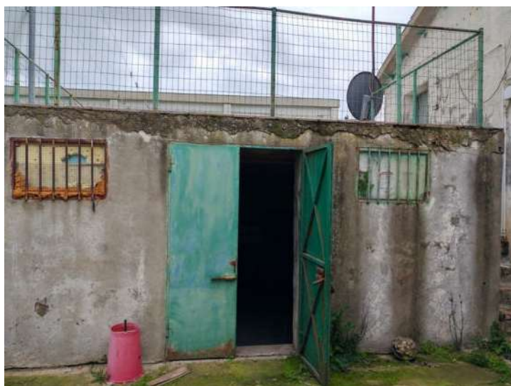
Foto n. 70 – Fg. 14 part. 538 sub 18 – Vista cantina
