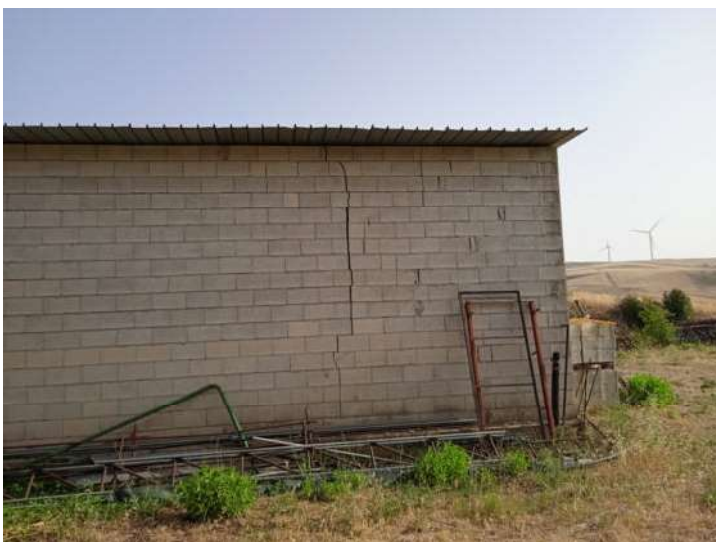
Foto n. 8 – Fg. 14 part. 798 - Vista esterna
