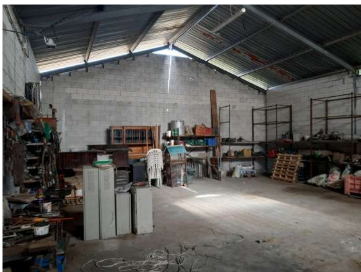
Foto n. 13 – Fg. 14 part. 798 - Vista interna
