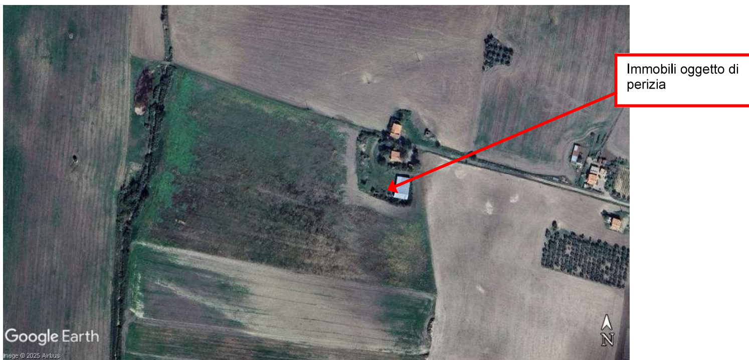
Foto n. 2 – Immobili siti in Melfi - Fg. 14 part. 798 - Vista aerea
