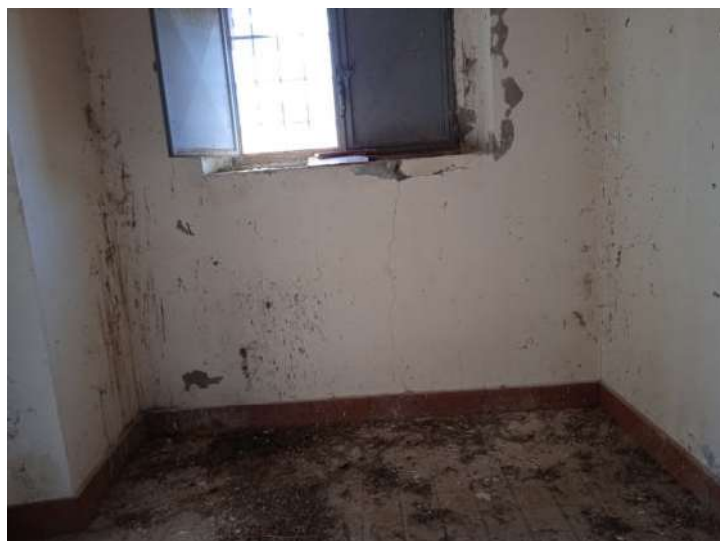
Foto n. 34 – Fg. 14 part. 811 sub 2 - Vista interna
