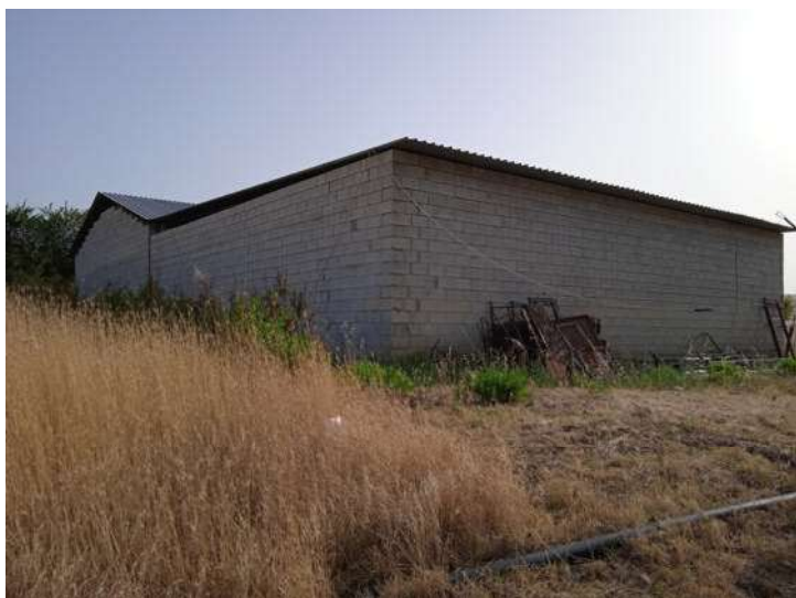
Foto n. 7 – Fg. 14 part. 798 - Vista esterna
