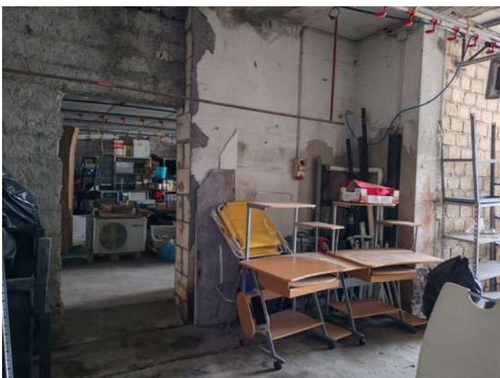
Foto n. 56 – Fg. 14 part. 538 sub 18 – Vista interna rimessa 1
