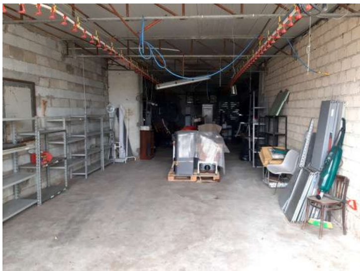
Foto n. 53 – Fg. 14 part. 538 sub 18 – Vista interna rimessa 2
