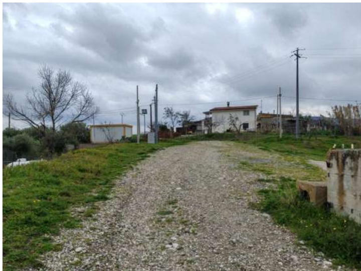
Foto n. 35 – Fg. 14 part. 538 – Strada di accesso
