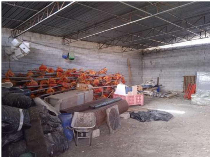
Foto n. 17 – Fg. 14 part. 798 - Vista interna
