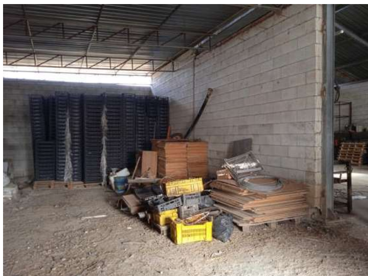
Foto n. 16 – Fg. 14 part. 798 - Vista interna
