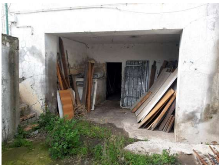
Foto n. 57 – Fg. 14 part. 538 sub 18 – Vista portico e deposito
