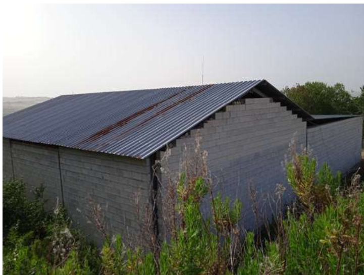
Foto n. 11 – Fg. 14 part. 798 - Vista esterna
