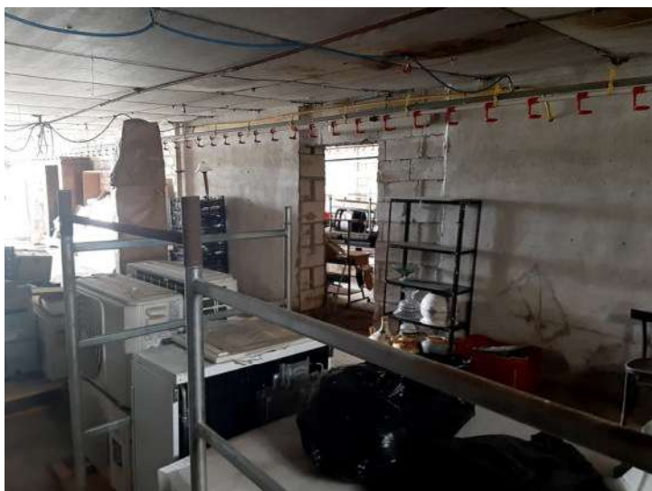
Foto n. 51 – Fg. 14 part. 538 sub 18 – Vista interna deposito-rimessa
