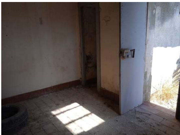
Foto n. 33 – Fg. 14 part. 811 sub 2 - Vista interna
