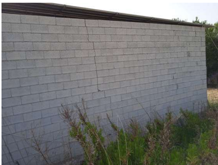
Foto n. 9 – Fg. 14 part. 798 - Vista esterna
