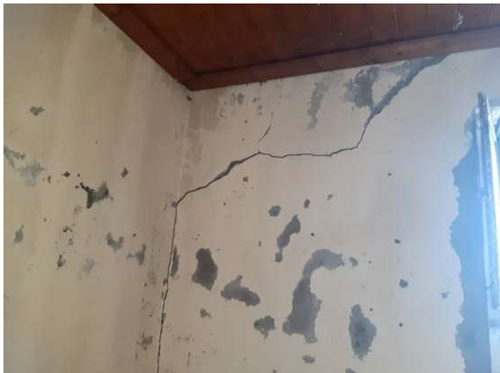
Foto n. 30 – Fg. 14 part. 811 sub 2 - Vista interna
