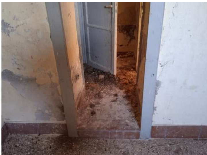
Foto n. 31 – Fg. 14 part. 811 sub 2 - Vista interna
