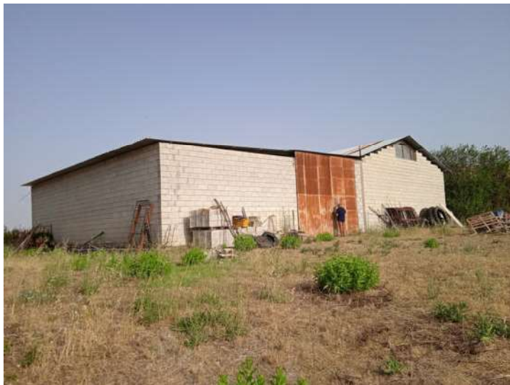
Foto n. 6 – Fg. 14 part. 798 - Vista esterna
