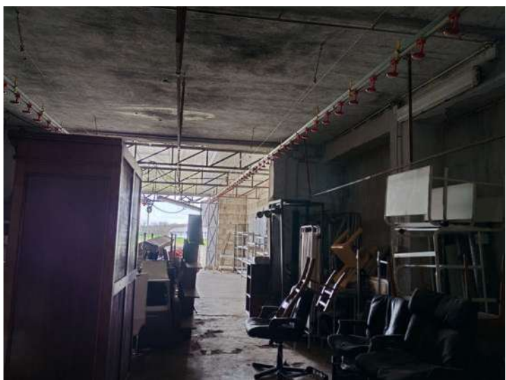
Foto n. 55 – Fg. 14 part. 538 sub 18 – Vista interna rimessa 1
