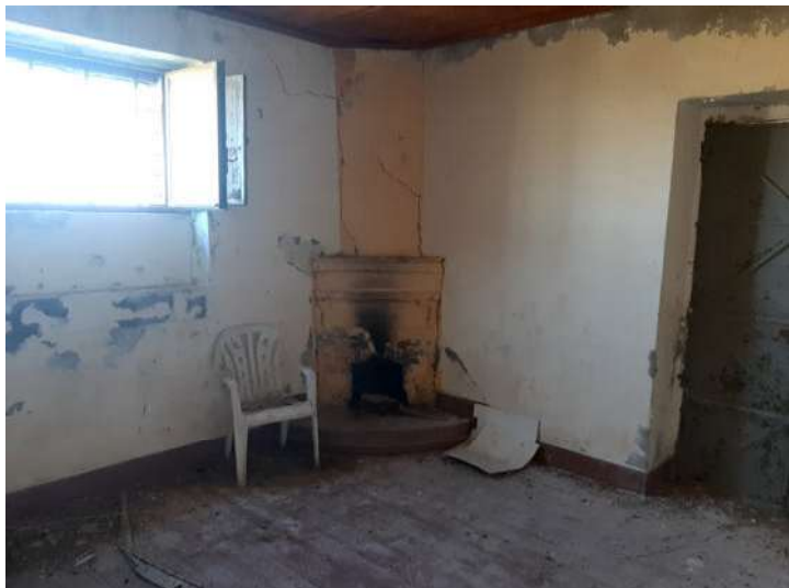
Foto n. 29 – Fg. 14 part. 811 sub 2 - Vista interna
