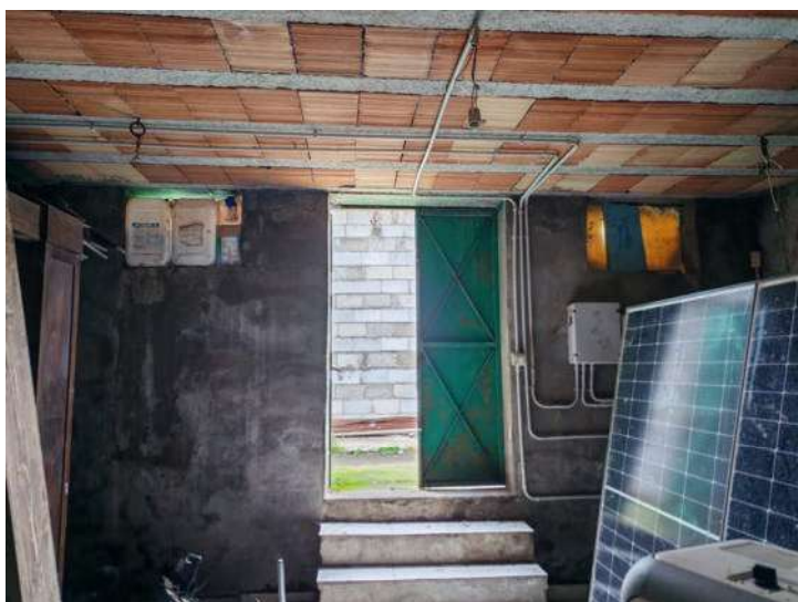
Foto n. 73 – Fg. 14 part. 538 sub 18 – Vista cantina
