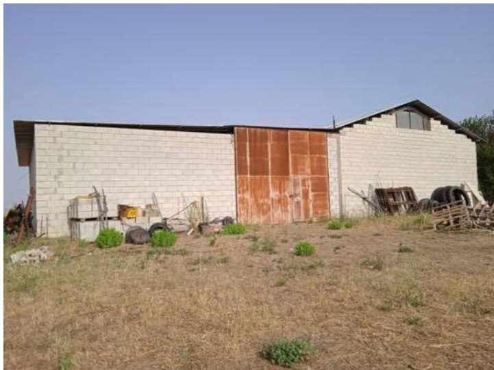
Foto n. 5 – Fg. 14 part. 798 - Vista esterna
