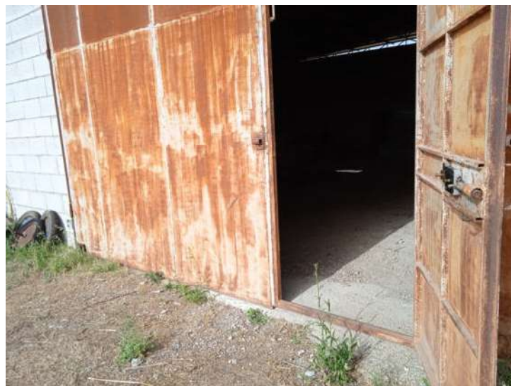
Foto n. 12 – Fg. 14 part. 798 - Vista esterna
