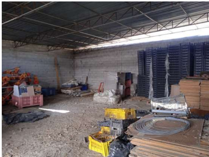
Foto n. 18 – Fg. 14 part. 798 - Vista interna
