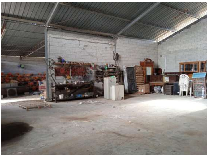
Foto n. 15 – Fg. 14 part. 798 - Vista interna
