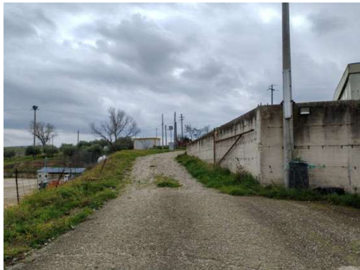
Foto n. 36 – Fg. 14 part. 538 – Strada di accesso
