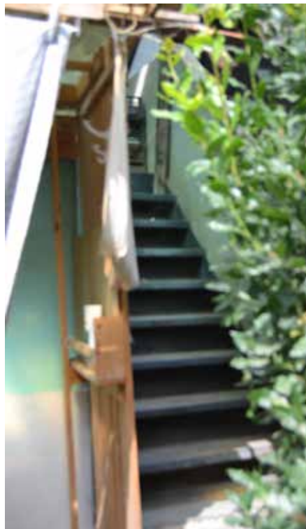
Scala di accesso al P.1
