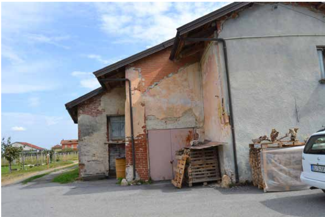
Vista Lato ovest_ particolare cantina e ripostiglio
