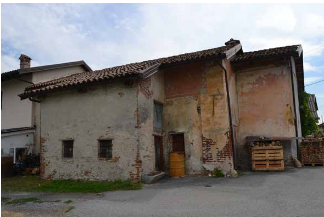
Vista lato nord
