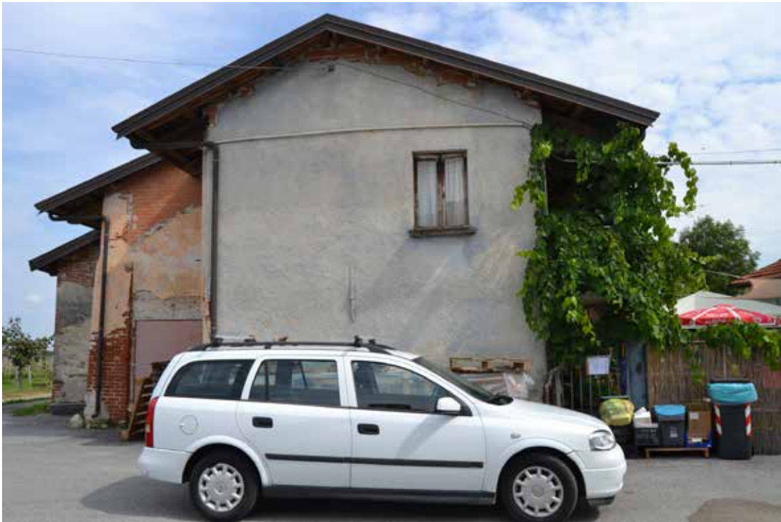
Vista Lato ovest
