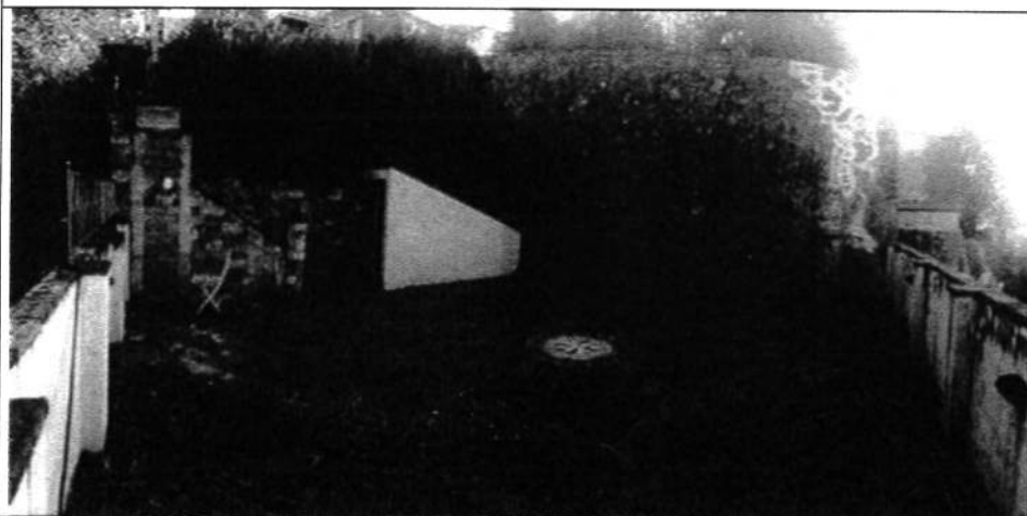
Foto n. 16: Vista terrazza soprastante il garage
