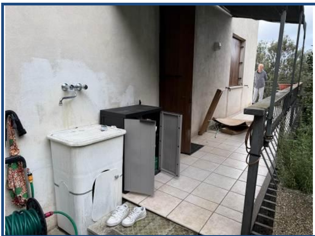
Foto 38 – Vista terrazzo al piano terra.
