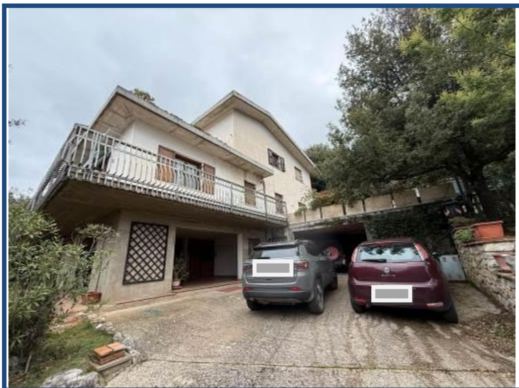
Foto 2 - Vista esterna del fabbricato.
