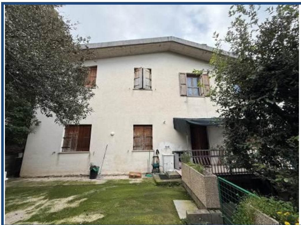
Foto 4 – Vista esterna del fabbricato.
