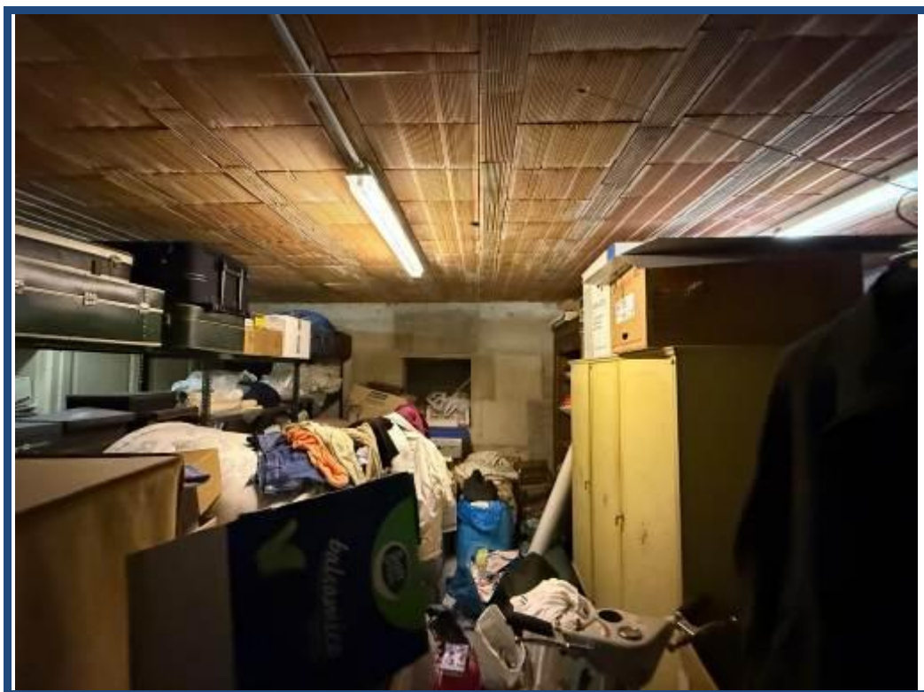
Foto 45 – Vista interna fondo piano seminterrato – sub. 3
