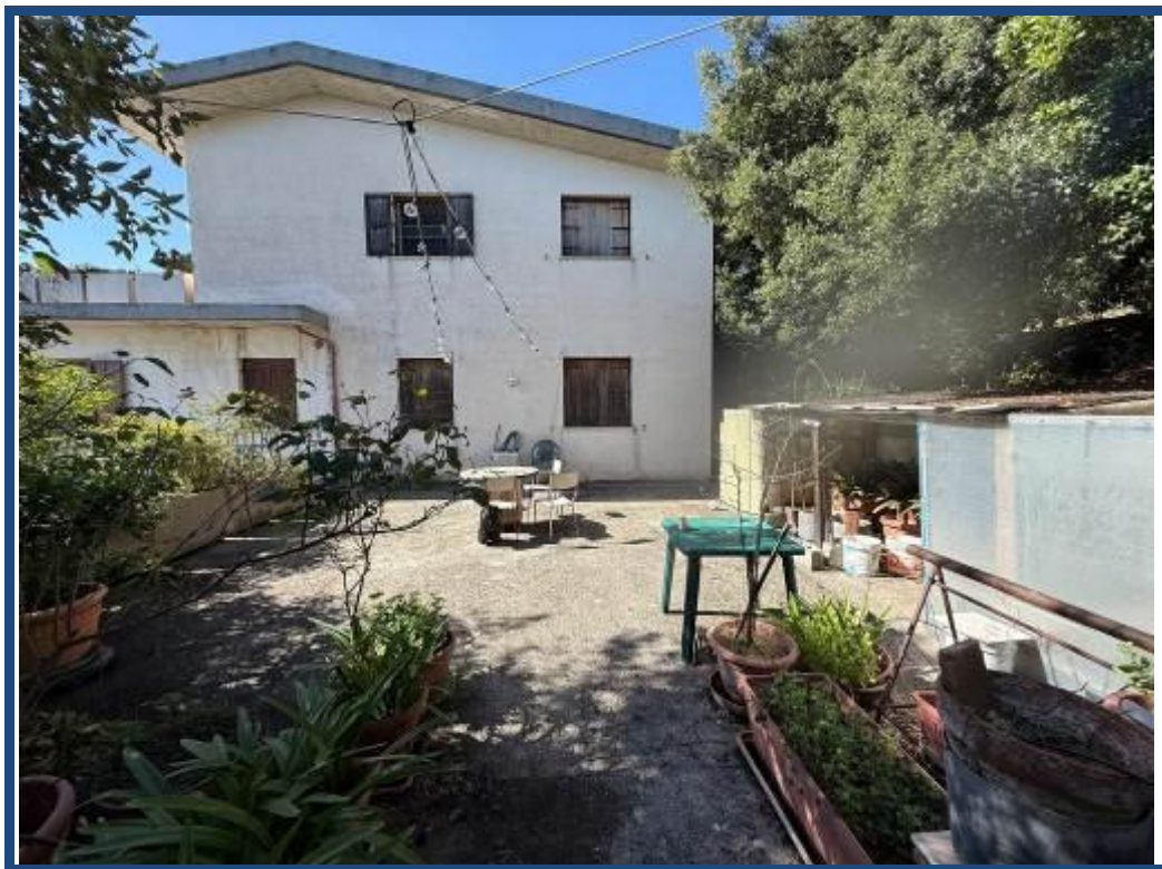
Foto 3 – Vista esterna del fabbricato.
