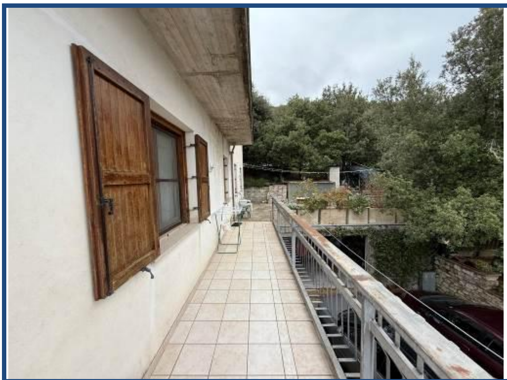
Foto 31 – Vista terrazzo al piano terra.
