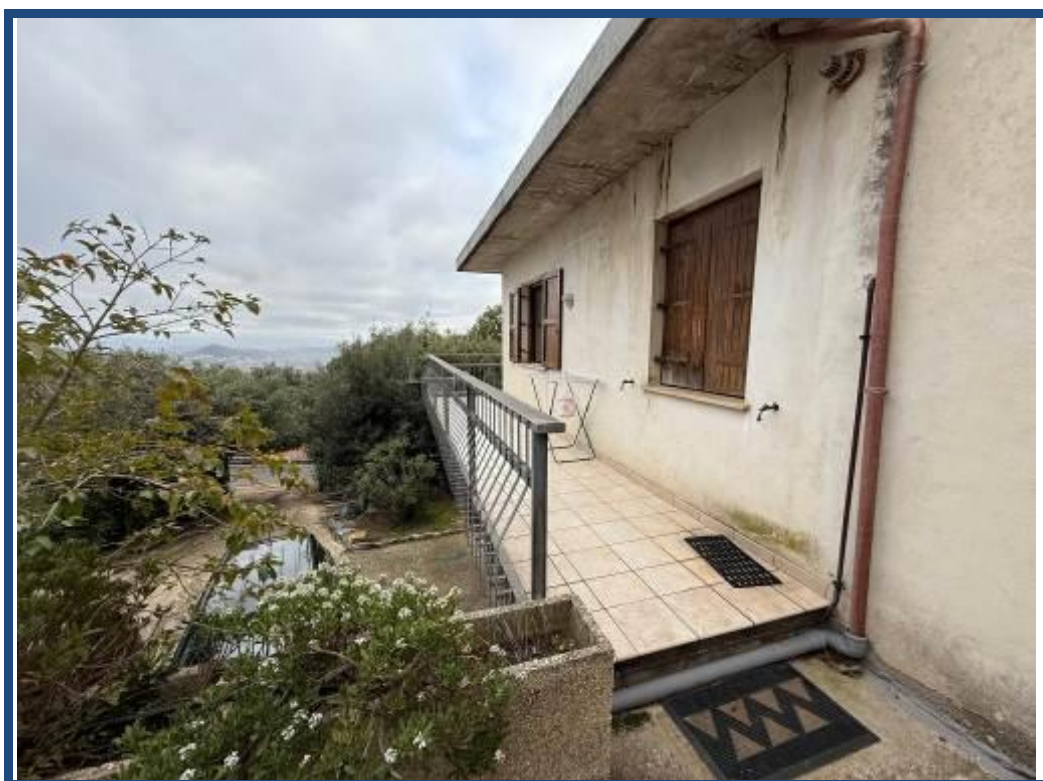
Foto 32 – Vista terrazzo al piano terra.
