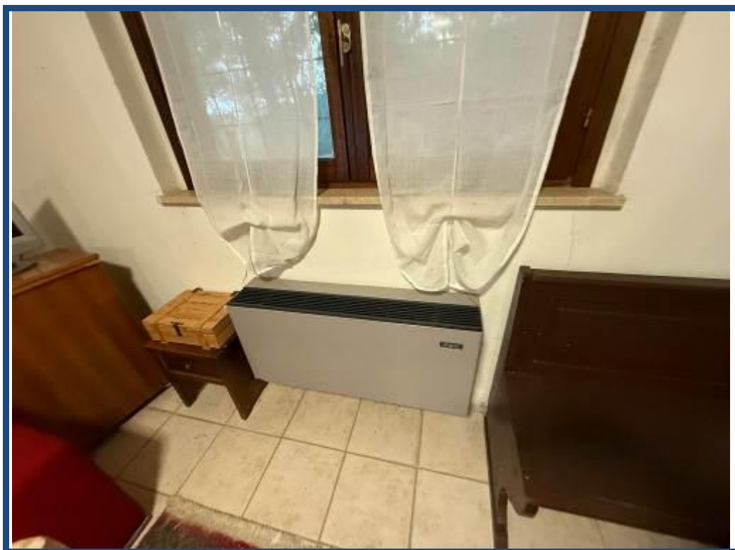
Foto 43 – Vista interna fondo piano seminterrato – sub. 3
