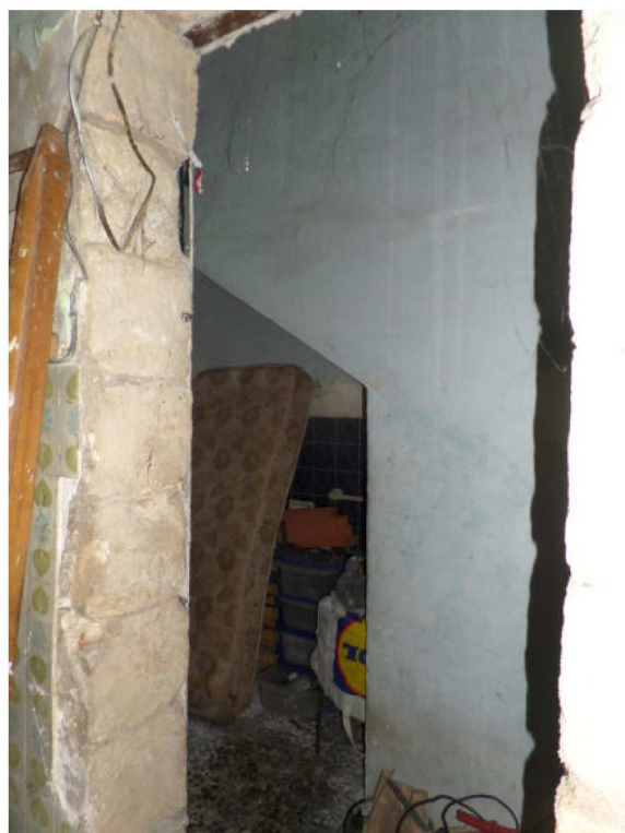
Foto n° 2.3. P. T.: Vano laterale (bagno)
