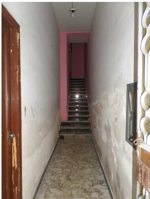
Foto n° 1.1. P. T.: Ingresso
