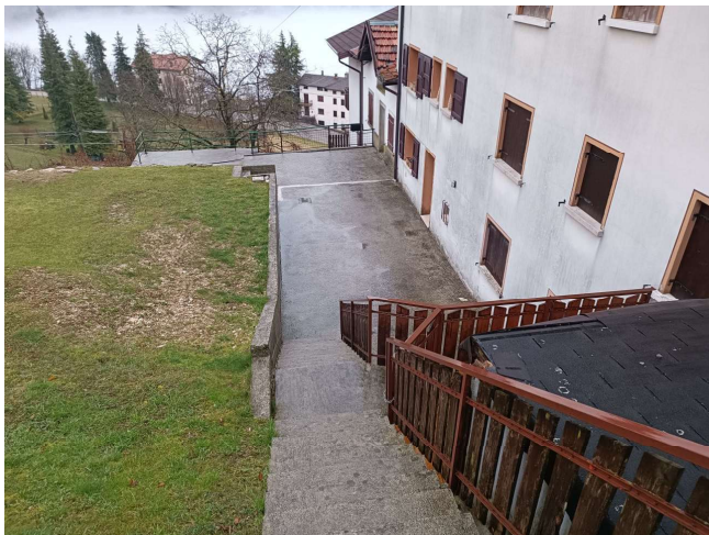
Vista terreni lato nord "Lotto 2"
