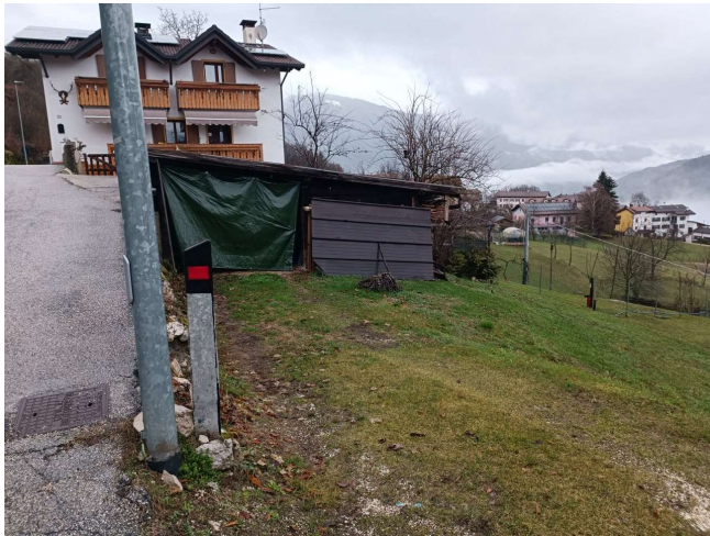
Vista annesso lato nord su m.n.°434 "Lotto 1"
