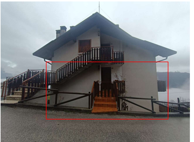
Vista da via Fosse di Sopra ingresso "Lotto 1"
