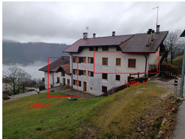
Vista retro da via Fosse di Sopra
