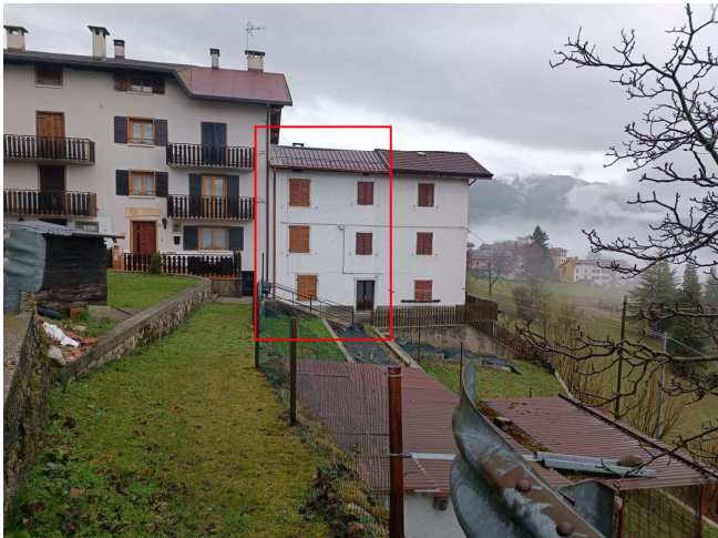
Vista fronte da via Fosse di Sopra "Lotto 2"
