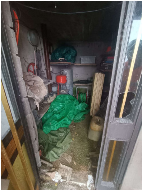
Vista interna cantina "Lotto 1"
