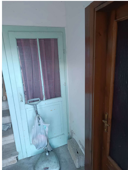
Vista interna "Lotto 2" – Scala comune
