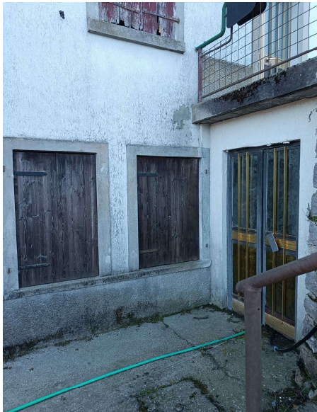
Vista ingresso lato nord abitazione "Lotto 2"
