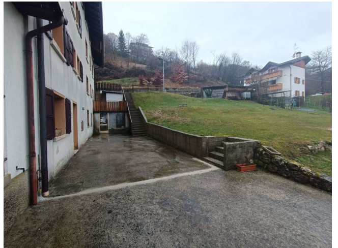
Vista terreni lato nord "Lotto 1"
