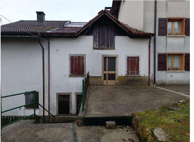
Vista lato nord abitazione "Lotto 2"
