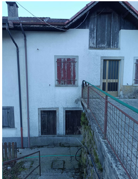
Vista lato nord abitazione "Lotto 2"
