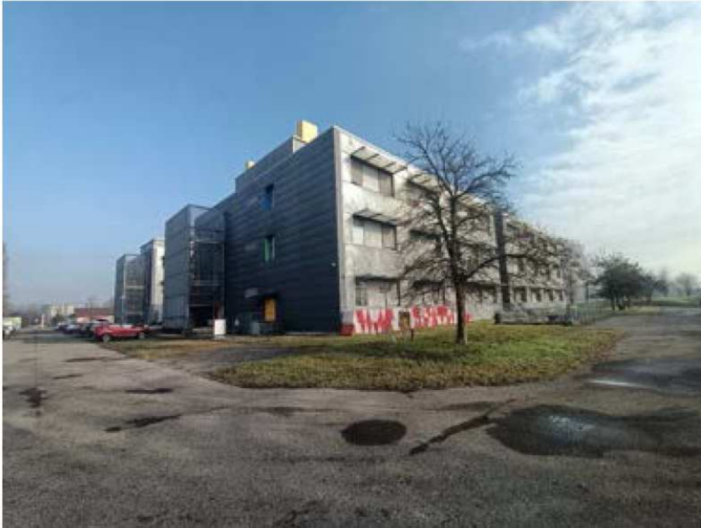
Foto 3 - Vista sud-ovest - parcheggio
