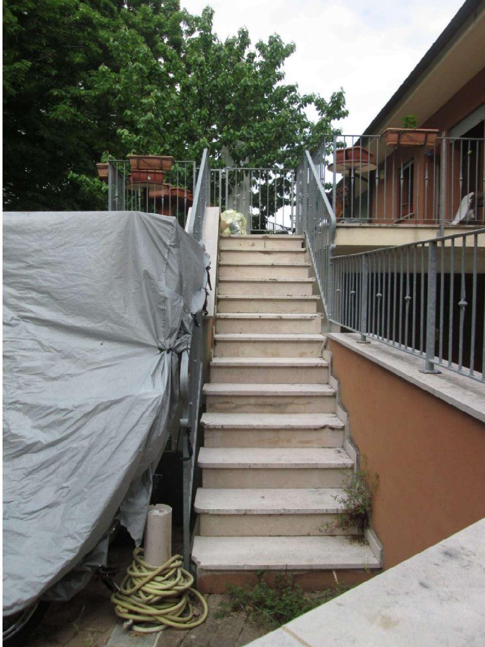
Scala esterna- per accedere all'alloggio-
