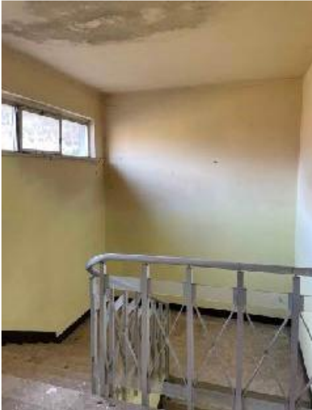
Fig. 29 - vano scale accesso appartamento del custode ed uscita dell'Ex Cinematografo al piano primo
