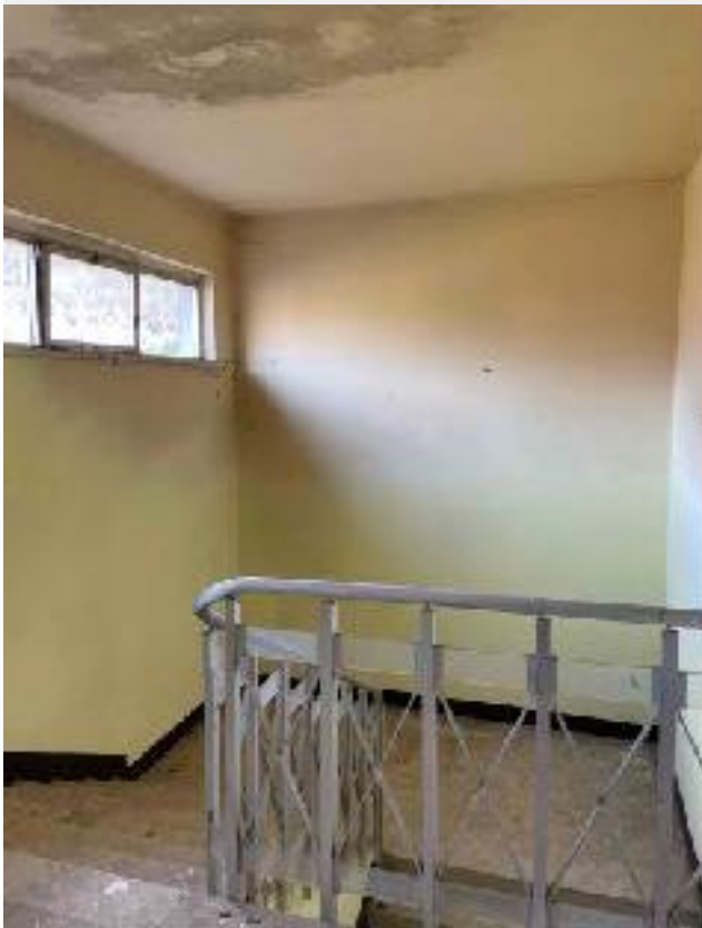
Fig. 3 - Vano scale comune appartamento custode ed Ex cinematografo
