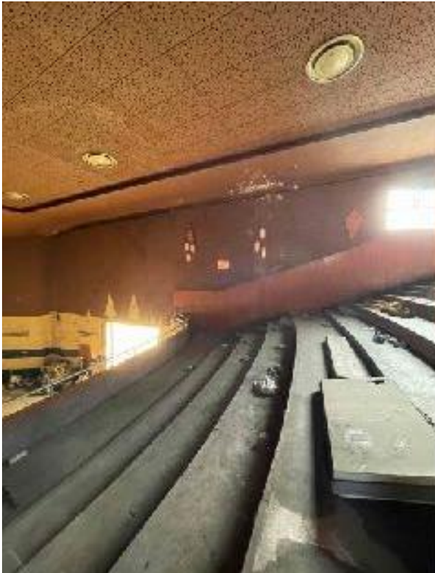
Fig. 25 - Porzione a gradoni al piano primo
