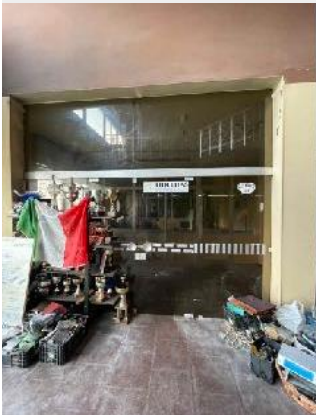
Fig. 3 - Uffici Vista dalla hall dell'ex cinematografo verso l'accesso degli Uffici
