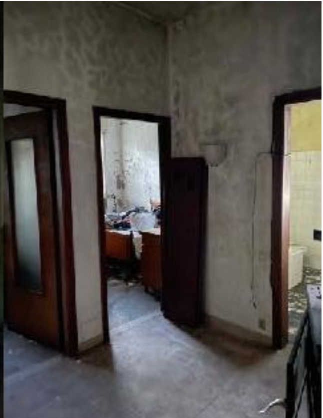
Fig. 14 - Disimpegno altra vista
