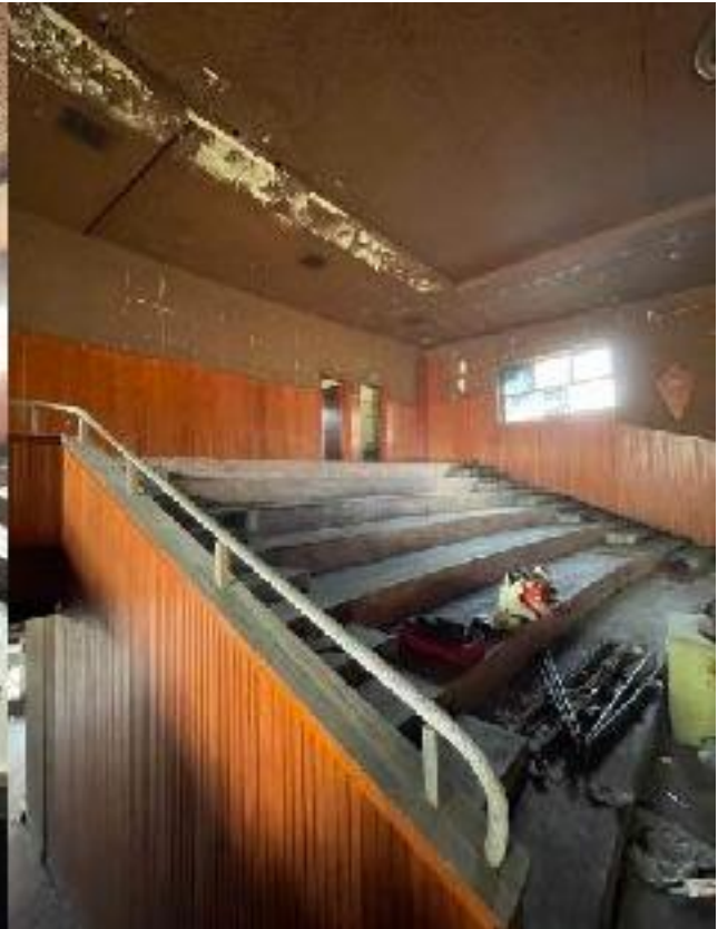
Fig. 26 - Porzione a gradoni al piano primo altra vista
