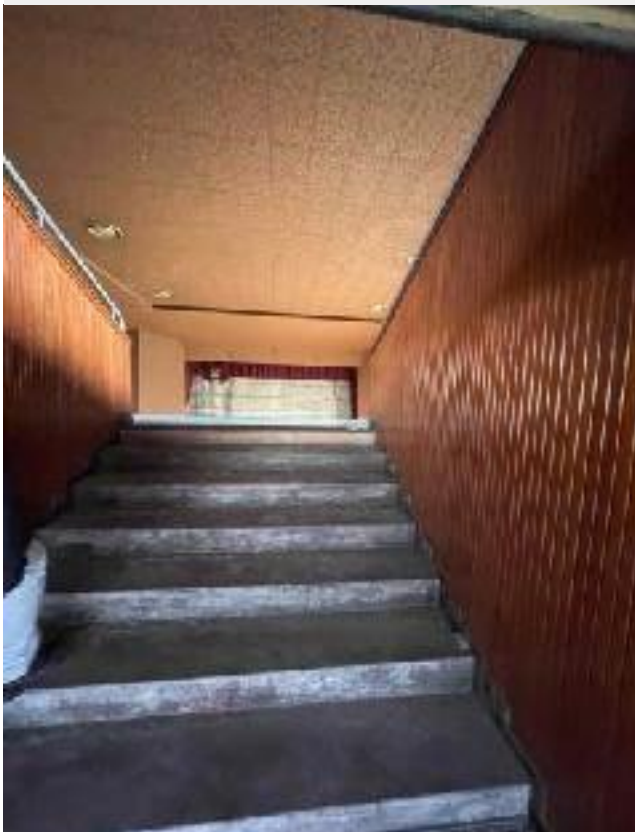
Fig. 23 - Porzione al piano primo
