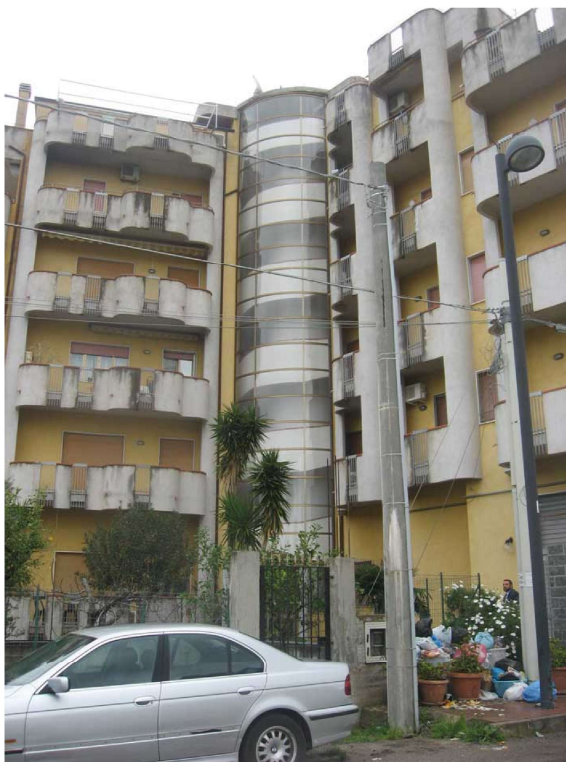
Foto N° 2 Unità immobiliare in Via Tasca 26– Fl 8 part.Ila 155 sub 25 - Prospetto Esterno
