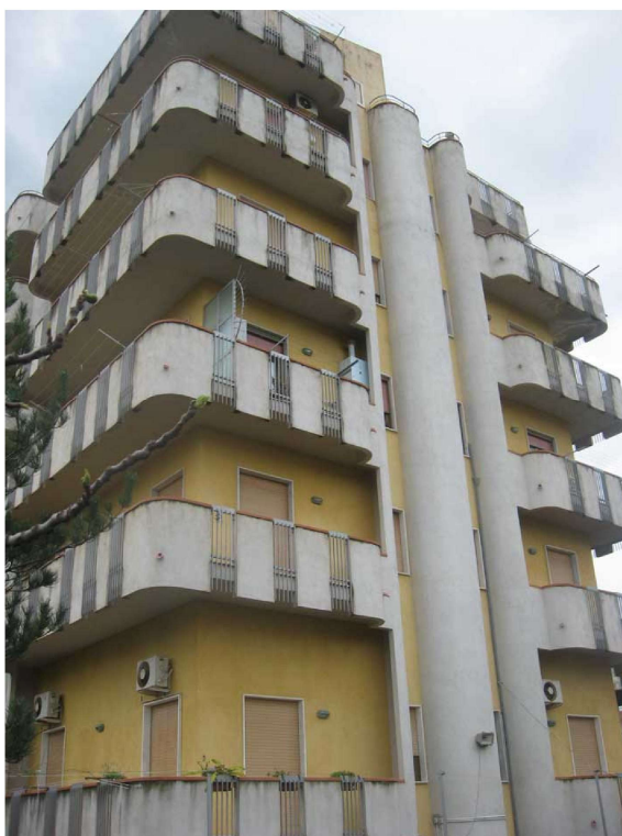
Foto N° 1 Unità immobiliare in Via Tasca 26– Fl 8 part.Ila 155 sub 25 - Prospetto Esterno
