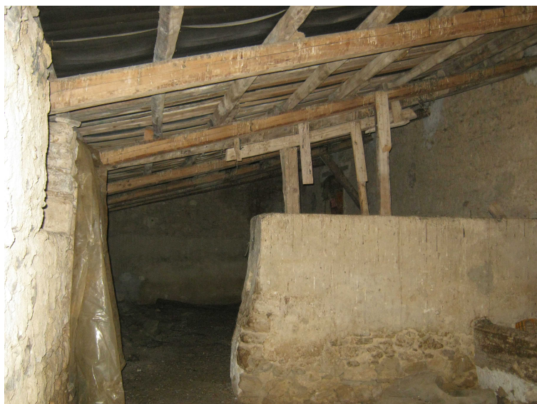
FOTO 31 – Interno deposito – stalla. Cortile 3
