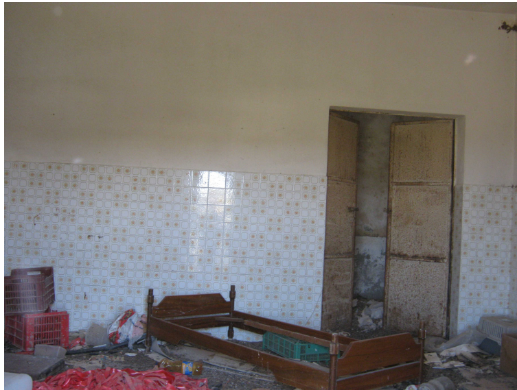
FOTO 19 – Interno deposito, part. 265 sub.1.
