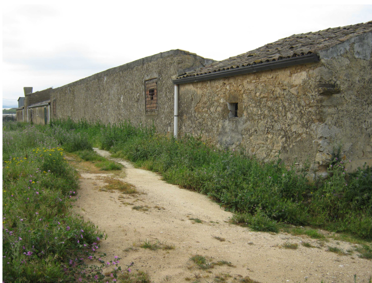
FOTO 30 – Deposito – stalla e porcile. Prospetto Nord.
