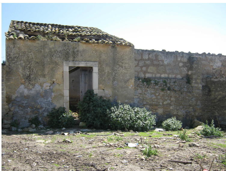
FOTO 24 – Deposito-porcile prospetto ovest. Corte3.
