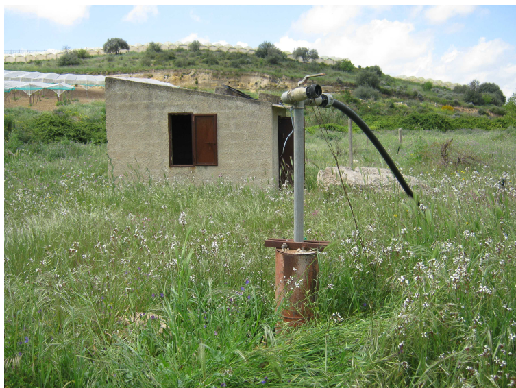
FOTO 37 – Pozzo trivellato -Casetta deposito e quadro comandi – part. 192.
