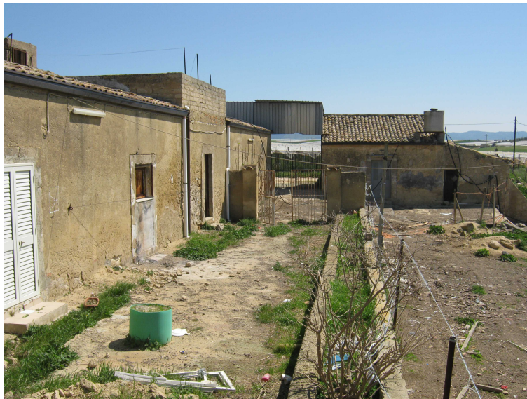
FOTO 17 – Corte 2, deposito e ufficio, part. 265 sub. 1. Prospetto sud.
