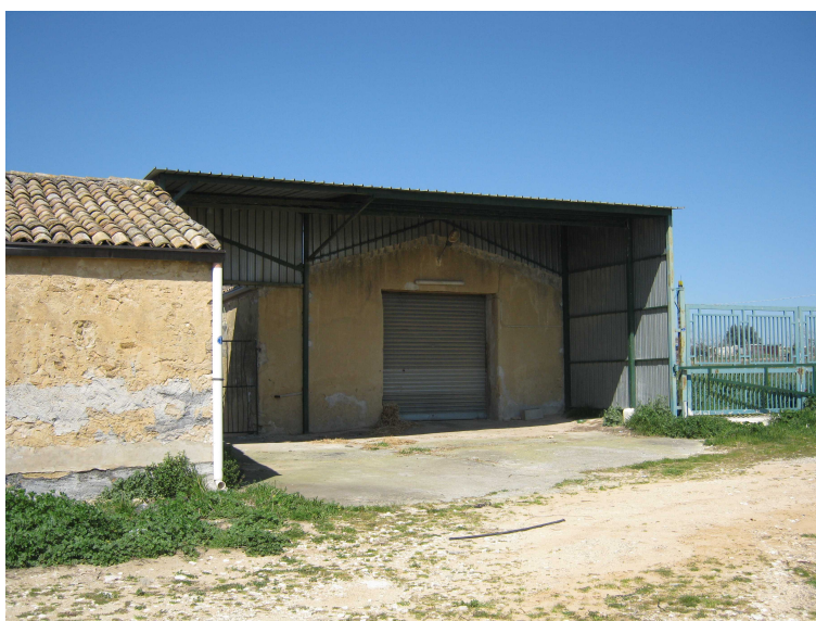
FOTO 9 – Accesso al fondo, cancello, tettoia, deposito macchine.
