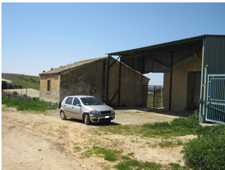
FOTO 10 – Accesso al fondo, cancelli, abitazione part. 265 sub 2, tettoia, deposito macchine.
