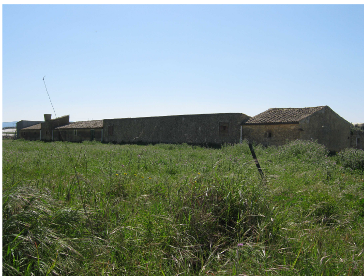
FOTO 5 – Caseggiato lato Nord.
