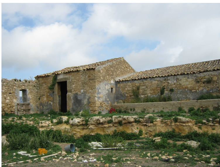
FOTO 29 – Deposito – stalla e porcile. Cortile 3
