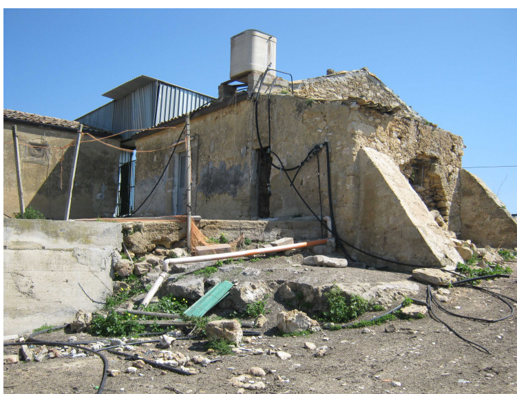
FOTO 12 – Fabbricato ad uso abitazione, part. 265 sub. 2, prospetto Sud-Ovest.
