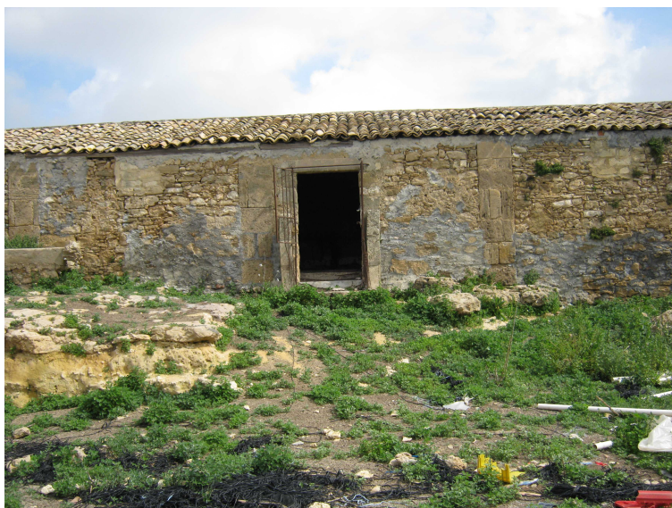
FOTO 28 – Deposito – stalla. Cortile 3
