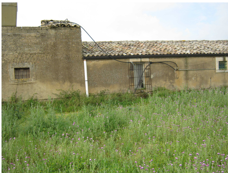
FOTO 18 – Deposito e ufficio, part. 265 sub. 1. Prospetto nord.
