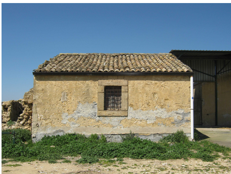
FOTO 11 – Fabbricato ad uso abitazione, part. 265 sub. 2, prospetto Est.
