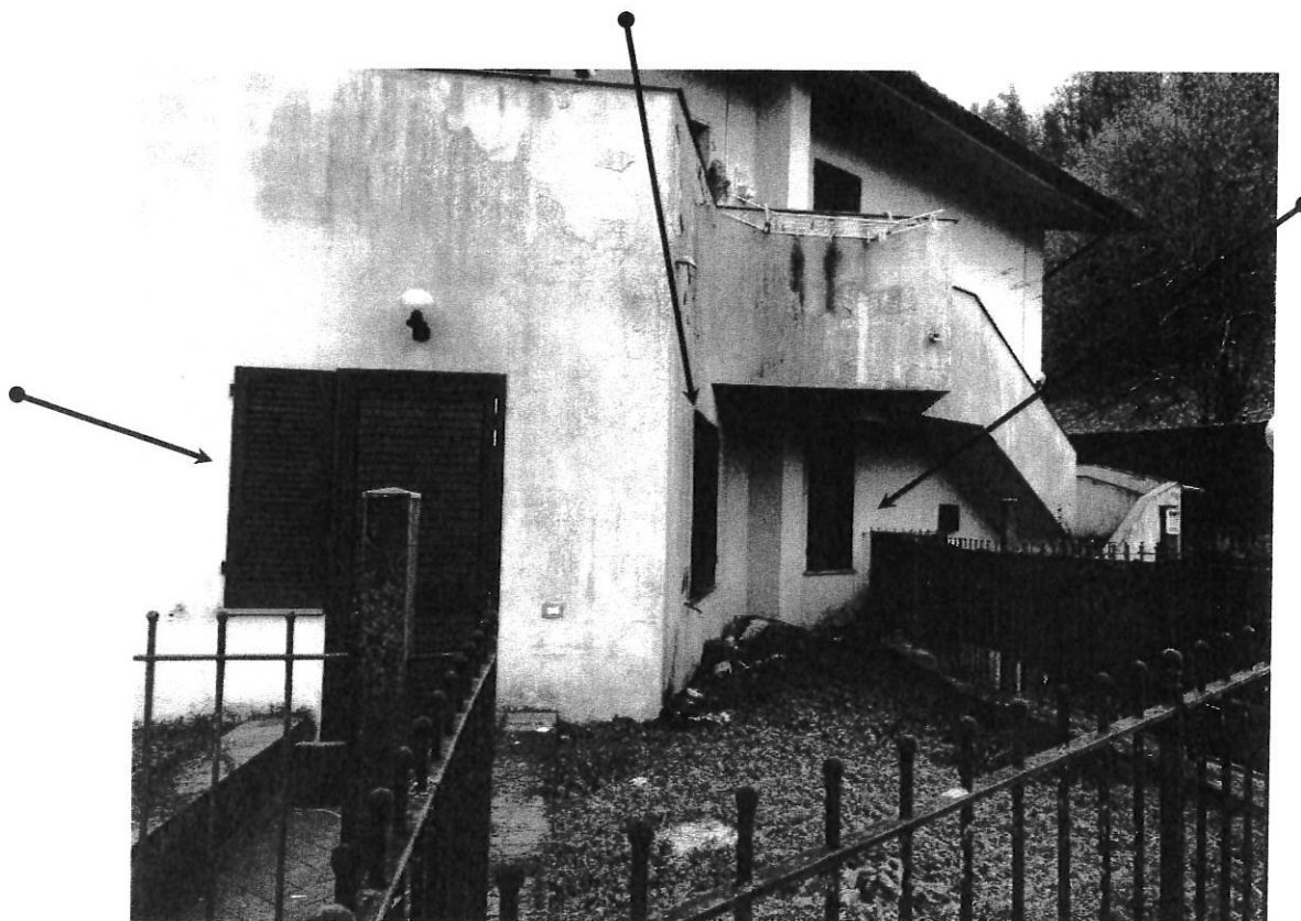
Foto 6 – Lato Ovest – porta d'ingresso e finestre ingresso e bagno con affaccio sulla porzione di resede esclusiva
