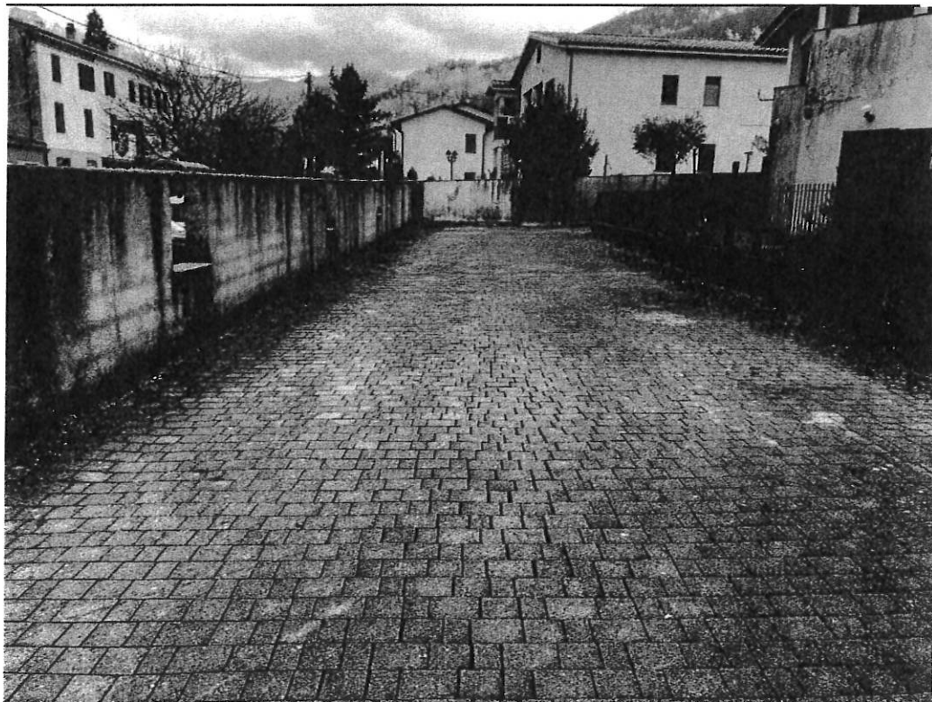
Foto 21 – piazzale condominiale antistante il fabbricato lato nord – porzione del sub. 7
