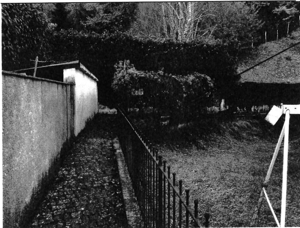
Foto 24 – camminamenti interni nel resede condominiale porzione del sub. 7 lungo il confine lato est – particolare angolo sud-est ove è posto il deposito interrato gas gpl a servizio delle singole abitazioni
