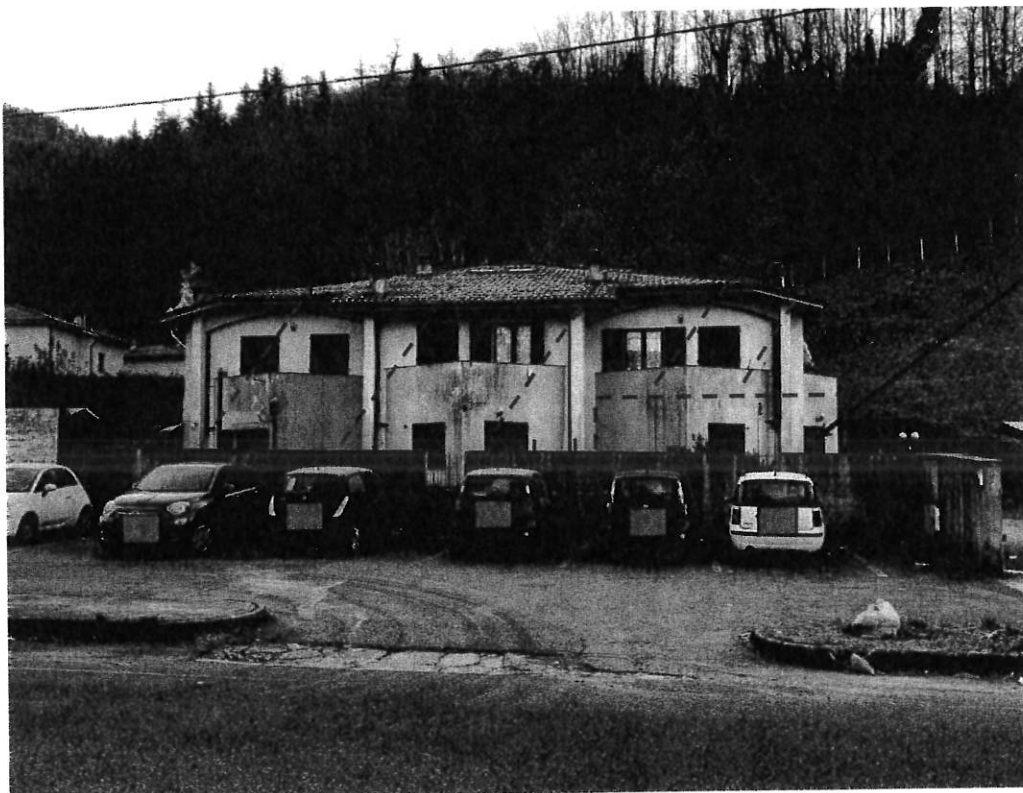
Foto 1 – Lato Nord - Vista dalla strada pubblica Via Fabbriche vista fabbricato e parcheggio pubblico esterno lato strada la freccia indica la porta d'ingresso all'unità abitativa
