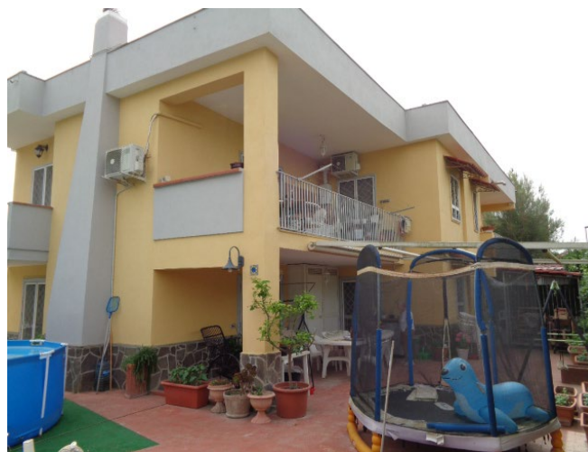
Veduta del fabbricato da area scoperta del lotto
