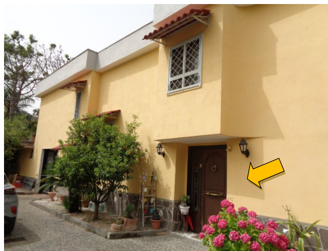
Accesso al portoncino d'ingresso che conduce al vano scala
