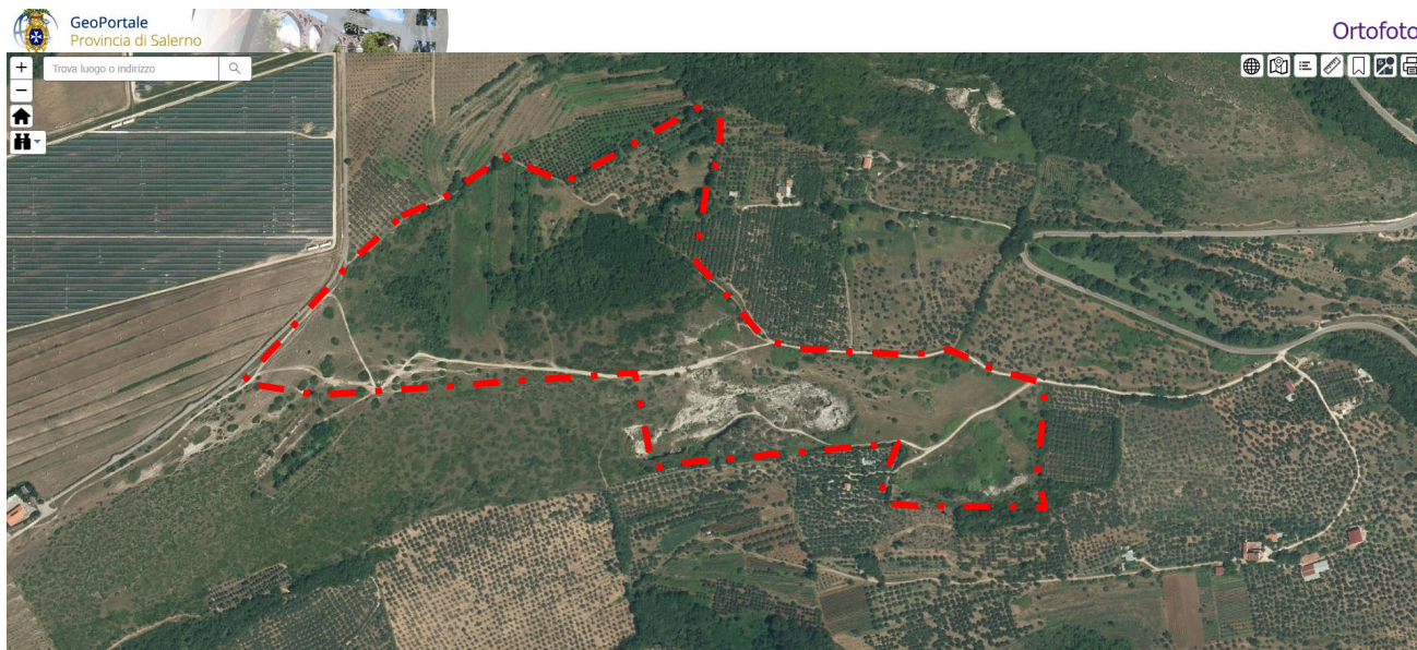
Fig. 3: ortofoto di inquadramento di dettaglio, con individuazione dei terreni agricoli che identificano il Lotto Uno esecutato sito nel comune di Eboli. Si noti il carattere in parte arborato in parte tenuto a prati e seminativi, con area di cava dismessa e strade interpoderali interne che caratterizzano il compendio esecutato (fonte: Geoportale della Provincia di Salerno).
