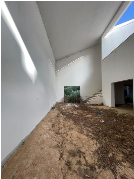
LO SBARCO DELLA SCALA AL PIANO
