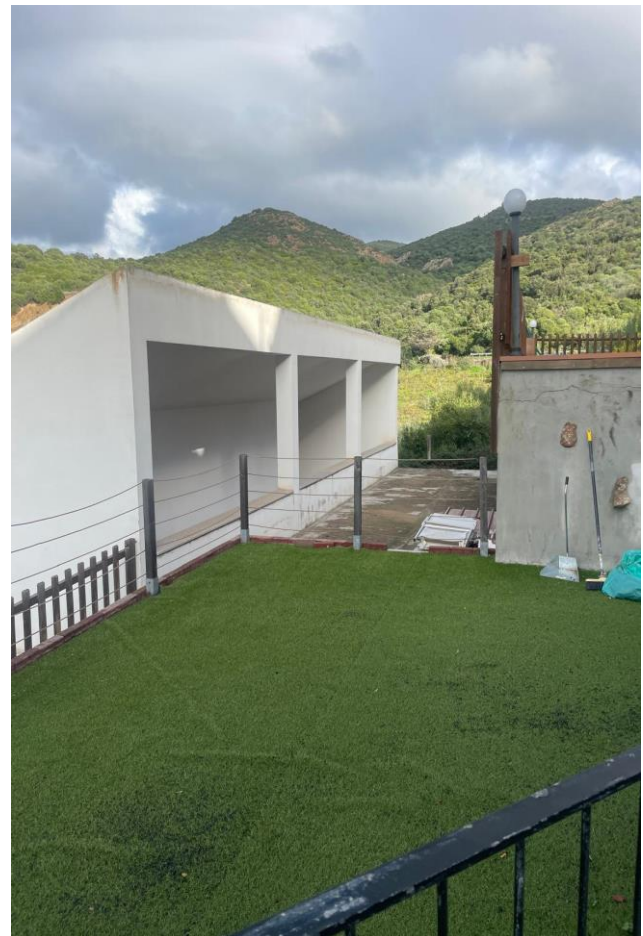
VISTA DELL'AFFACCIO AL PIANO INFERIORE
