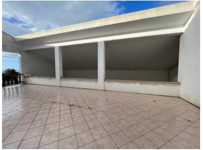
LA BALCONATA CHE AFFACCIA SUL PIANO TERRA
