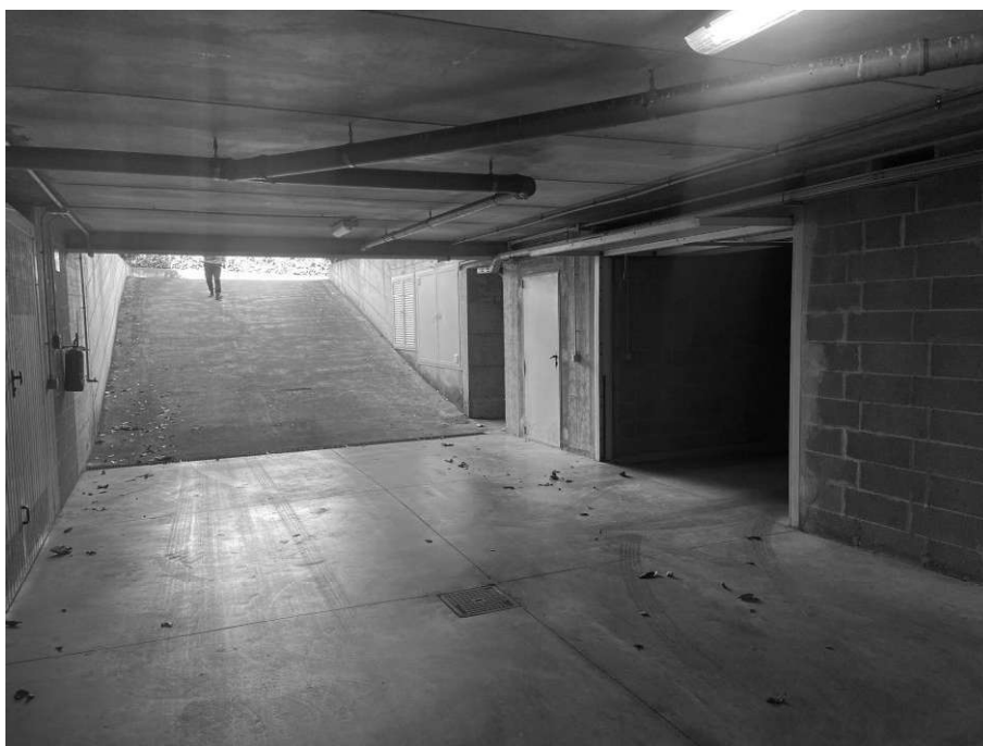
Foto n.2 – Fg. 159 part. 378 sub 34 (corsia di manovra garage - P.S1)
