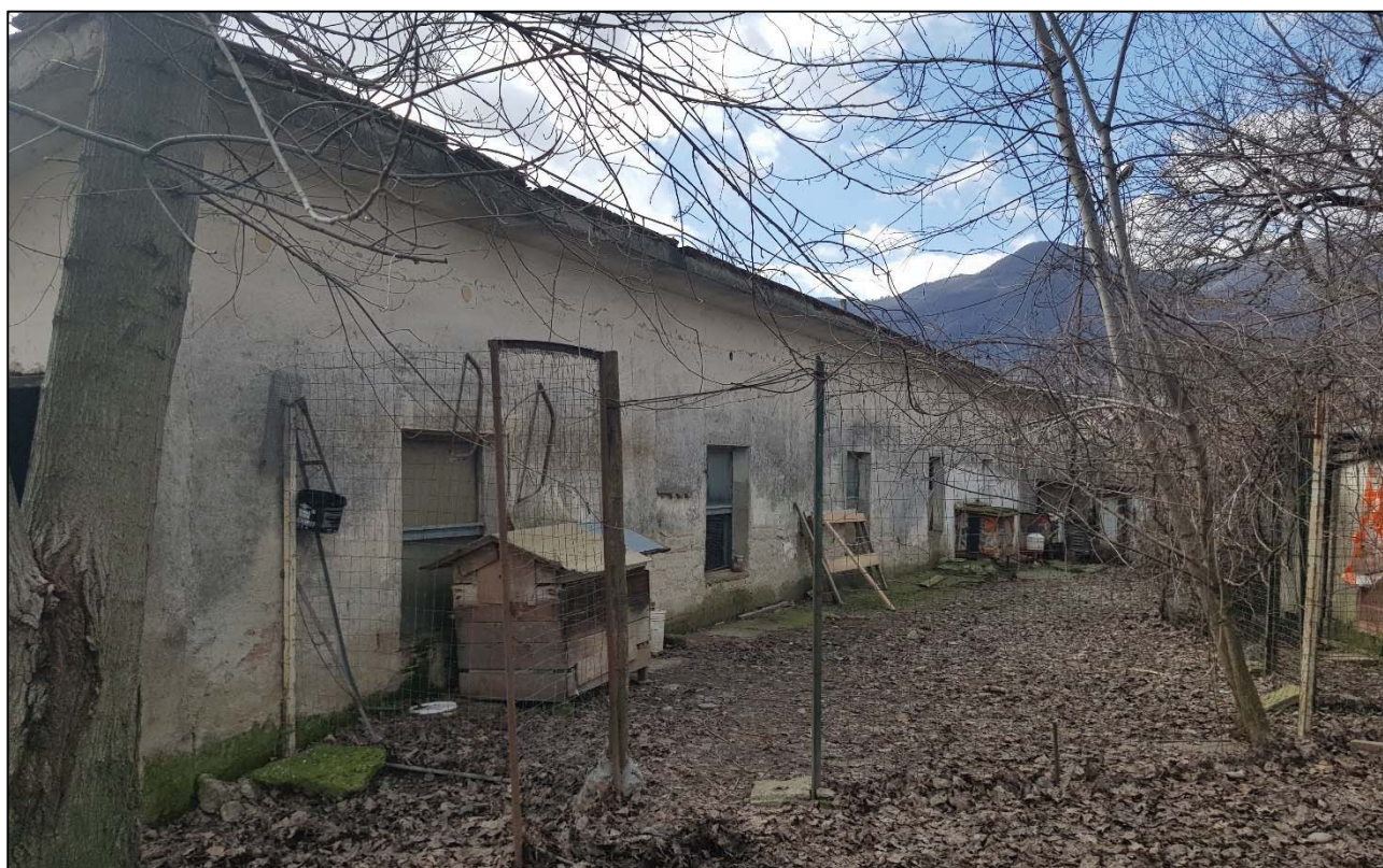
Fig. 21 – Immagine del prospetto principale della stalla difforme da quello previsto in progetto
