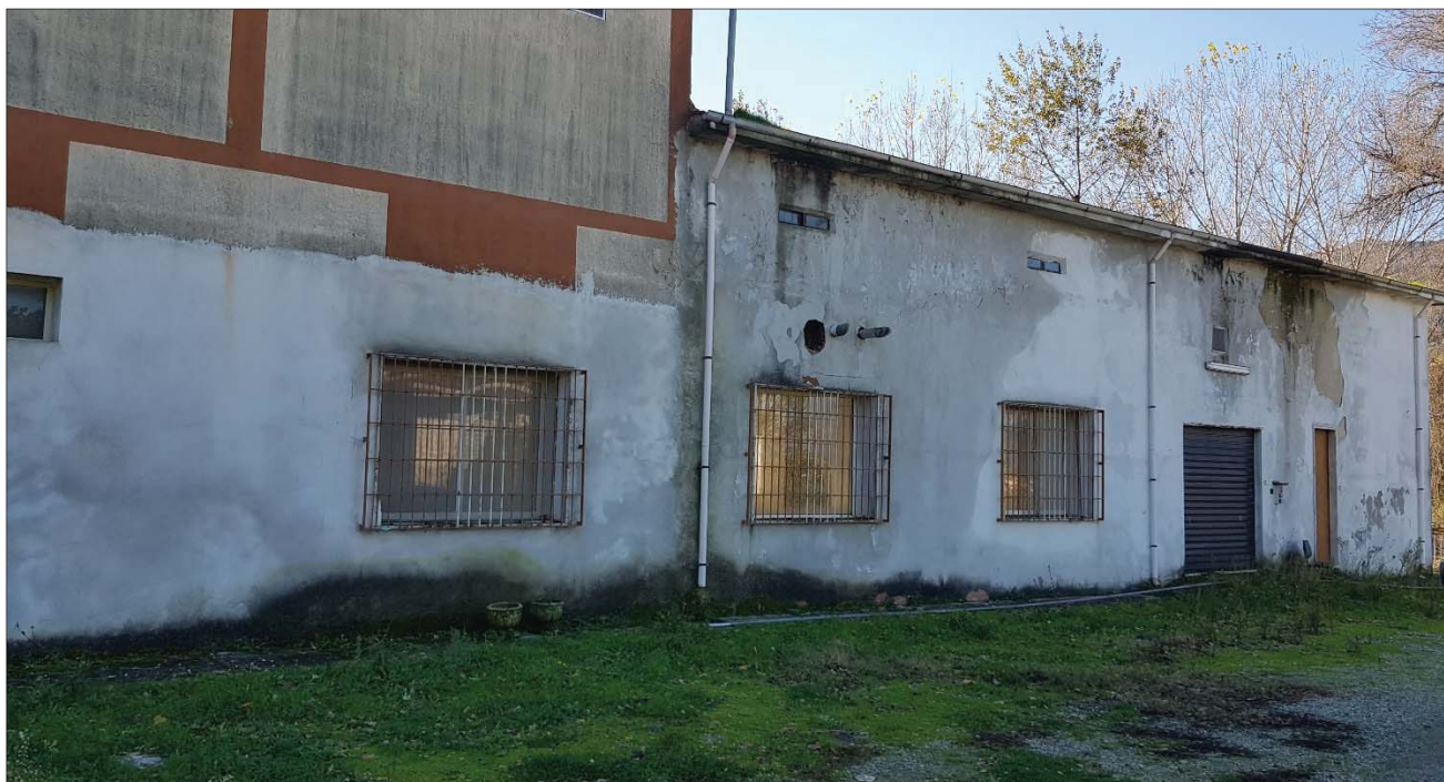
Fig. 4 – Foto Esterni Sub 3
