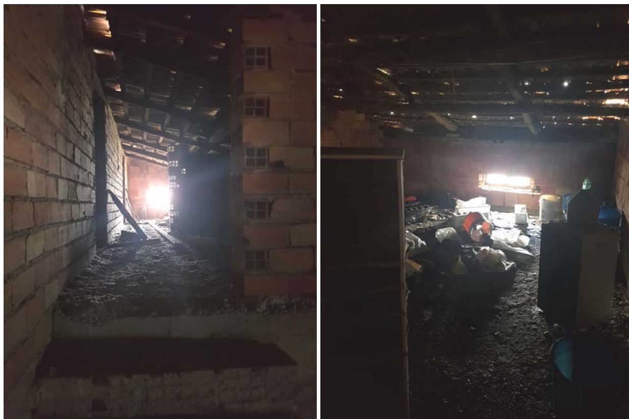
Fig. 10 – Foto degli interni-Piano Primo
