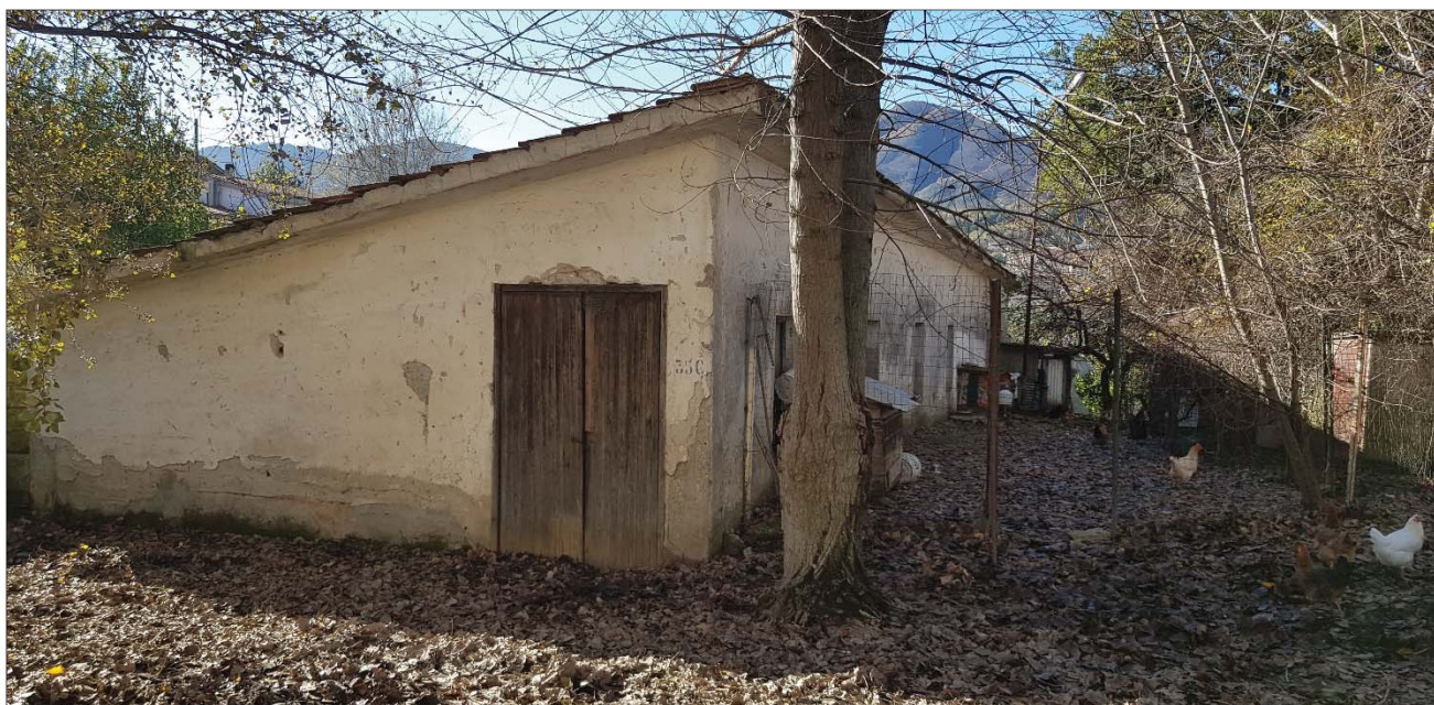
Fig. 5 – Foto Esterni Sub 2
