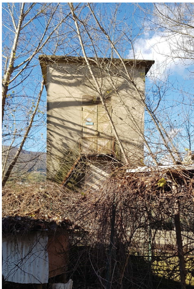
Fig. 6 – Foto Esterni Sub 4
