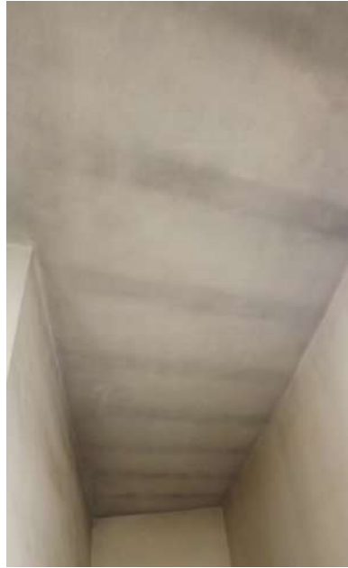
Foto 49-50_ Viste d’insieme della rampa di scala che dal piano ammezzato conduce al pianerottolo del primo piano, che a sua volta consente l’accesso all’appartamento. Le immagini evidenziano macchie/alonature diffuse all’intradosso del solaio, compatibili con umidità e rappezi.
