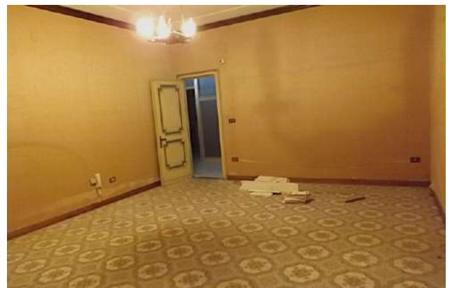
Foto 74-75_ Viste d’insieme dell’originaria camera da letto, ampia, con doppia esposizione e 2 porte-finestra pavimento in piastrelle decorate. Stato manutentivo mediocre: tappezzerie localmente distaccate e macchiate, aloni sulle pareti/soffitto e finiture datate
