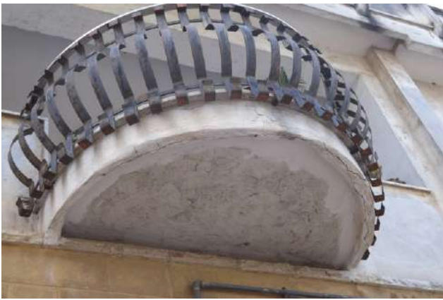
Foto 11-12_ Dettagli del sottobalcone: crepe perimetrali, finitura degradata e ossidazione dei ferri della ringhiera; evidenze di mancata manutenzione
