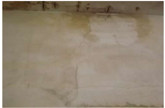
Foto da 35 a 40_Viste di dettaglio del solaio e murature del locale deposito: intradosso in laterocemento con travetti in c.a. con estese alonature da umidità/infiltrazioni, fessurazioni longitudinali (anche in corrispondenza degli appoggi alle pareti), distacchi di finitura e locale degrado del copriferro. Sulle murature sono presenti lesioni e microfessurazioni in più punti, a prevalente andamento verticale/obliquo (anche presso il nodo solaio-parete), con aloni e scrostature diffuse.
