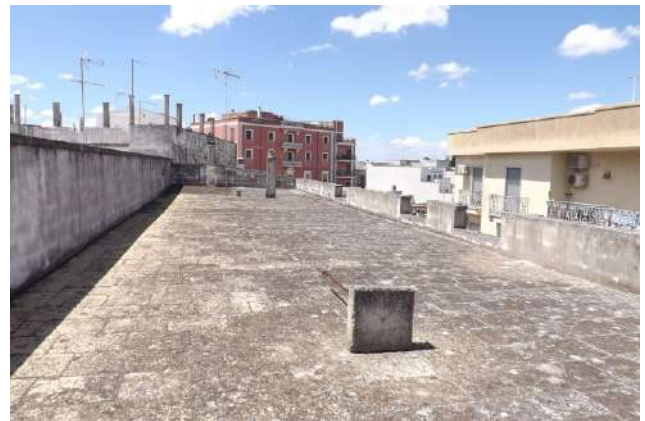
Foto 96_ Viste d’insieme del lastrico solare, con pavimentazione in chianche.
