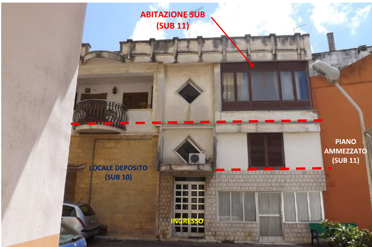
Foto 6_ Vista d'insieme di porzione del prospetto principale (nord-ovest). Si distinguono il portone di ingresso e l'area interessata dal piano ammezzato
