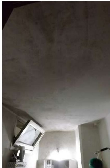
Foto 20-21-22_ Viste d’insieme del bagno di servizio di modeste dimensioni, rivestimento ceramico fino a mezza altezza, aerazione naturale con finestra a vasistas; finiture datate. Aloni/micro-muffe da condensa su pareti e soffitto; scaldacqua elettrico con collegamenti a vista.
