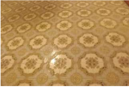
Foto 76-77-78_ Dettagli della camera da letto: pavimentazione in piastrelle ceramiche decorate di buon livello; pareti rifinite con carta da parat, in più punti scollata e macchiata, con evidenti segni di umidità alla base in corrispondenza della portafinestra; infisso a portafinestra in legno laccato avorio; soffitto intonacato con cornici perimetrali, interessato da aloni e leggere fessurazioni.
