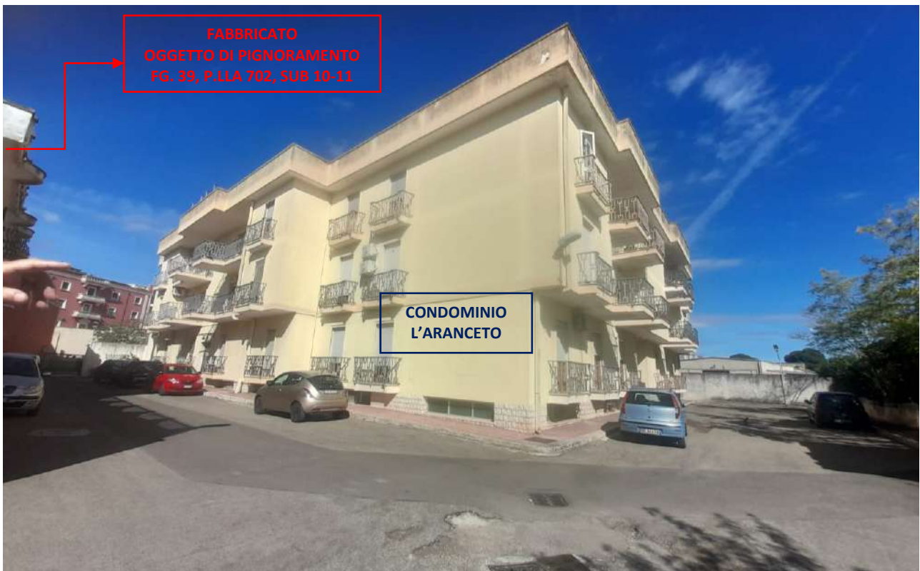
Foto 5_ Altra vista d'insieme dell'area privata nella quale sono ubicati sia il fabbricato oggetto di espropriazione forzata, che il complesso condominiale denominato "L'Aranceto".
