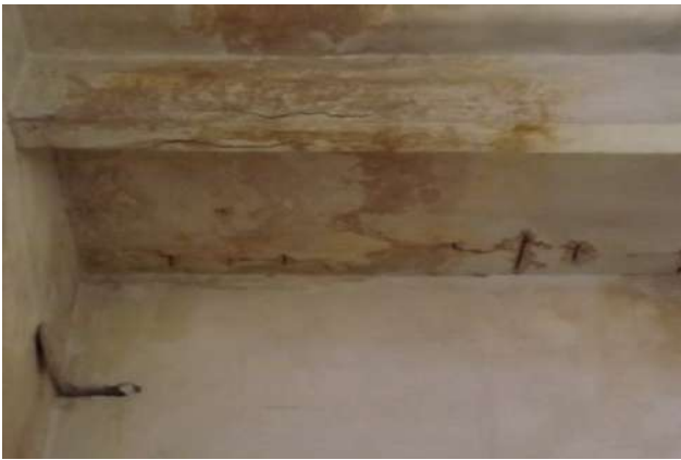
Foto da 35 a 40_Viste di dettaglio del solaio e murature del locale deposito: intradosso in laterocemento con travetti in c.a. con estese alonature da umidità/infiltrazioni, fessurazioni longitudinali (anche in corrispondenza degli appoggi alle pareti), distacchi di finitura e locale degrado del copriferro. Sulle murature sono presenti lesioni e microfessurazioni in più punti, a prevalente andamento verticale/obliquo (anche presso il nodo solaio-parete), con aloni e scrostature diffuse.
