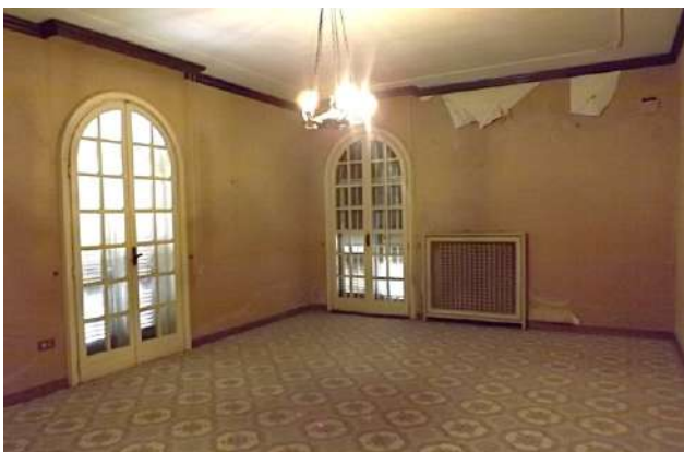
Foto 74-75_ Viste d’insieme dell’originaria camera da letto, ampia, con doppia esposizione e 2 porte-finestra pavimento in piastrelle decorate. Stato manutentivo mediocre: tappezzerie localmente distaccate e macchiate, aloni sulle pareti/soffitto e finiture datate
