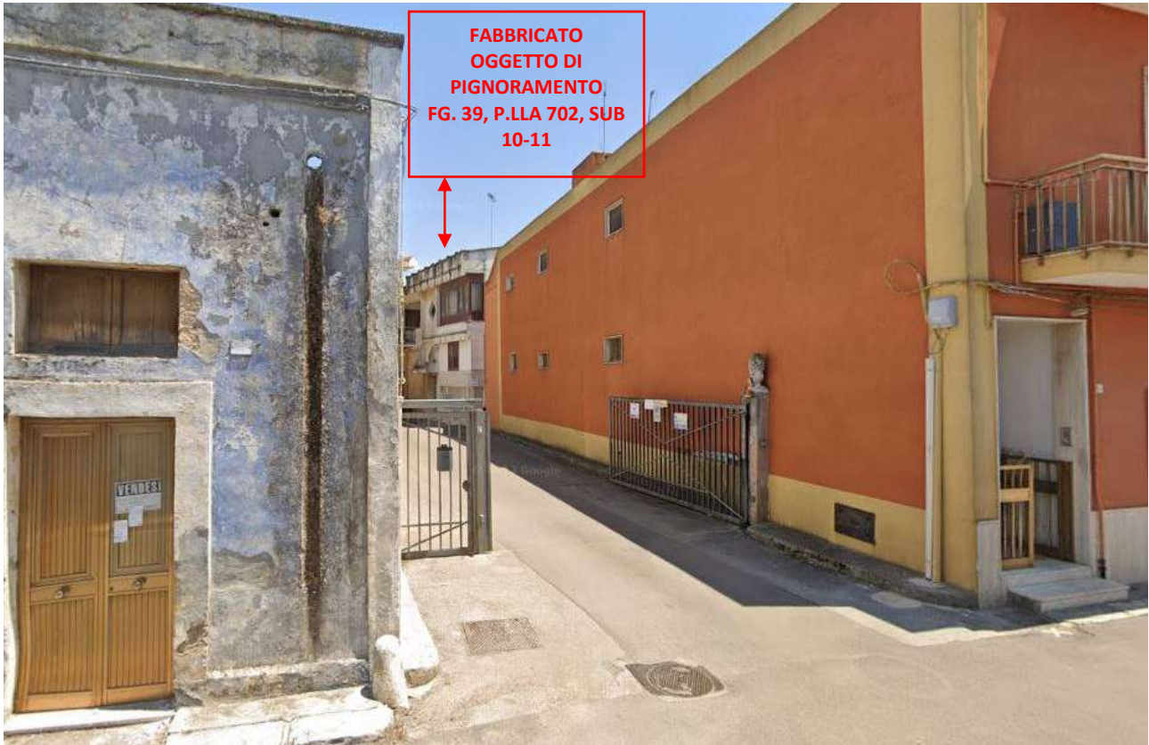
Foto 1_Vista da via Principe Amedeo dell’accesso carrabile e pedonale (civico 14) e dell’area privata nella quale insiste il fabbricato oggetto di espropriazione forzata
