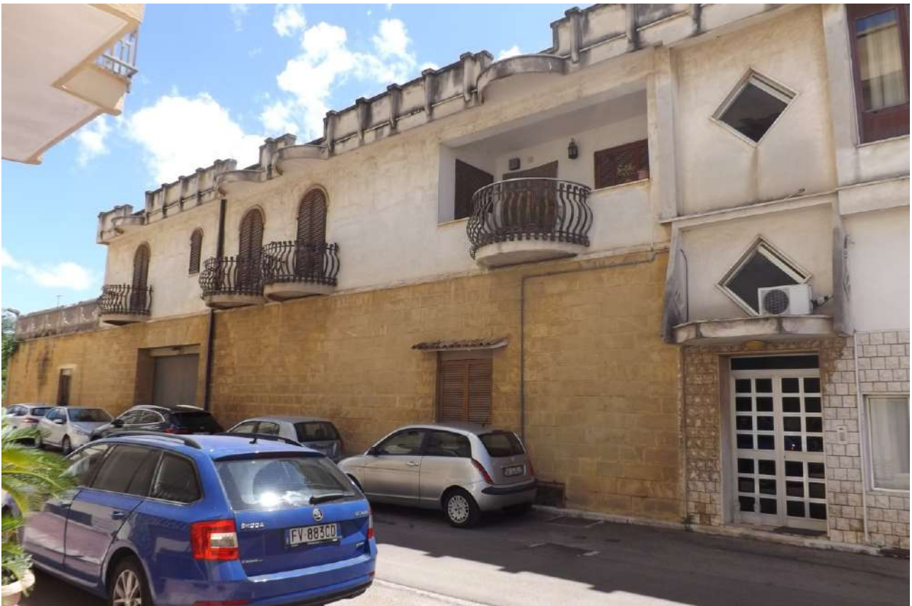
Foto 7. Altra vista d’insieme del prospetto principale (nord-ovest). Inquadratura del fronte dove il fabbricato è articolato su due piani: deposito (PT) e residenza (P1)
