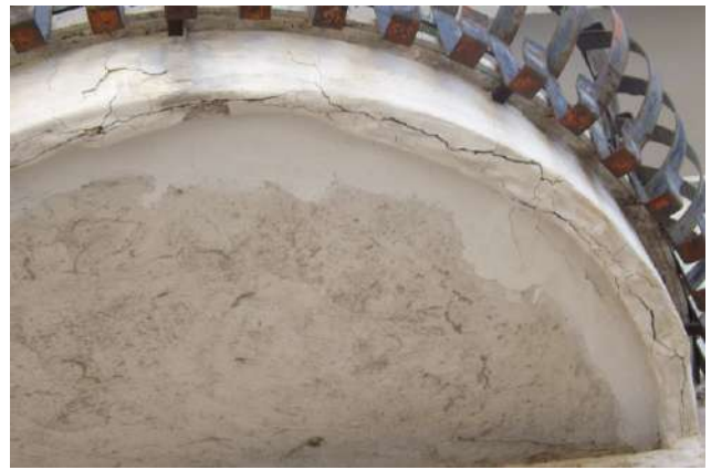
Foto 11-12_ Dettagli del sottobalcone: crepe perimetrali, finitura degradata e ossidazione dei ferri della ringhiera; evidenze di mancata manutenzione
