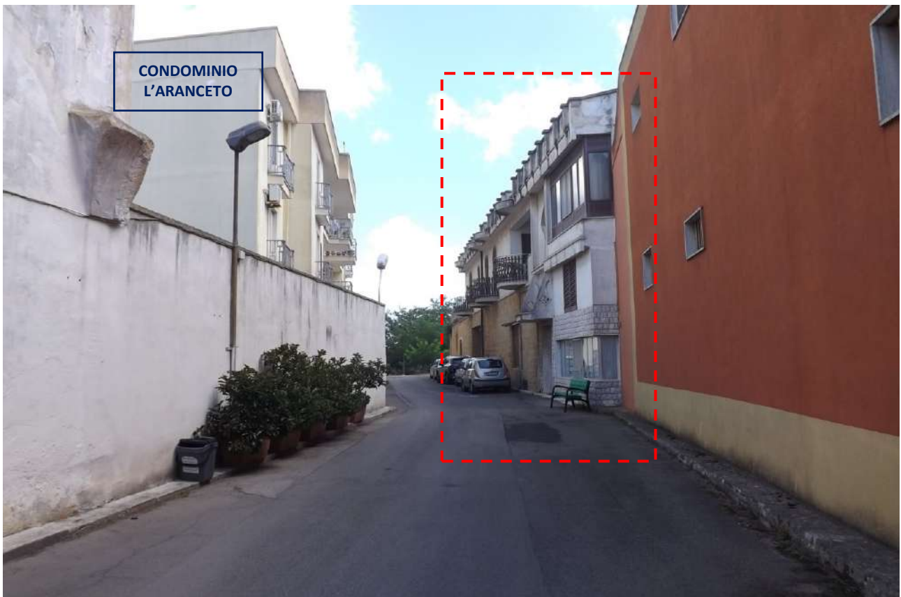
Foto 3_Vista d’insieme della viabilità privata della p.lla 702 nella quale sono ubicati sia il fabbricato oggetto di espropriazione forzata, che il complesso condominiale denominato “L’Aranceto”
