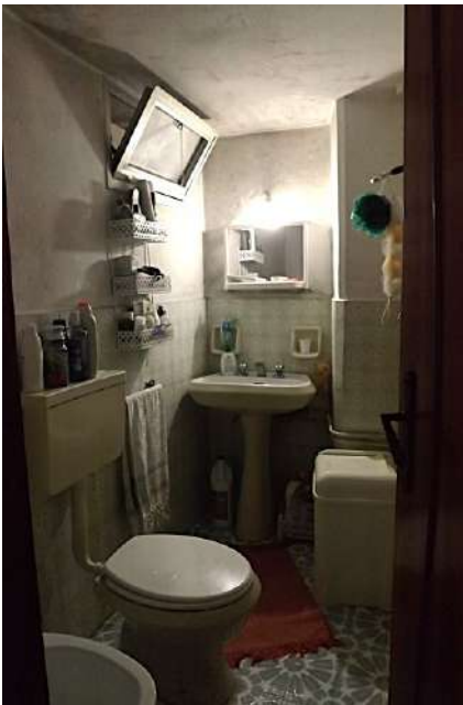
Foto 20-21-22_ Viste d’insieme del bagno di servizio di modeste dimensioni, rivestimento ceramico fino a mezza altezza, aerazione naturale con finestra a vasistas; finiture datate. Aloni/micro-muffe da condensa su pareti e soffitto; scaldacqua elettrico con collegamenti a vista.
