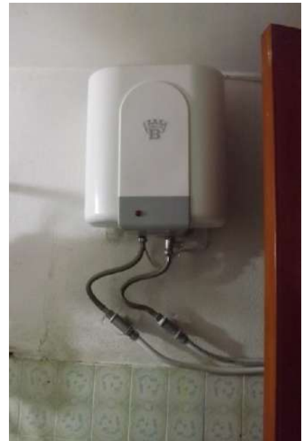
Foto 20-21-22_ Viste d’insieme del bagno di servizio di modeste dimensioni, rivestimento ceramico fino a mezza altezza, aerazione naturale con finestra a vasistas; finiture datate. Aloni/micro-muffe da condensa su pareti e soffitto; scaldacqua elettrico con collegamenti a vista.
