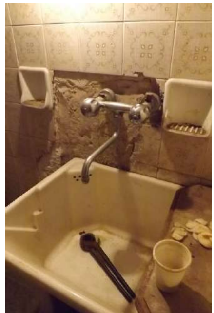
Foto 41-42-43_Viste di dettaglio del Piccolo bagno ricavato nel locale deposito, in assenza di titolo abilitativo: altezza interna ridotta per la presenza del soppalco sovrastante; finiture datate (piastrelle), sanitari parzialmente smontati; impianti idrico-elettrici a vista con scassi/rappezzi e tracce di umidità.
