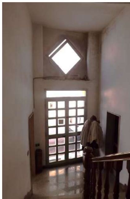
Foto 14_ Altra vista del vano scala al piano terra, dalla quale si rilevano le porte di ingresso al Locale deposito, e al vano attualmente adibito a cucina
