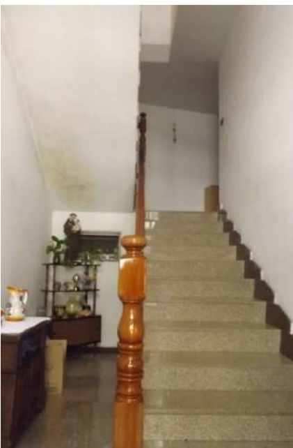
Foto 13_ Vista del vano scala al piano terra, con la rampa che conduce al piano ammezzato
