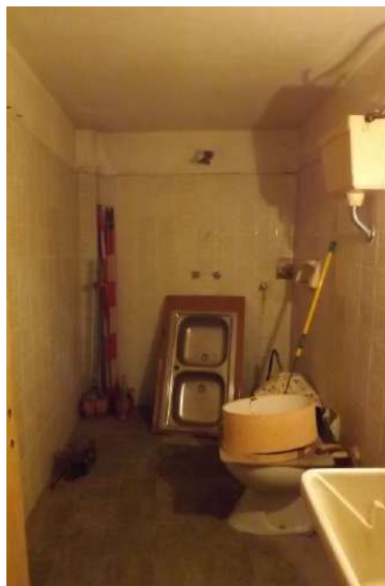
Foto 41-42-43_Viste di dettaglio del Piccolo bagno ricavato nel locale deposito, in assenza di titolo abilitativo: altezza interna ridotta per la presenza del soppalco sovrastante; finiture datate (piastrelle), sanitari parzialmente smontati; impianti idrico-elettrici a vista con scassi/rappezzi e tracce di umidità.
