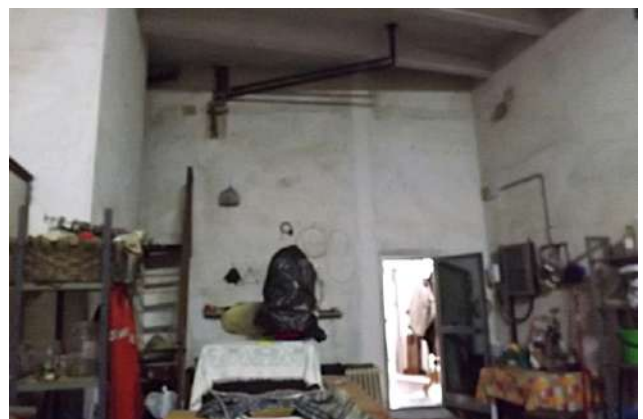
Foto 23-24_ Viste di porzione del locale deposito: ambiente a sviluppo longitudinale con solaio a travi a vista e pavimentazione in calcestruzzo; pareti intonacate con alonature diffuse, tubazioni e quadro elettrico a vista; presenza di scaffalature e arredi di servizio; sul fondo chiusura con partizione leggera.
