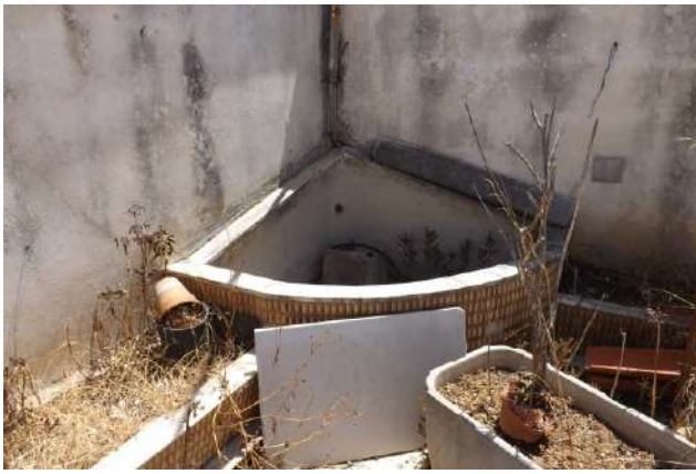
Foto 91_ Vista del sistema di fioriere perimetrali in muratura, rivestite in piastrelle, oggi in disuso
