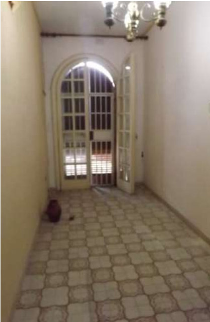
Foto 79-80_ Vista d’insieme della originaria veranda, oggi chiusa con infissi e tamponamenti e trasformata, senza titolo edilizio, in vano abitabile.
