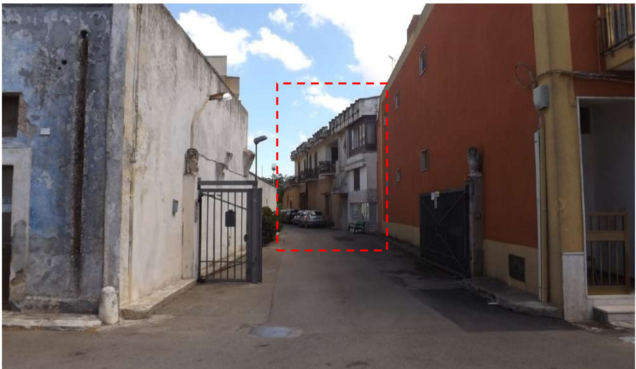
Foto 2_Vista sempre da via Principe Amedeo dell’accesso carrabile e pedonale (civico 14) e dell’area privata nella quale insiste il fabbricato oggetto di espropriazione forzata
