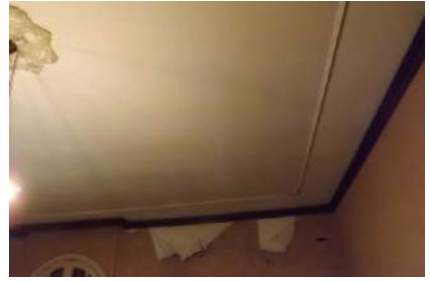
Foto 76-77-78_ Dettagli della camera da letto: pavimentazione in piastrelle ceramiche decorate di buon livello; pareti rifinite con carta da parat, in più punti scollata e macchiata, con evidenti segni di umidità alla base in corrispondenza della portafinestra; infisso a portafinestra in legno laccato avorio; soffitto intonacato con cornici perimetrali, interessato da aloni e leggere fessurazioni.
