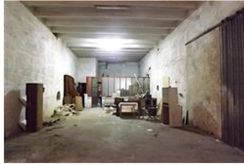
Locale deposito: vista dall'ambiente principale della partizione leggera che delimita la porzione secondaria.
