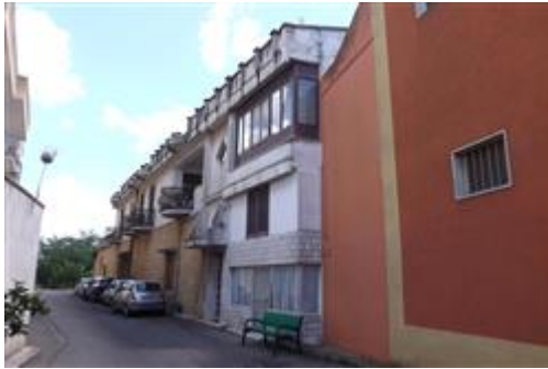
Vista d'insieme del fabbricato nel quale insistono i beni immobili pignorati
