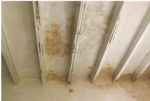
Locale deposito: vista di dettaglio del solaio
