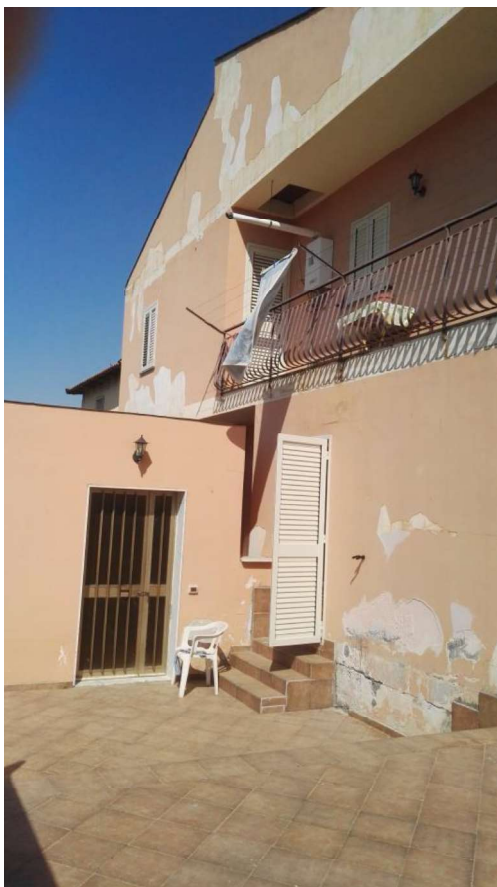
Foto 2 – Prospetto a Sud e pertinenza
