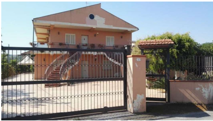
Foto 1 - Prospetto Nord su stradella privata di accesso
