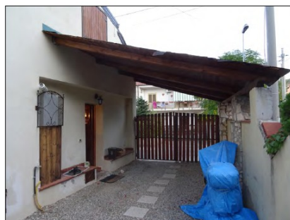
Foto N. 11: Porticato 1 su lato SUD-EST
