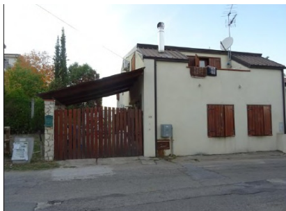
Foto N. 02: Immobile vista NORD-EST
