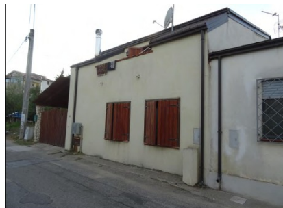
Foto N. 03: Immobile vista NORD
