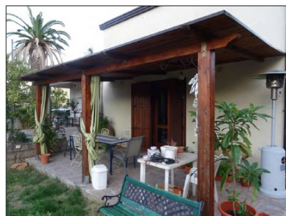
Foto N. 12: Porticato 2 su lato SUD-OVEST
