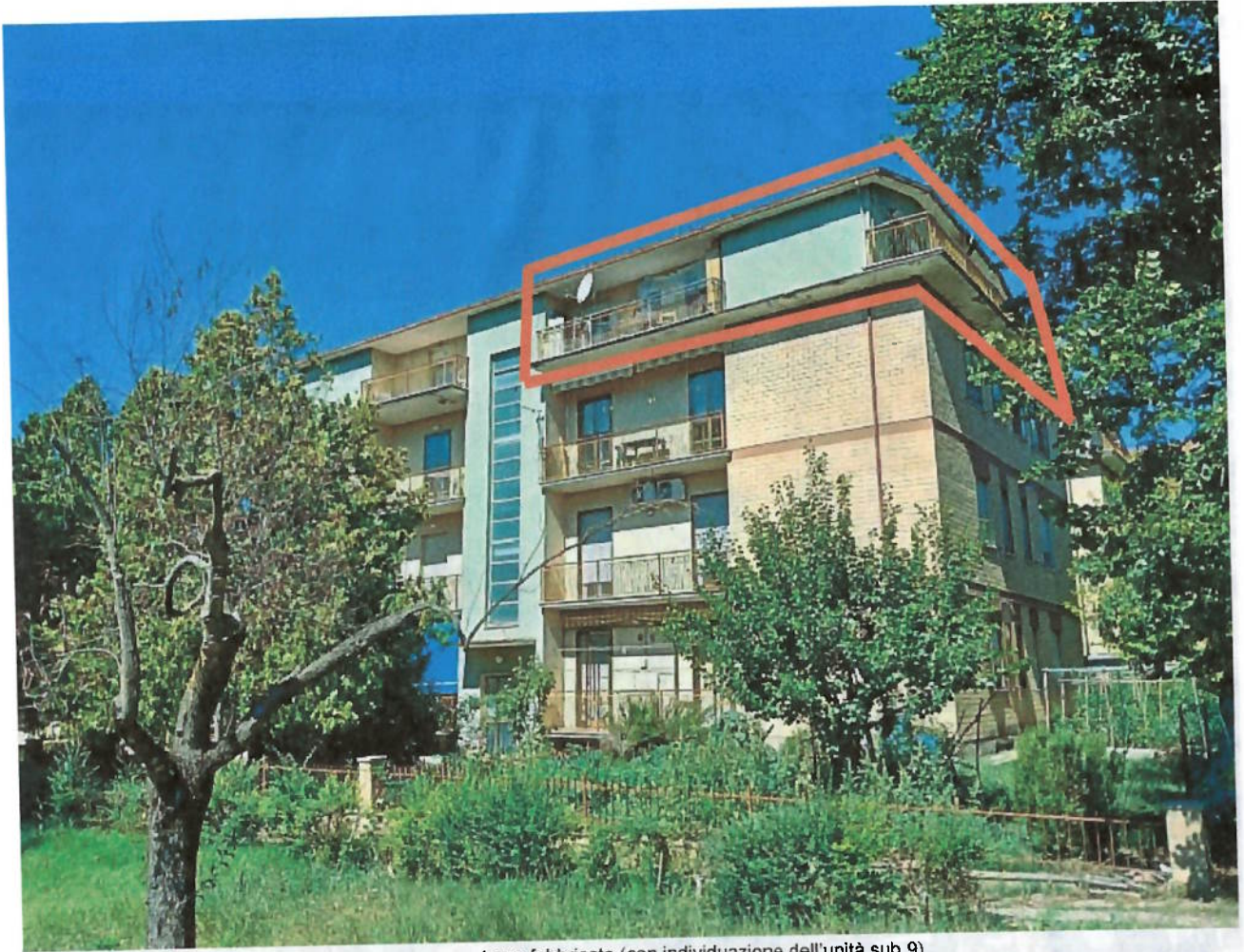
esterno fabbricato (con individuazione dell'unità sub 9)
