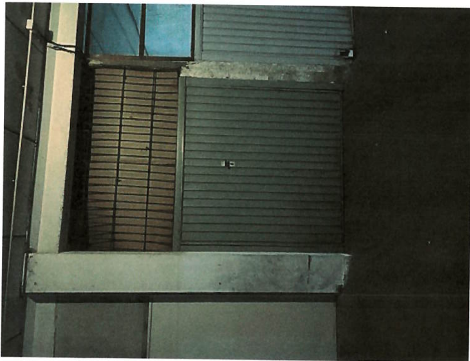
Fotografia H.12 - Garage, piano seminterrato
