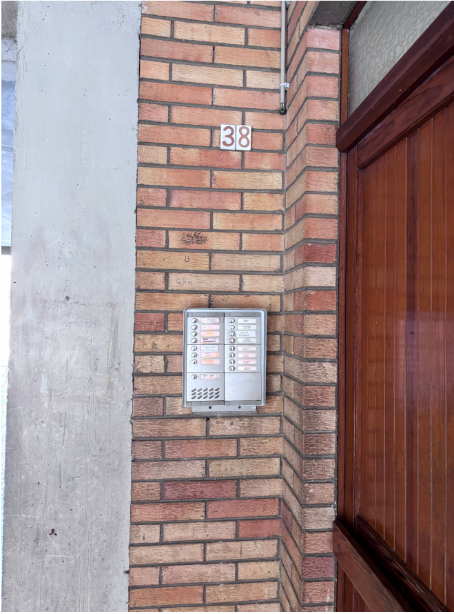
FOTO 1 - VISTA PORTONE INGRESSO CONDOMINIALE CIVICO 38 E RELATIVA PULSANTIERA CITOFONO
