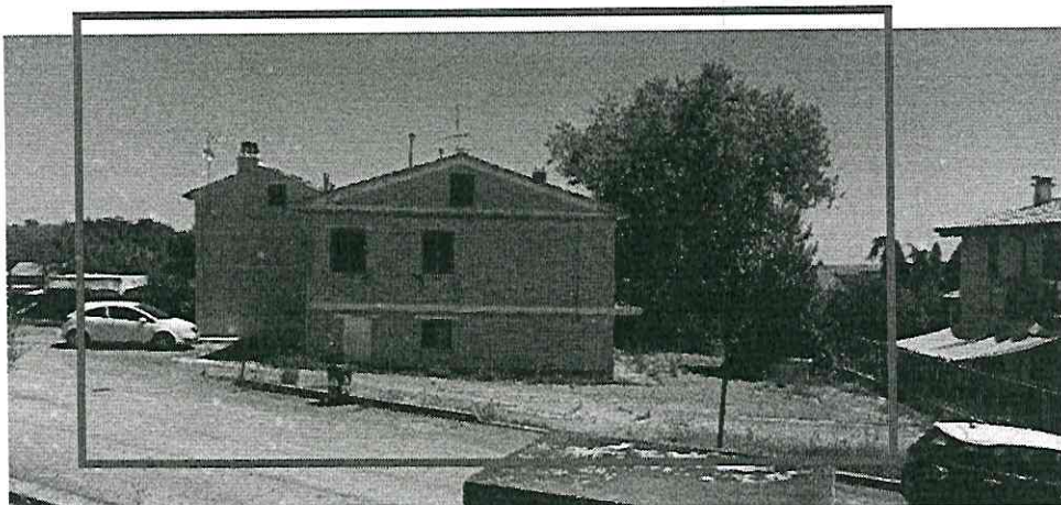
1 - Fronte Ovest edificio da Strada Faleriense
