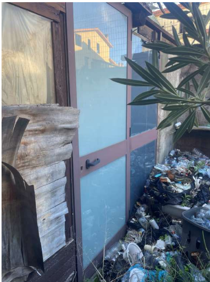
FOTO 29: VISTA DEL LOCALE ALL'ESTERNO
