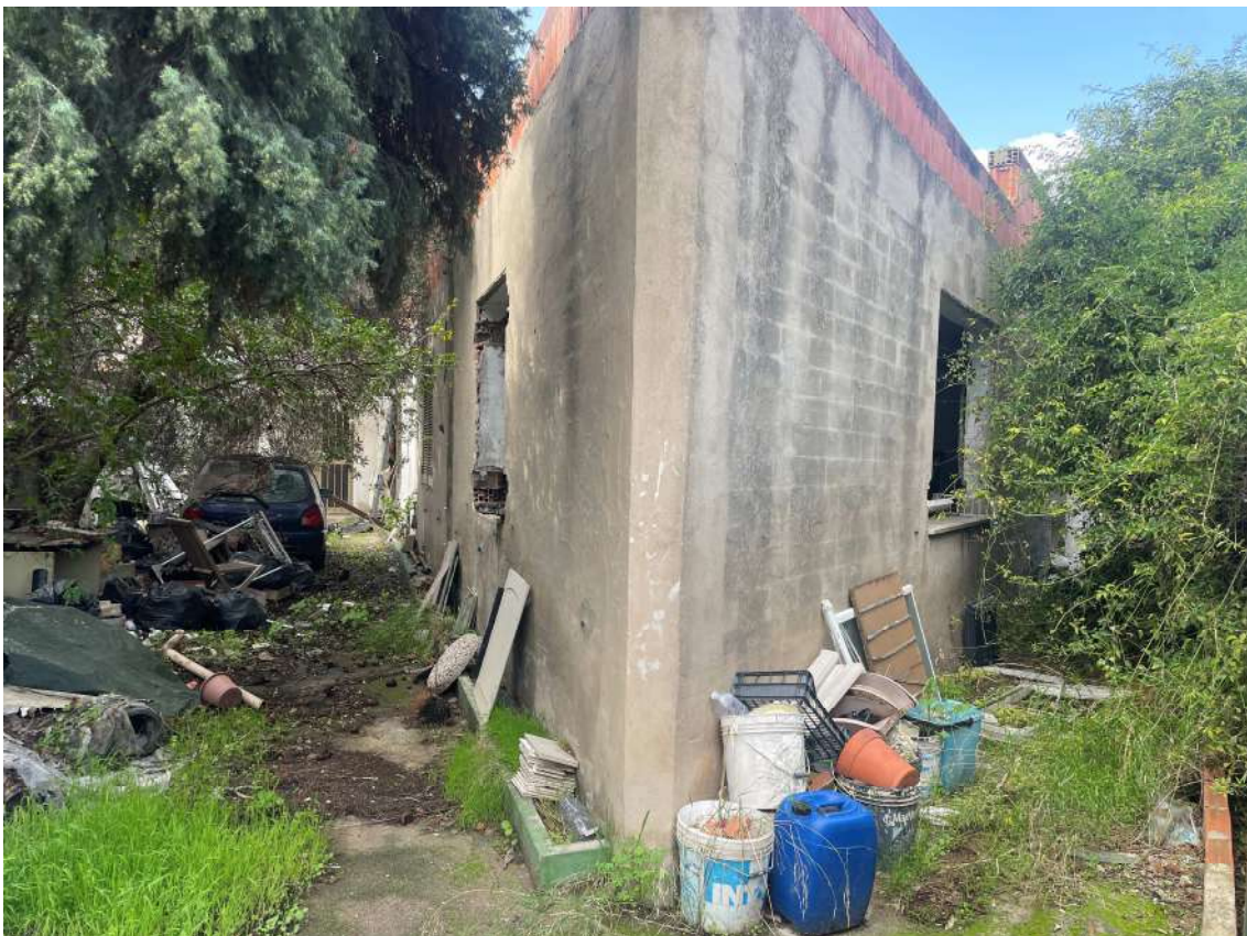
FOTO 6: VISTA DEL CORTILE INTERNO
