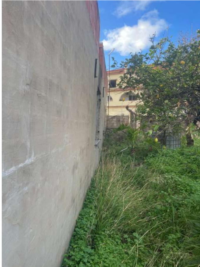
FOTO 11: VISTA DEL CORTILE INTERNO
