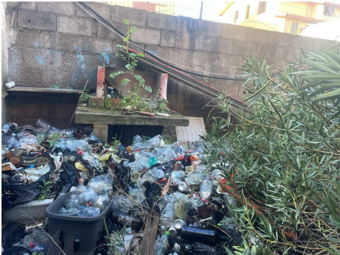
FOTO 32: VISTA DEL CORTILE INTERNO
