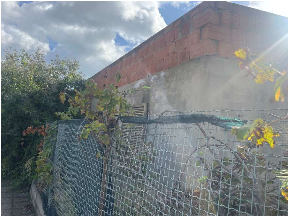
FOTO 9: VISTA DELLA FACCIATA PRINCIPALE
