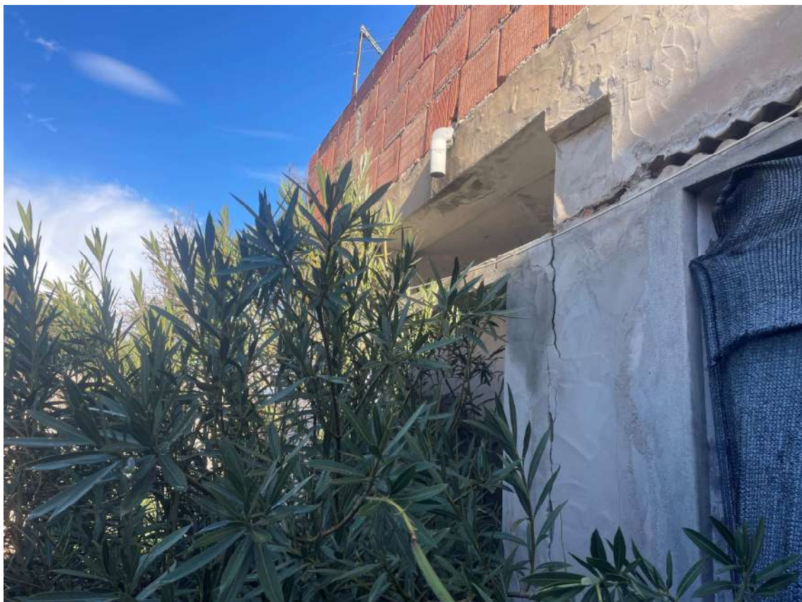
FOTO 30: VISTA DEL PROSPETTO POSTERIORE
