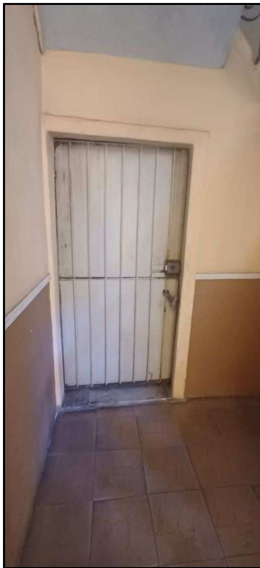
FOTO 19 - Porta di ingresso alle cantine
