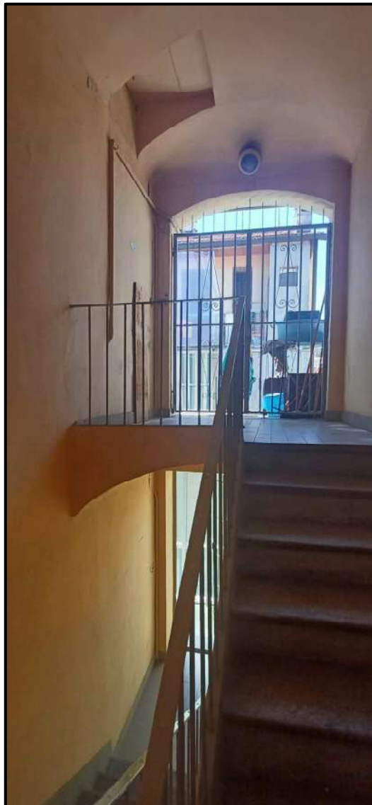
FOTO 09 - Vano scala di accesso condominiale
