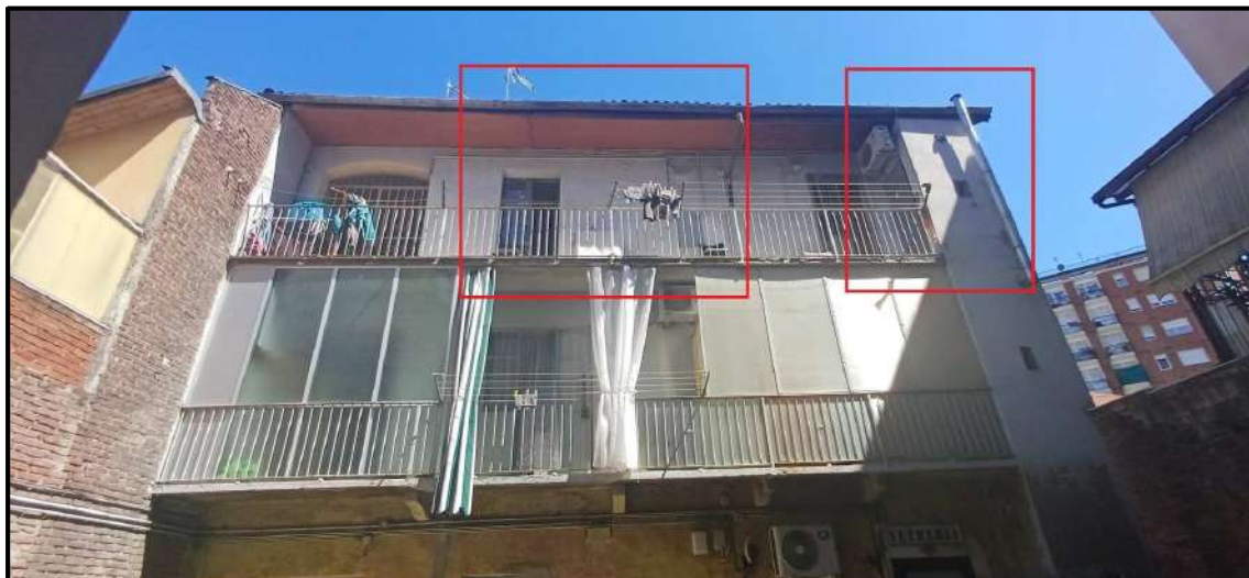
FOTO 06 - Veduta edificio lato cortile condominiale (nei riquadri rossi si evidenzia la posizione dell'unità abitativa in oggetto)
