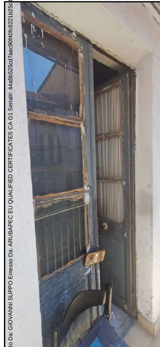
FOTO 11 - Porta di ingresso all'unità abitativa in oggetto
