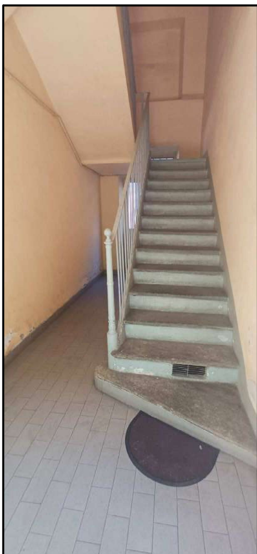
FOTO 07 - Vano scala di accesso condominiale
