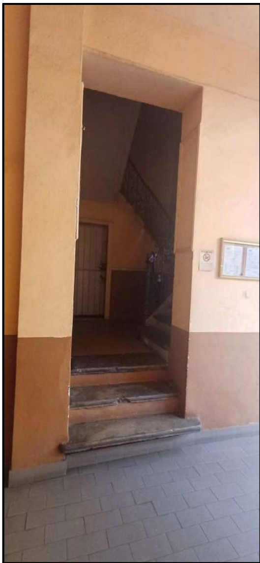
FOTO 18 - Veduta ingresso alle cantine
