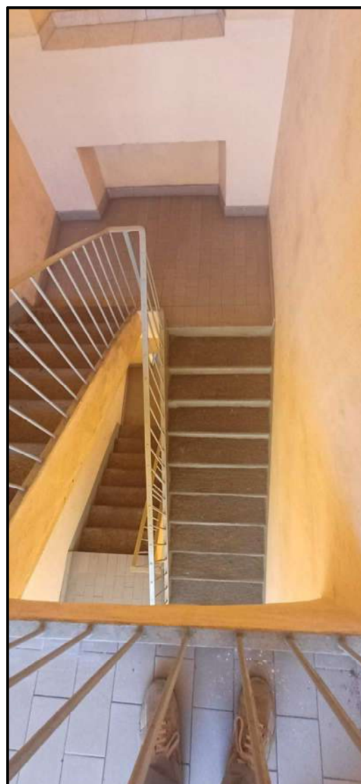
FOTO 08 - Vano scala di accesso condominiale
