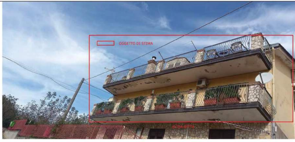
Foto 5: Porzione di immobile oggetto di stima a costituire unità abitativa (lotto 1)
