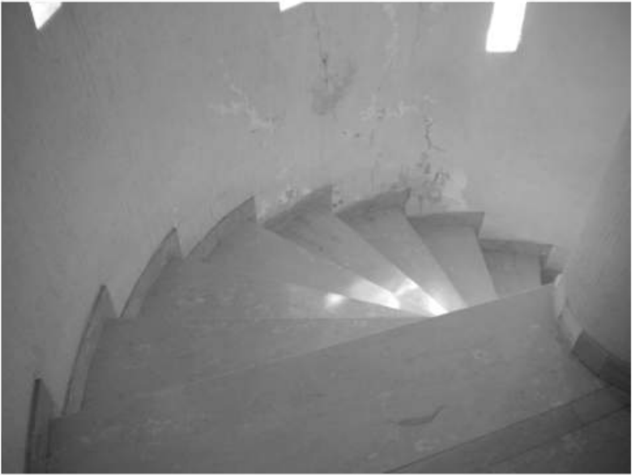
scala interna accesso pianerottolo
