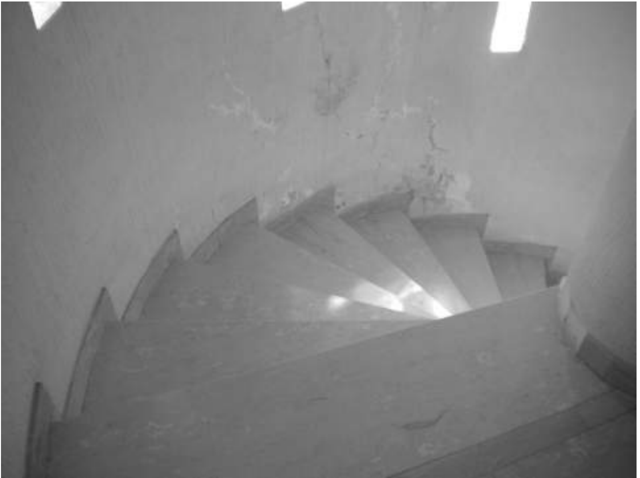
scala interna accesso pianerottolo
