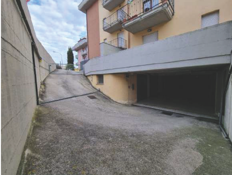
La rampa carrabile dal piano interrato
