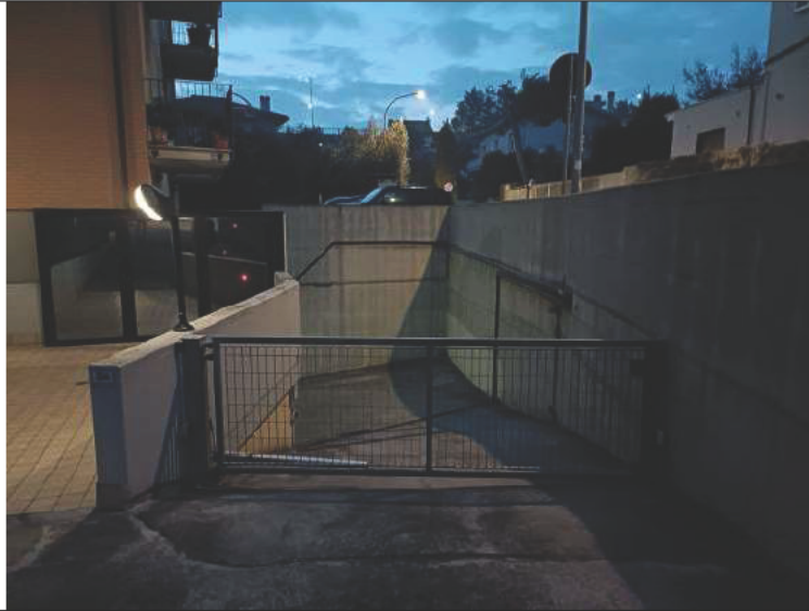
Da via Piane di Tesino vista dell'accesso con cancello al piano interrato
