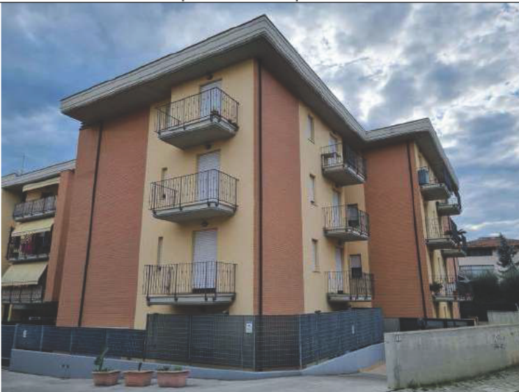
Esterno dell'edificio residenziale
