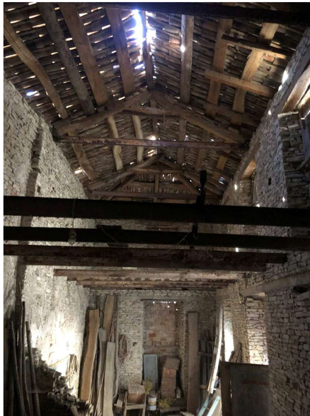
Interno Deposito Vista verso Sud
