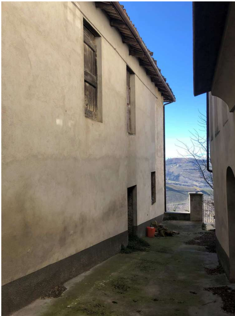
Vista facciata lato cortile - deposito
