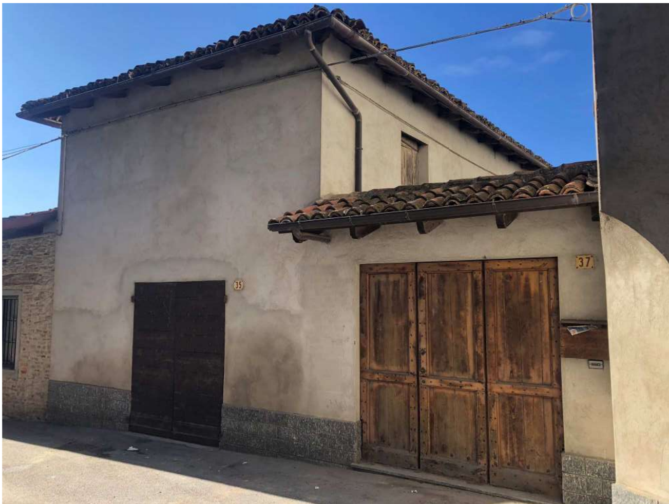
Vista accessi da Via F. Albertino n.c. 35 (deposito) e n.c. 37 (cortile interno)
