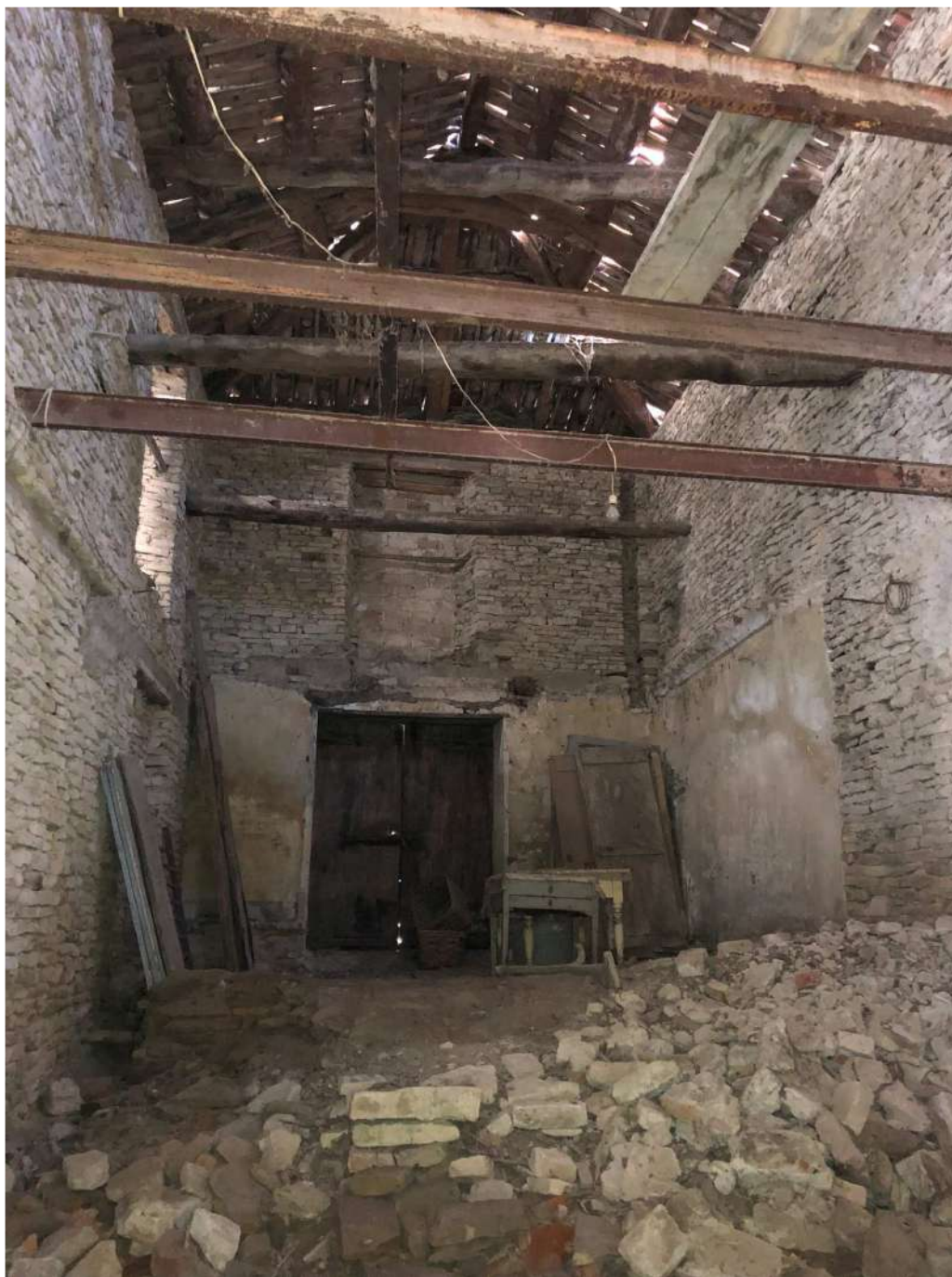
Interno Deposito Vista verso Via F. Albertino
