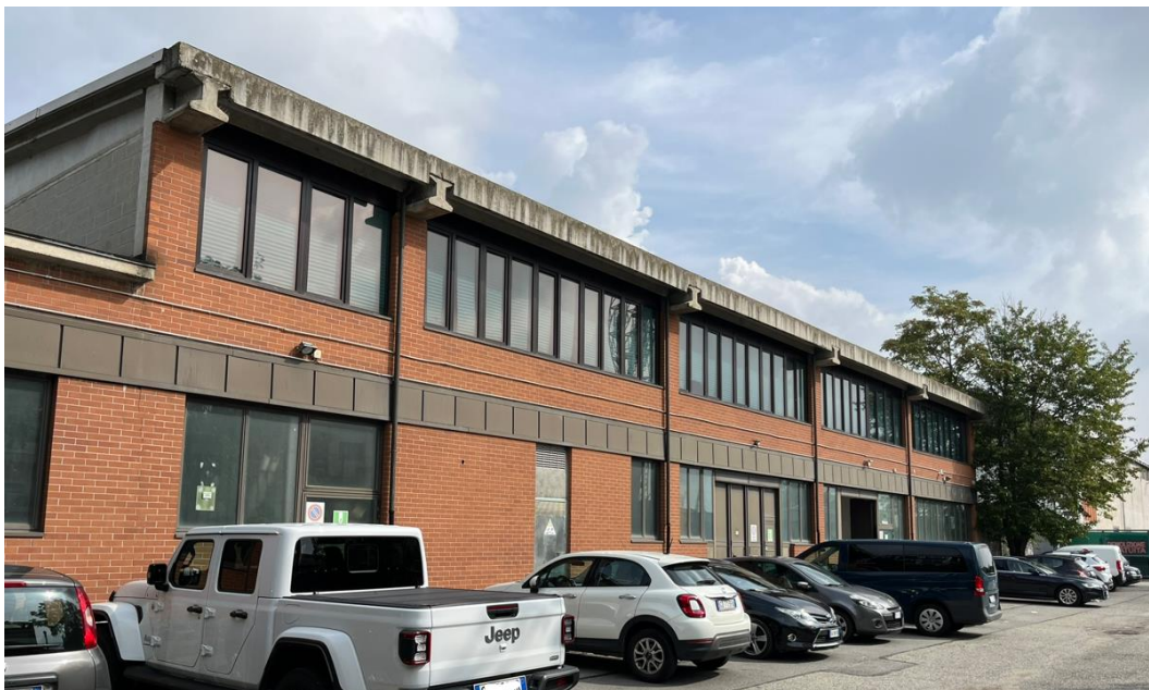
Figura 3 – FACCIATA A SUD-OVEST
