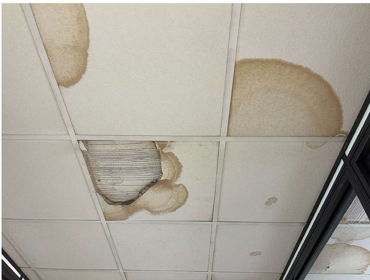
35_dettaglio infiltrazioni
