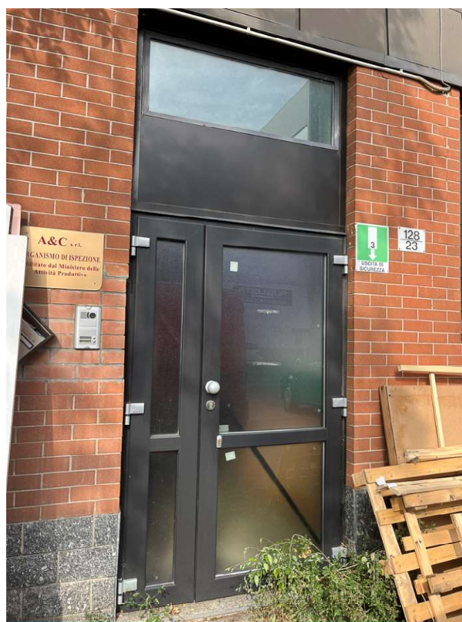
04_ingresso dal civico n. 128 int 123
