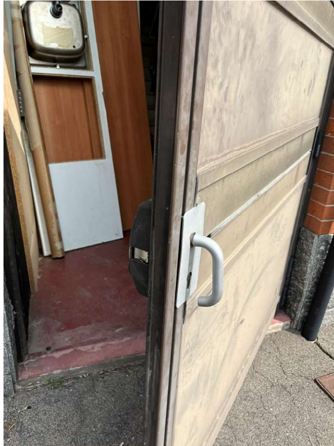
09_dettaglio porta ingresso secondario
