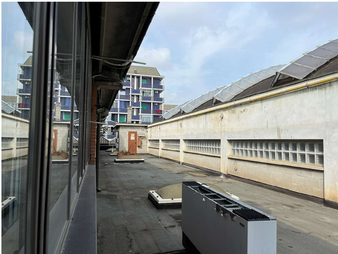
32_lastrico solare confinante
