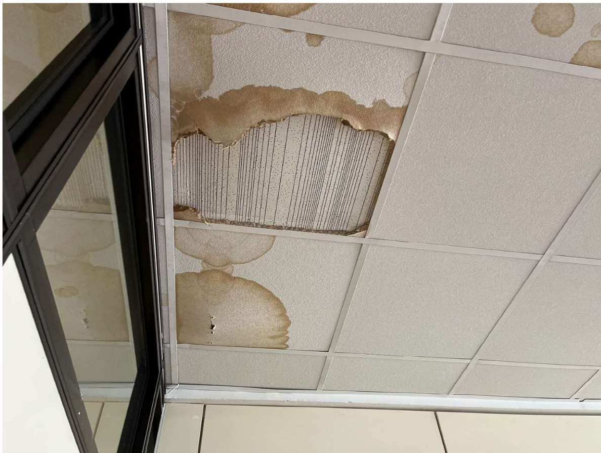
38_dettaglio infiltrazioni
