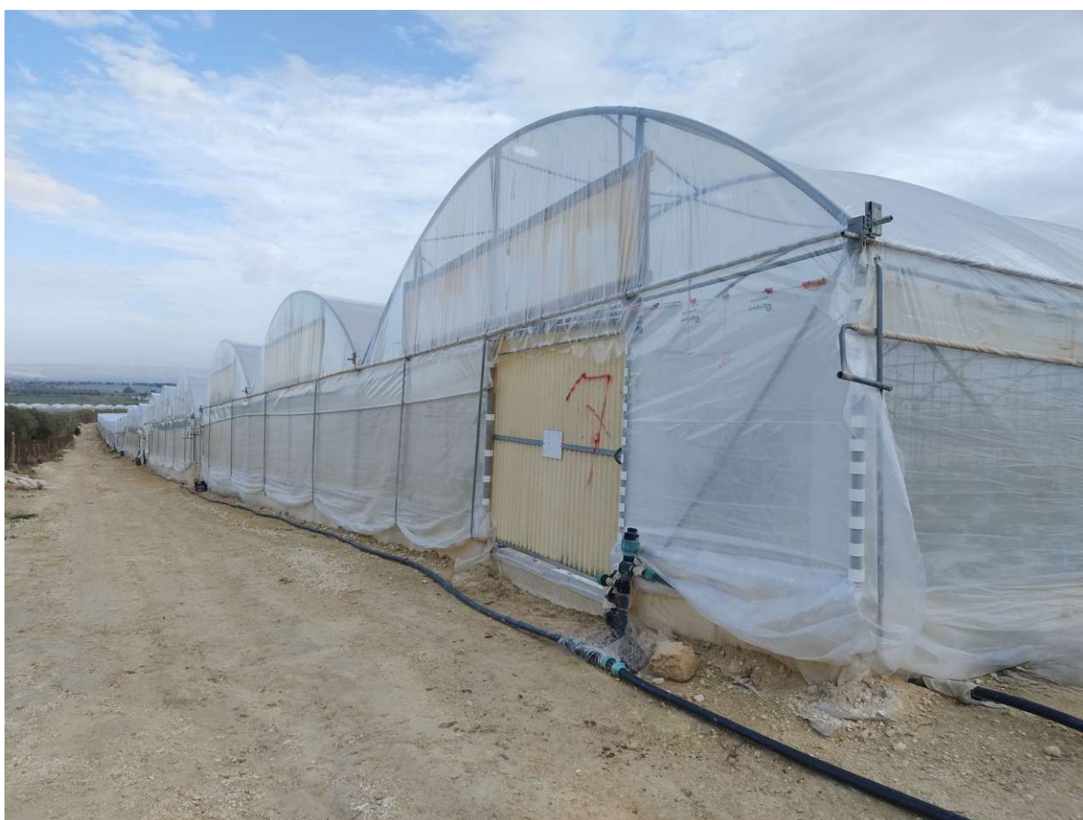
Foto 14 e 15 – Serre metalliche e particolari costruttivi.
