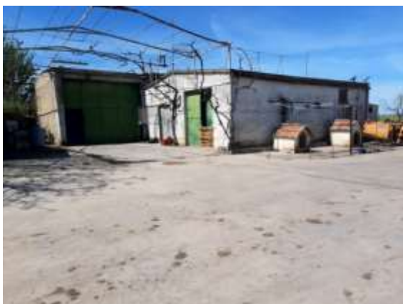
Fabbricato G – Vista esterna
