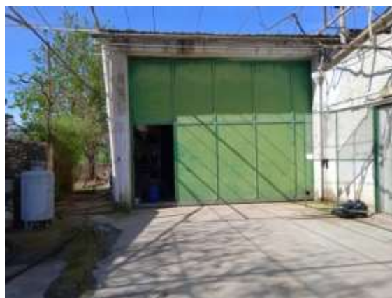
Fabbricato G – Vista esterna
