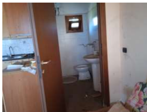
Part. 854 sub 2 – Vista interna
