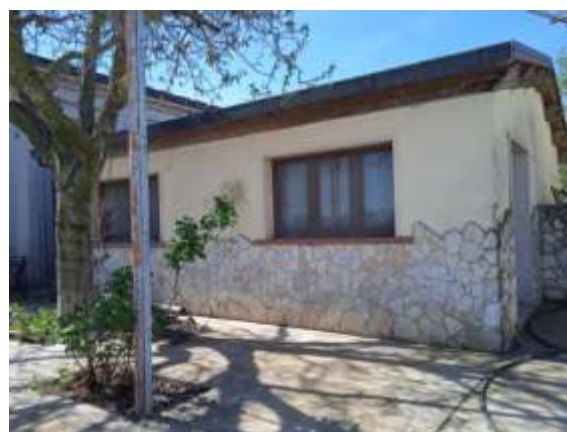
Part. 854 sub 2 – Vista esterna
