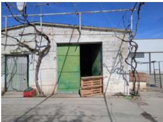
Fabbricato H – Vista esterna
