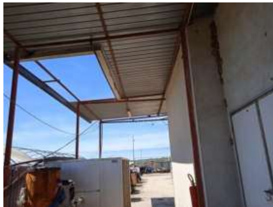
Immobilе B – Vista tettoia
