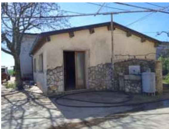
Part. 854 sub 2 – Vista esterna
