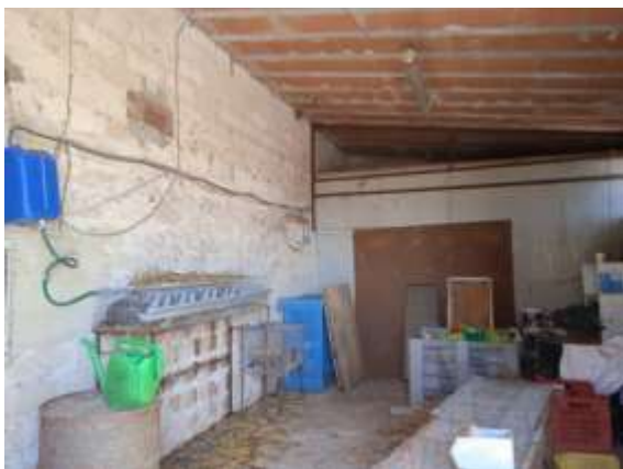
Fabbricato H – Vista interna
