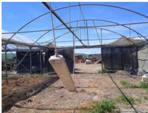
Immobilе C – Vista serre
