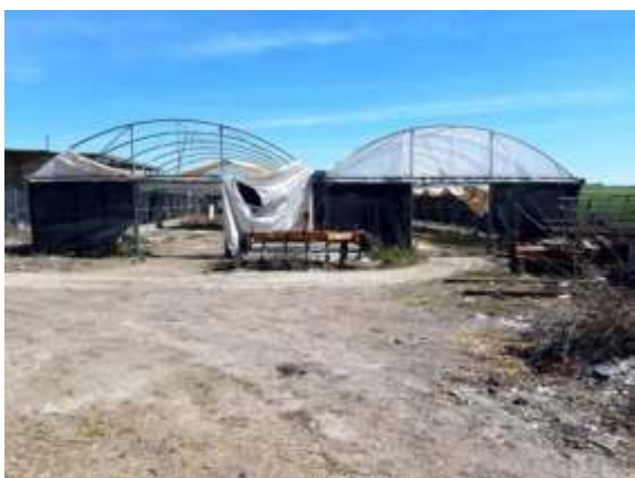
Immobilе C – Vista serre
