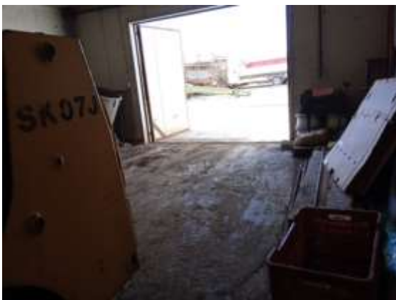
Fabbricato A – Vista interna
