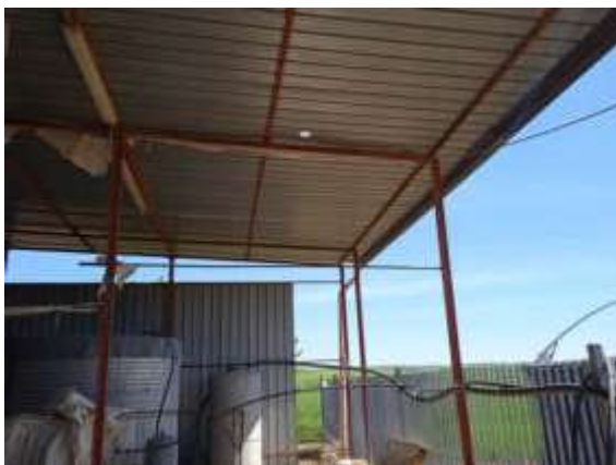
Immobilе B – Vista tettoia
