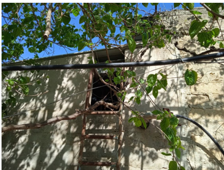
Foto n. 53 – Immobili siti in Banzi – Part. 818 sub 2 – Fabbricato I
