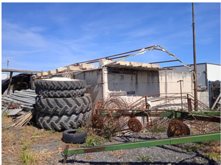
Foto n. 31 – Immobili siti in Banzi – Part. 817 sub 1 – Vasca F
