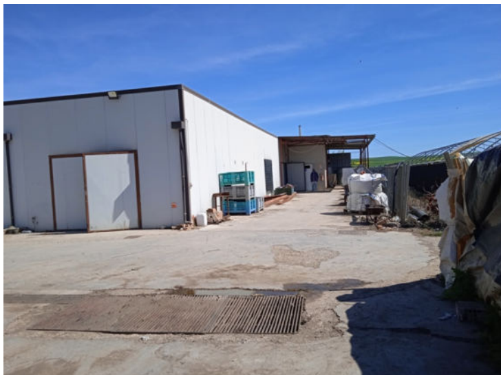
Foto n. 21 – Immobili siti in Banzi – Part. 817 sub 1 – Tettoia B
