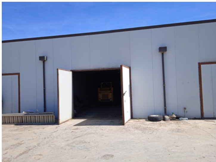
Foto n. 10 – Immobili siti in Banzi – Part. 817 sub 1 – Fabbricato A
