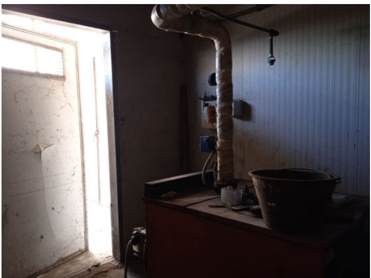
Foto n. 26 – Immobili siti in Banzi – Part. 817 sub 1 – Tettoia B
