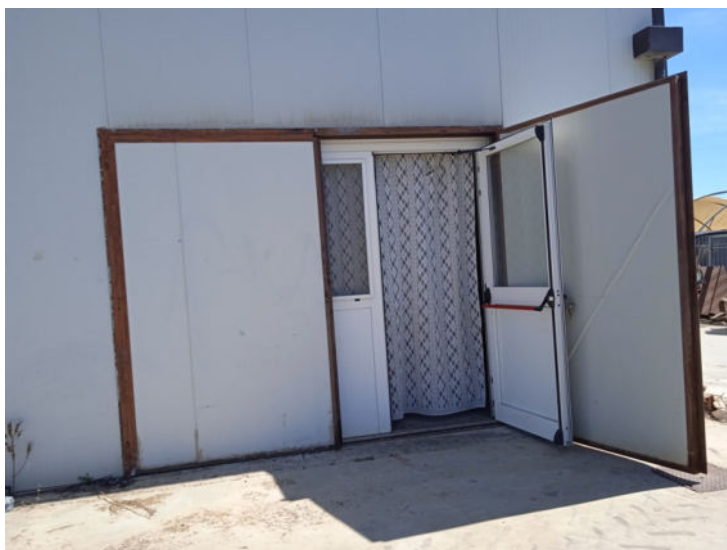
Foto n. 13 – Immobili siti in Banzi – Part. 817 sub 1 – Fabbricato A
