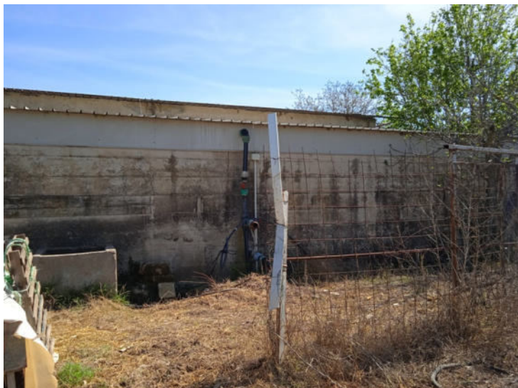
Foto n. 51 – Immobili siti in Banzi – Part. 818 sub 2 – Fabbricato I
