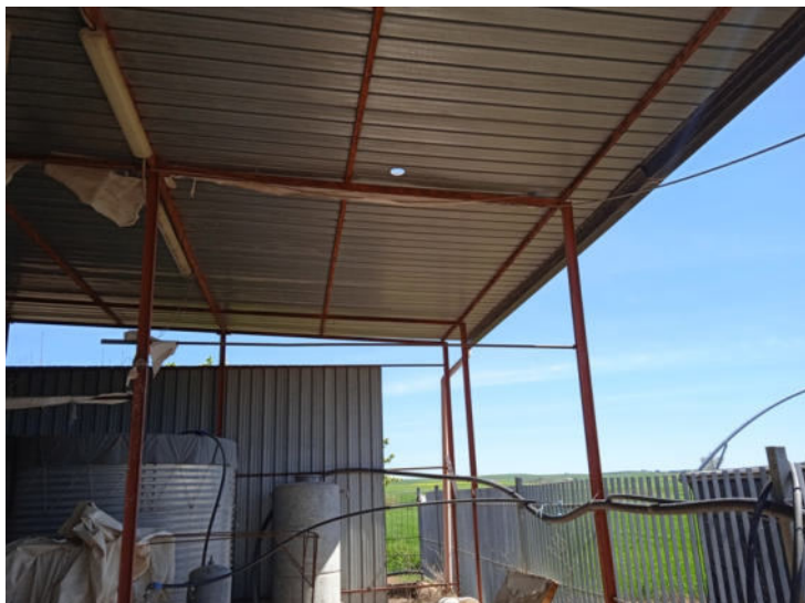
Foto n. 22 – Immobili siti in Banzi – Part. 817 sub 1 – Tettoia B
