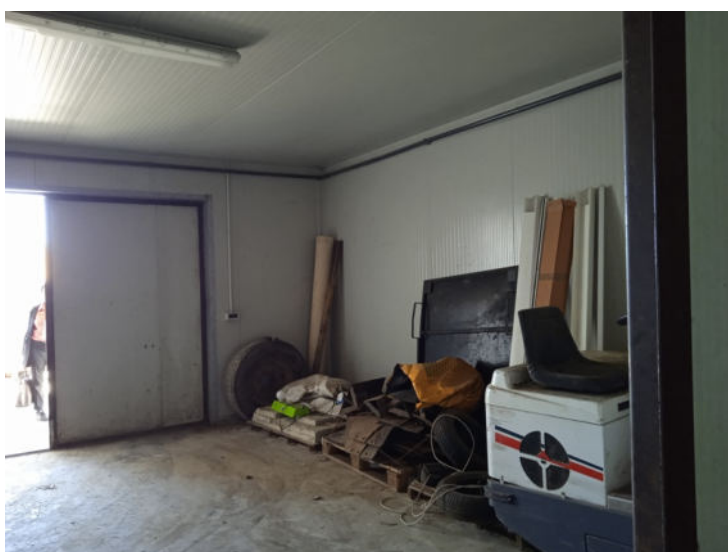
Foto n. 20 – Immobili siti in Banzi – Part. 817 sub 1 – Fabbricato A
