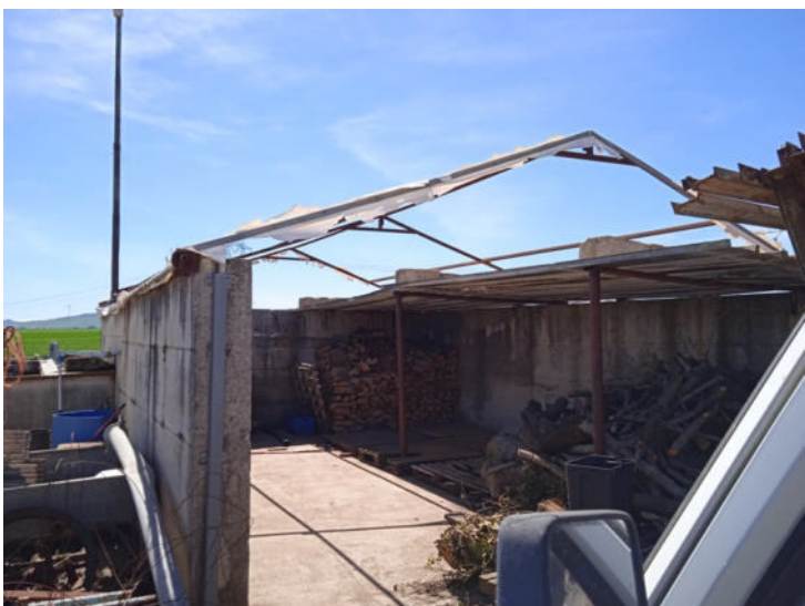
Foto n. 32 – Immobili siti in Banzi – Part. 817 sub 1 – Vasca F
