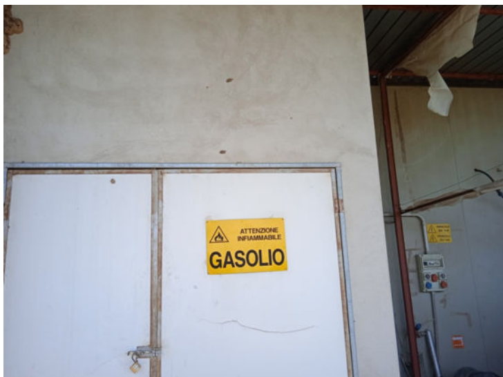
Foto n. 24 – Immobili siti in Banzi – Part. 817 sub 1 – Tettoia B
