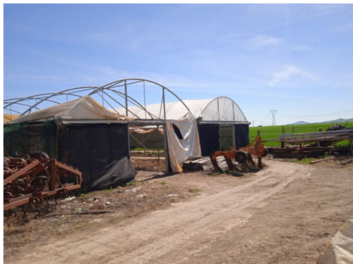
Foto n. 28 – Immobili siti in Banzi – Part. 817 sub 1 – Serre C
