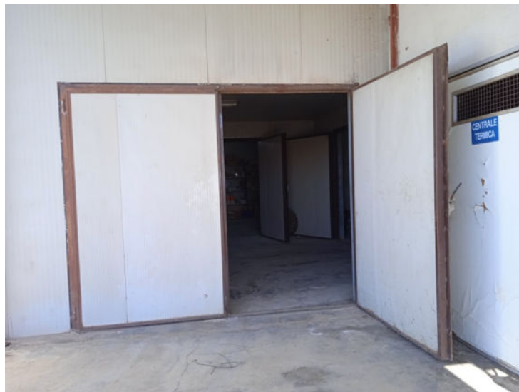
Foto n. 16 – Immobili siti in Banzi – Part. 817 sub 1 – Fabbricato A
