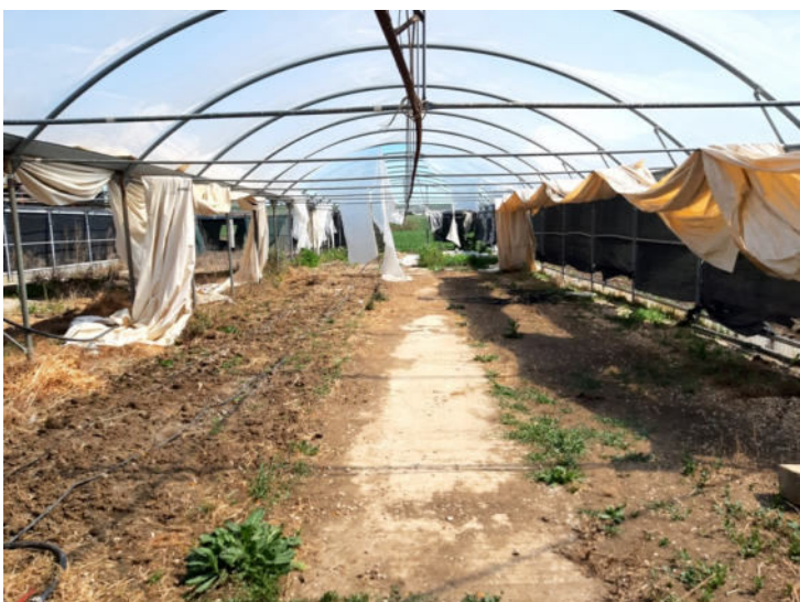
Foto n. 30 – Immobili siti in Banzi – Part. 817 sub 1 – Serre C
