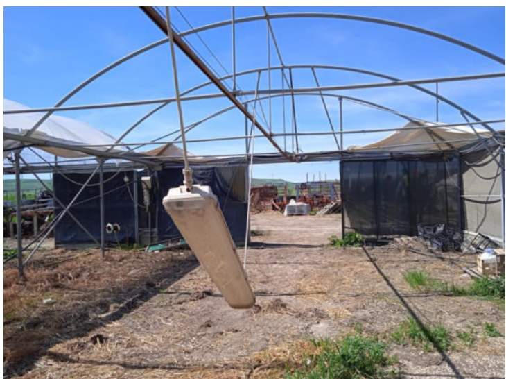
Foto n. 29 – Immobili siti in Banzi – Part. 817 sub 1 – Serre C
