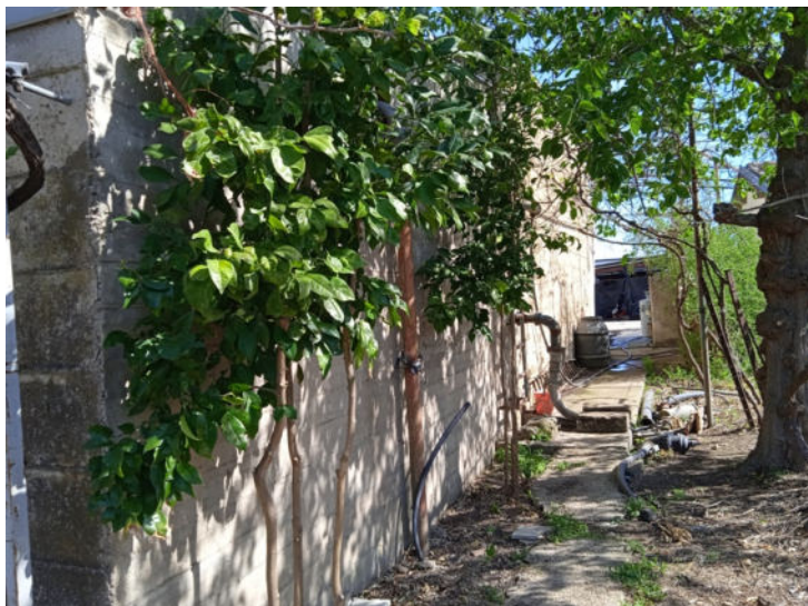
Foto n. 52 – Immobili siti in Banzi – Part. 818 sub 2 – Fabbricato I
