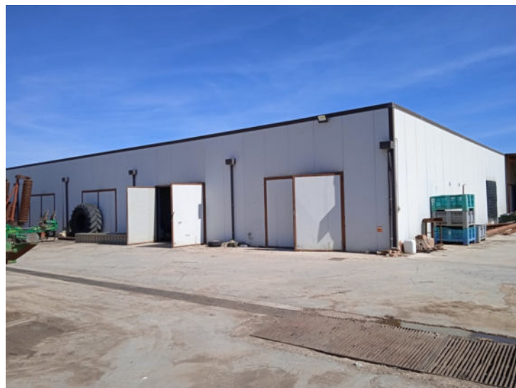
Foto n. 8 – Immobili siti in Banzi – Part. 817 sub 1 – Fabbricato A
