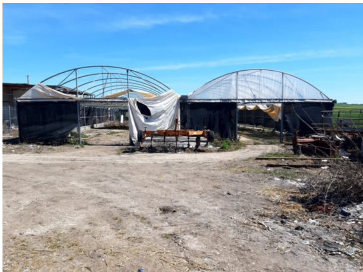
Foto n. 27 – Immobili siti in Banzi – Part. 817 sub 1 – Serre C
