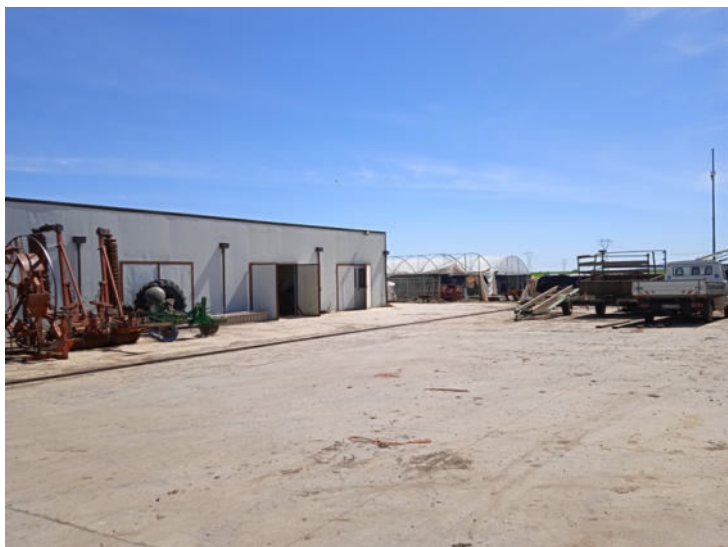
Foto n. 7 – Immobili siti in Banzi – Part. 817 sub 1 – Fabbricato A
