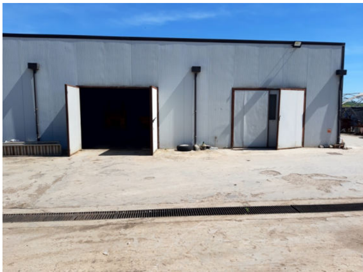
Foto n. 9 – Immobili siti in Banzi – Part. 817 sub 1 – Fabbricato A
