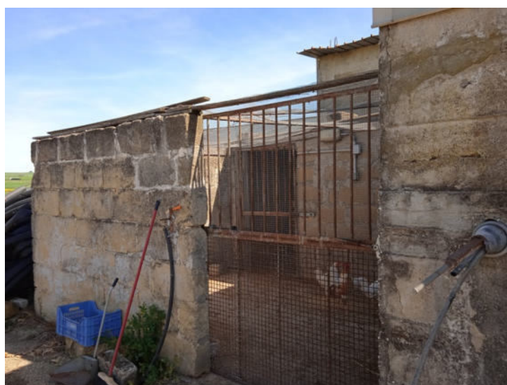
Foto n. 54 – Immobili siti in Banzi – Part. 818 sub 2 – Fabbricato I
