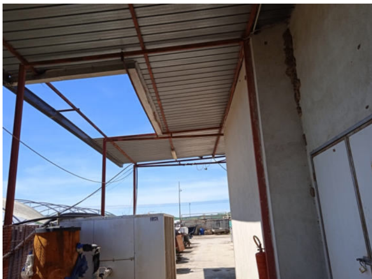
Foto n. 23 – Immobili siti in Banzi – Part. 817 sub 1 – Tettoia B
