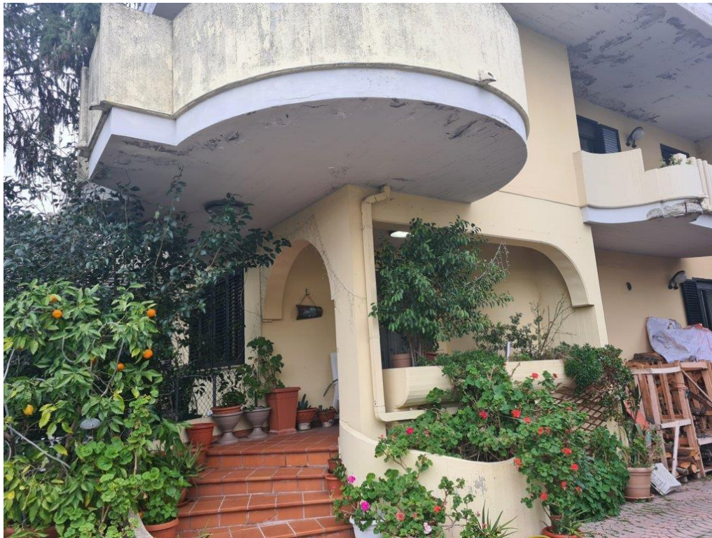
6. Vista della scalinata esterna e del porticato di accesso al piano terra del fabbricato
