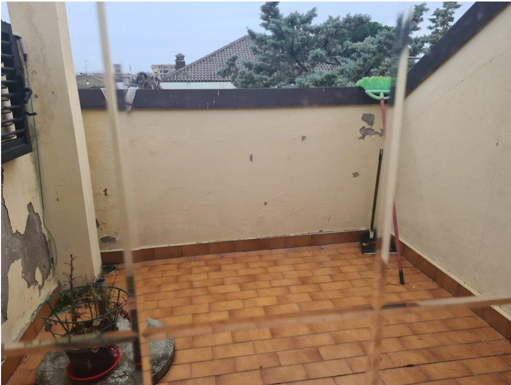
30. Vista del balcone al piano secondo
