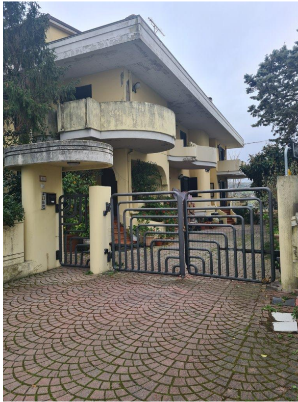
1. Vista fronte strada del fabbricato oggetto di procedura
