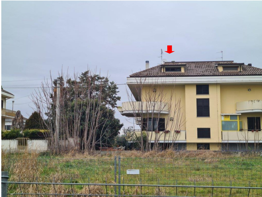
5. Vista fronte sud del fabbricato
