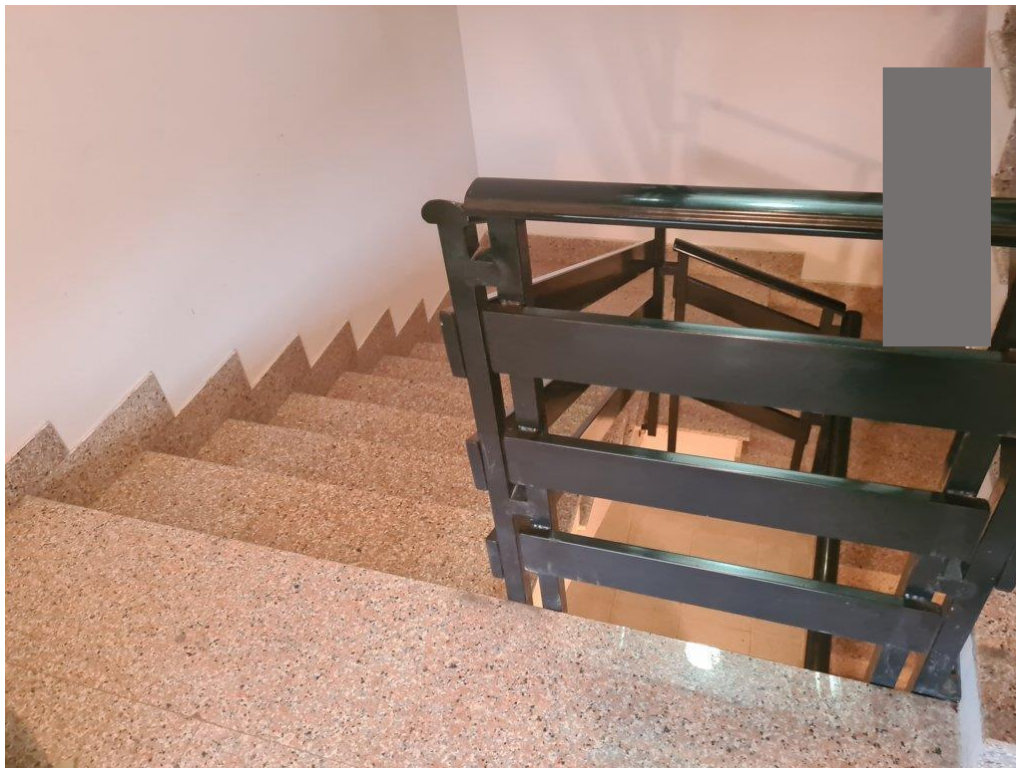
32. Vista della scala di accesso al piano primo sottostrada
