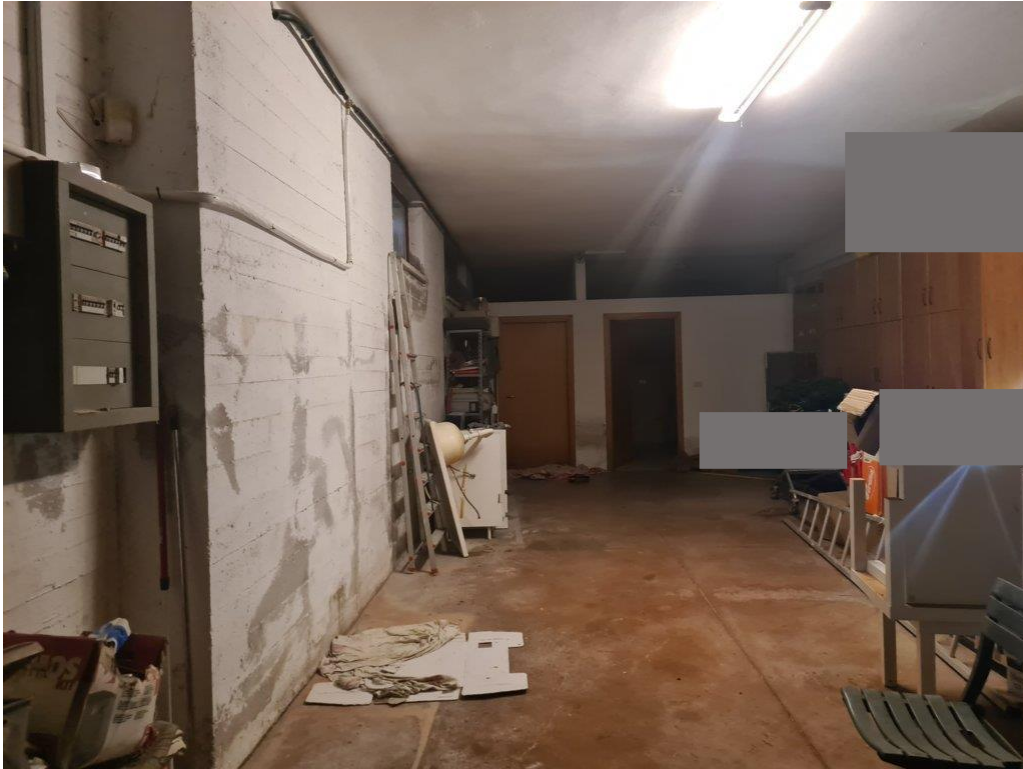
33. Vista del garage al piano primo sottostrada
