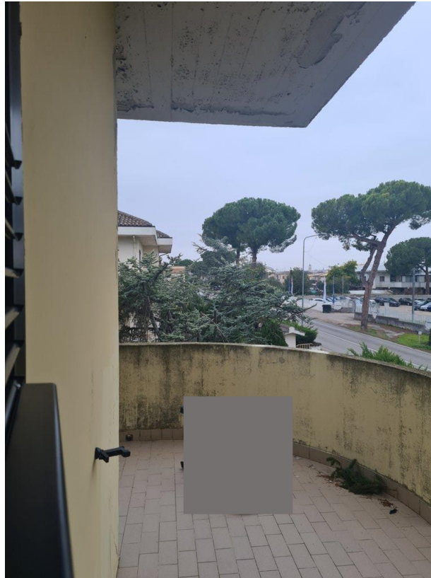
22. Vista del balcone della camera al piano primo, sul fronte strada
