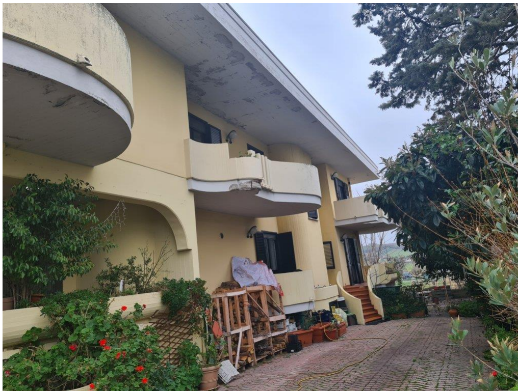
3. Vista del fronte ovest del fabbricato e di parte dell'area di corte di pertinenza
