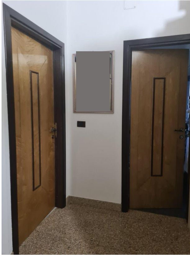
15. Vista del disimpegno al piano primo
