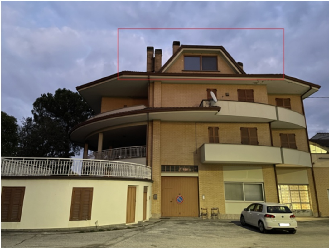
Foto n.23 (vista lato ovest)
