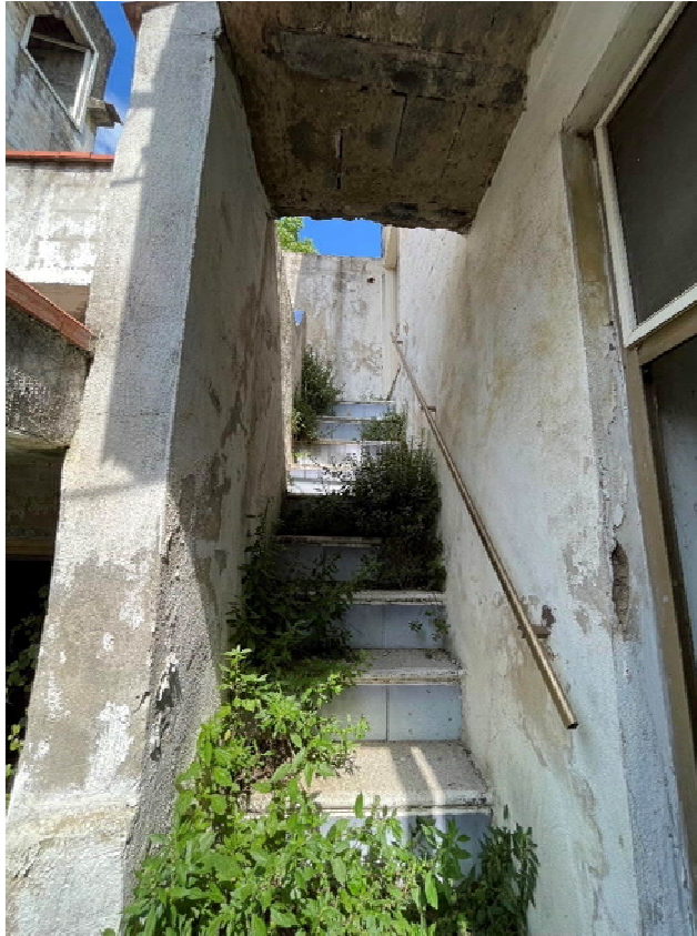
Foto n°2 vista scala esterna
