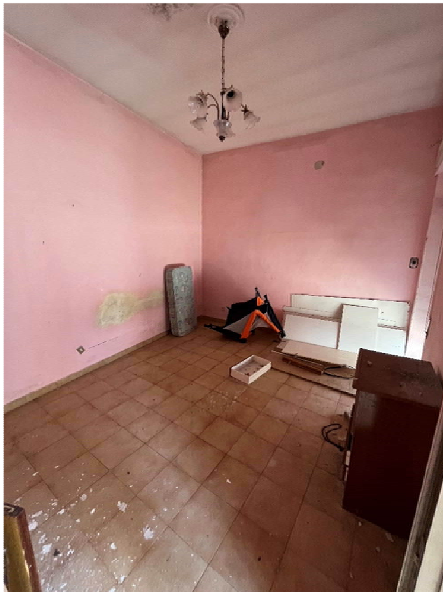
Foto 11 vista camera grande
