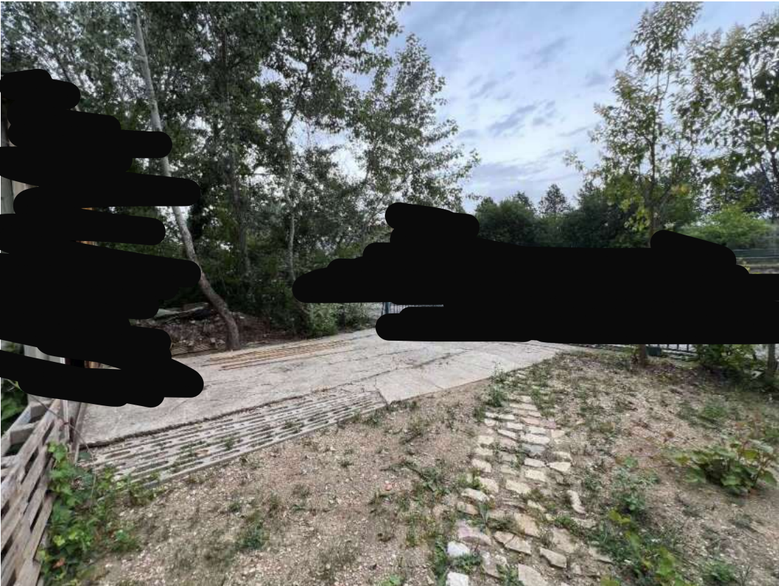
FOTO 28 PARTICOLARE TERRAZZO LATO INGRESSO GARAGE
