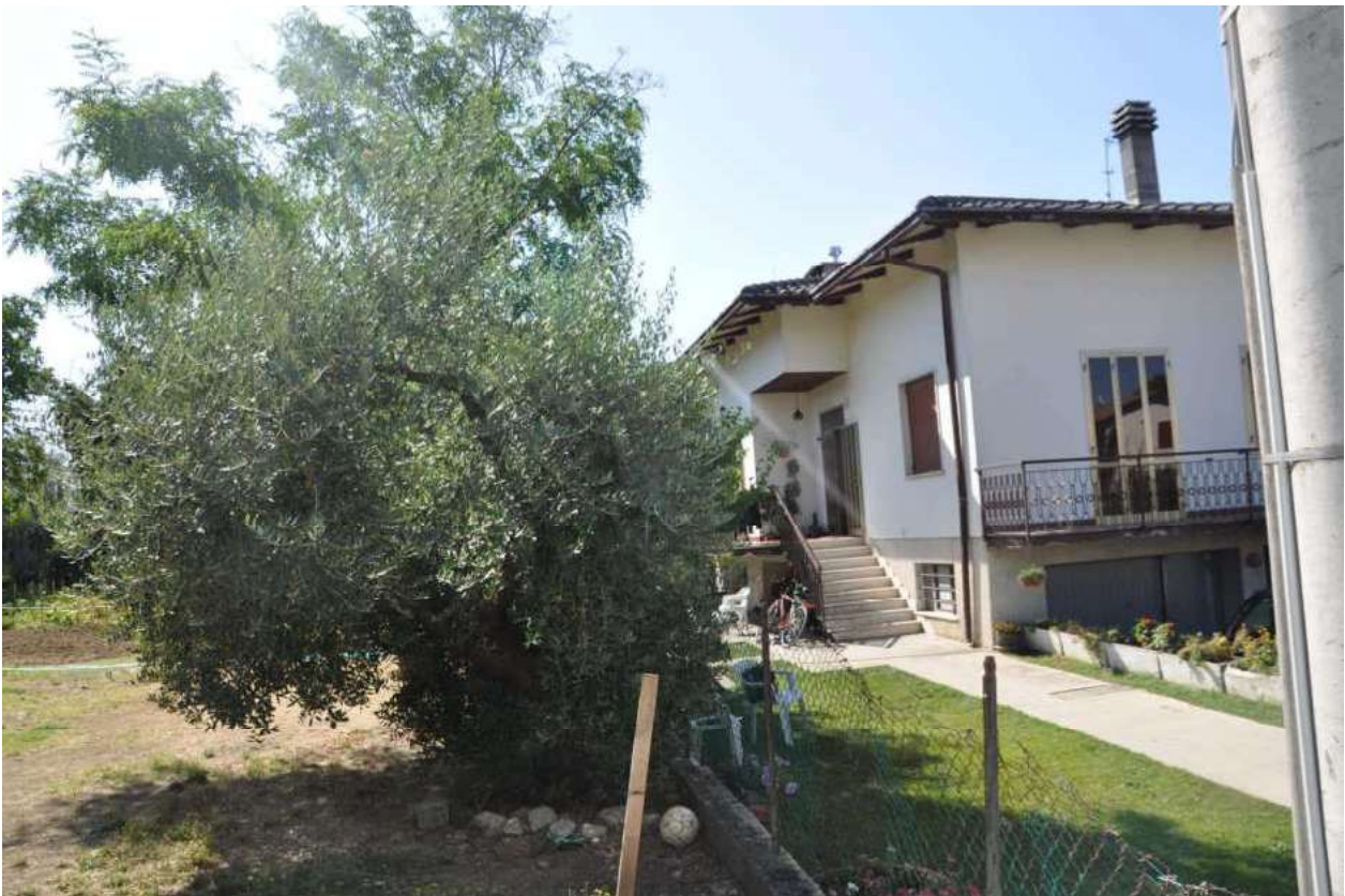
FOTO 4 PROSPETTO FABBRICATO LATO SX
