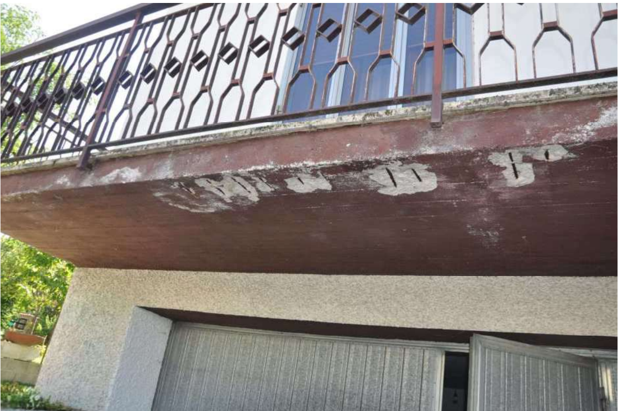
FOTO 26 PARTICOLARE TERRAZZO LATO INGRESSO GARAGE
