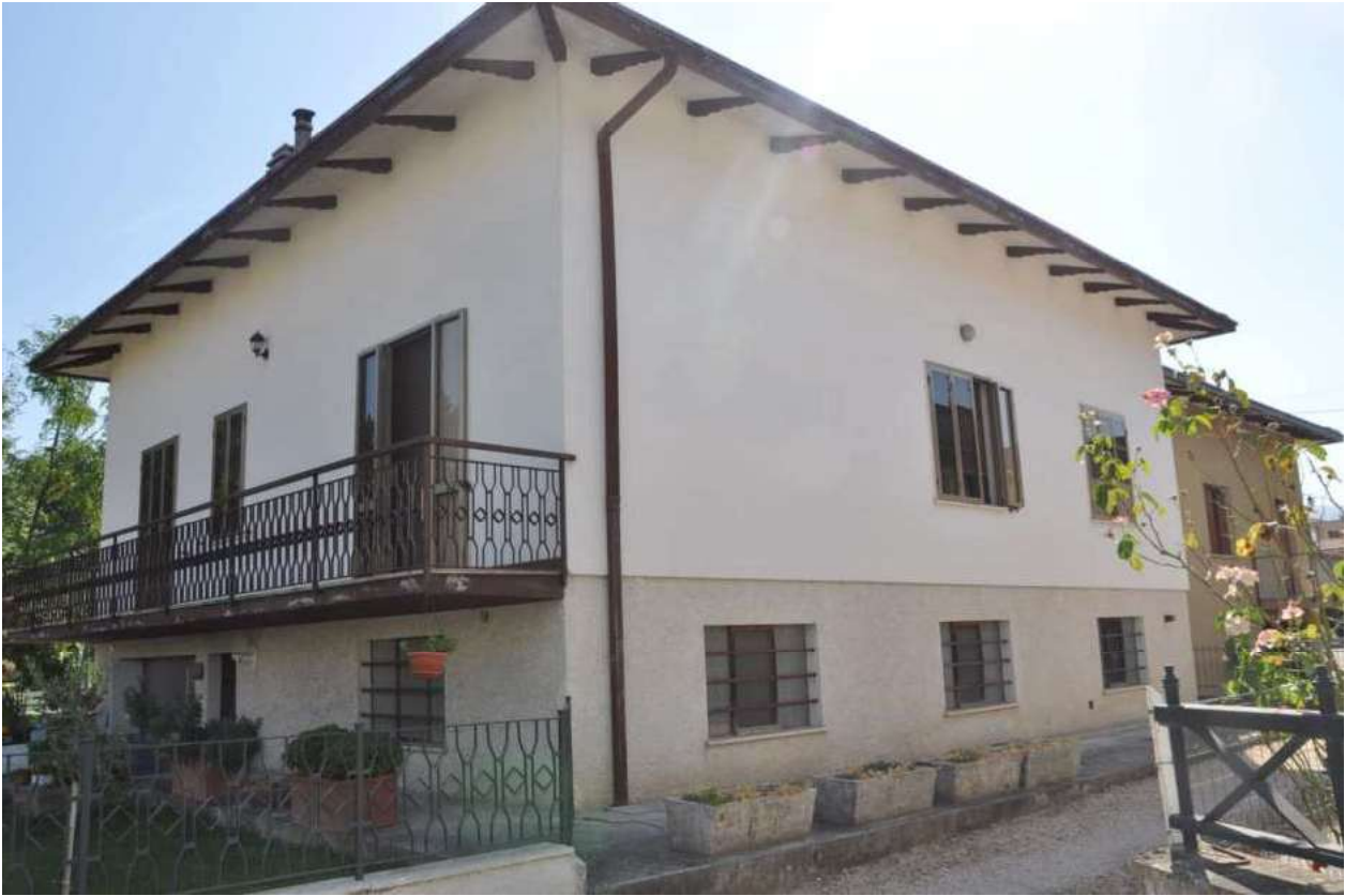
FOTO 3 PROSPETTO FABBRICATO LATO DX
