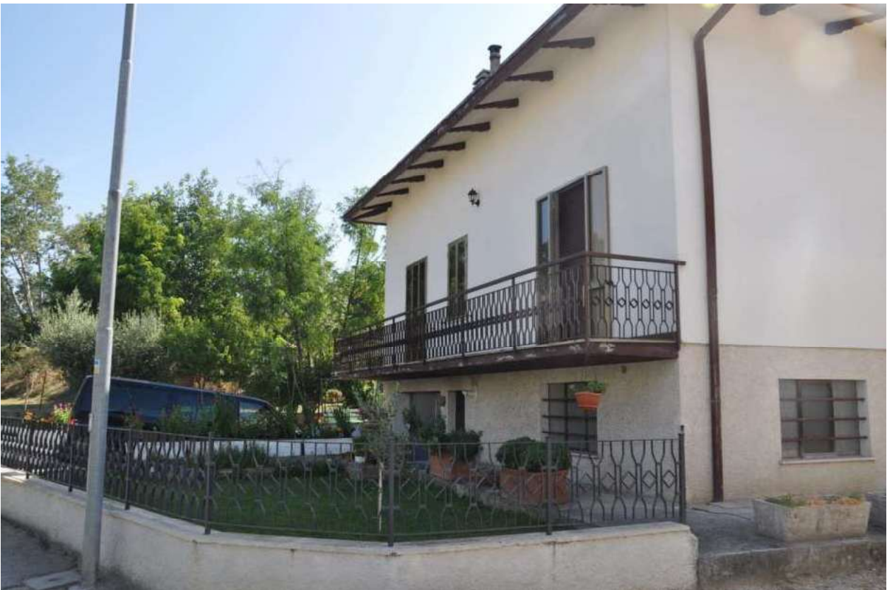
FOTO 2 PROSPETTO FABBRICATO LATO INGRESSO E DX
