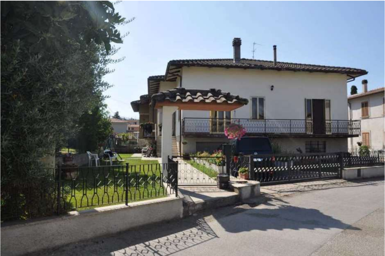
FOTO 1 PROSPETTO FABBRICATO LATO INGRESSO
