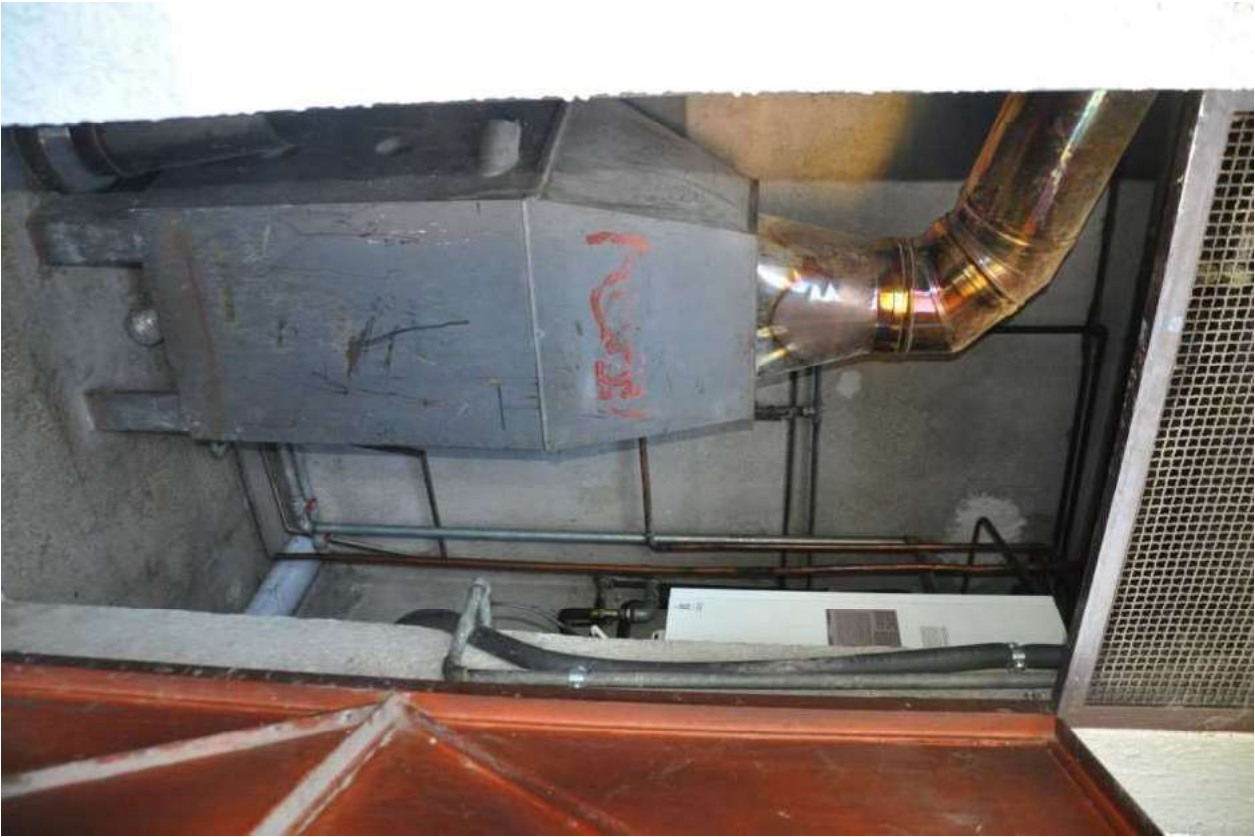
FOTO 25 P. SEMINTERRATO LOCALE TECNICO
