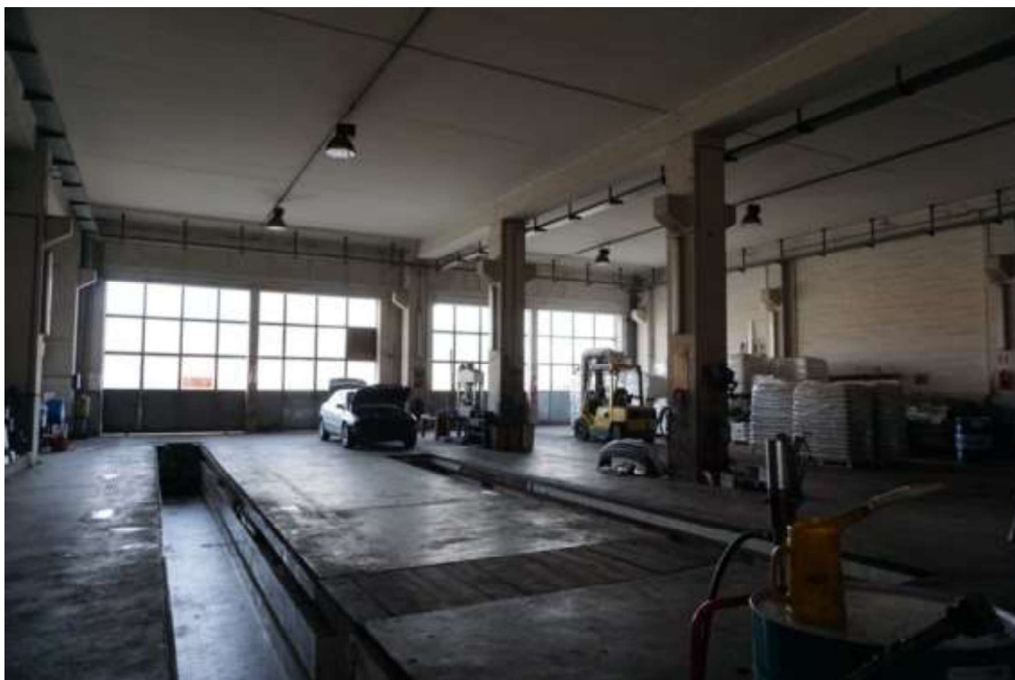
Fig.52 – Vista su vano interno dell’immobile al sub.7 (D1)
