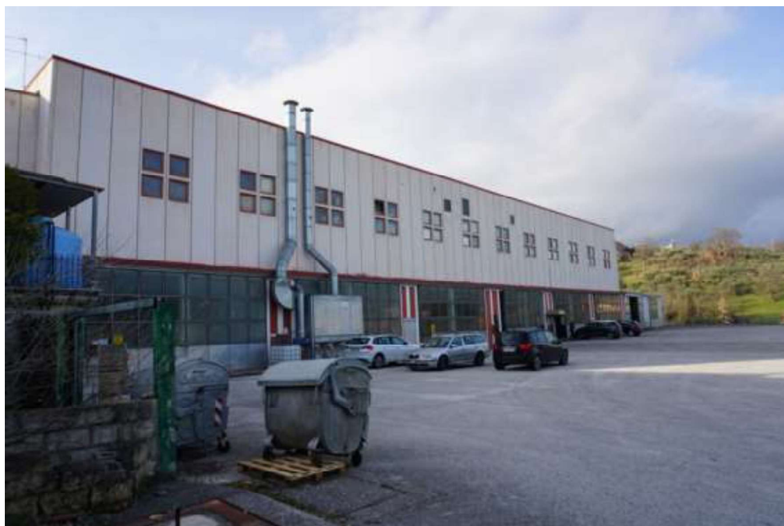
Fig.34 – Vista da sub.16 verso i sub.5-6-7-13
