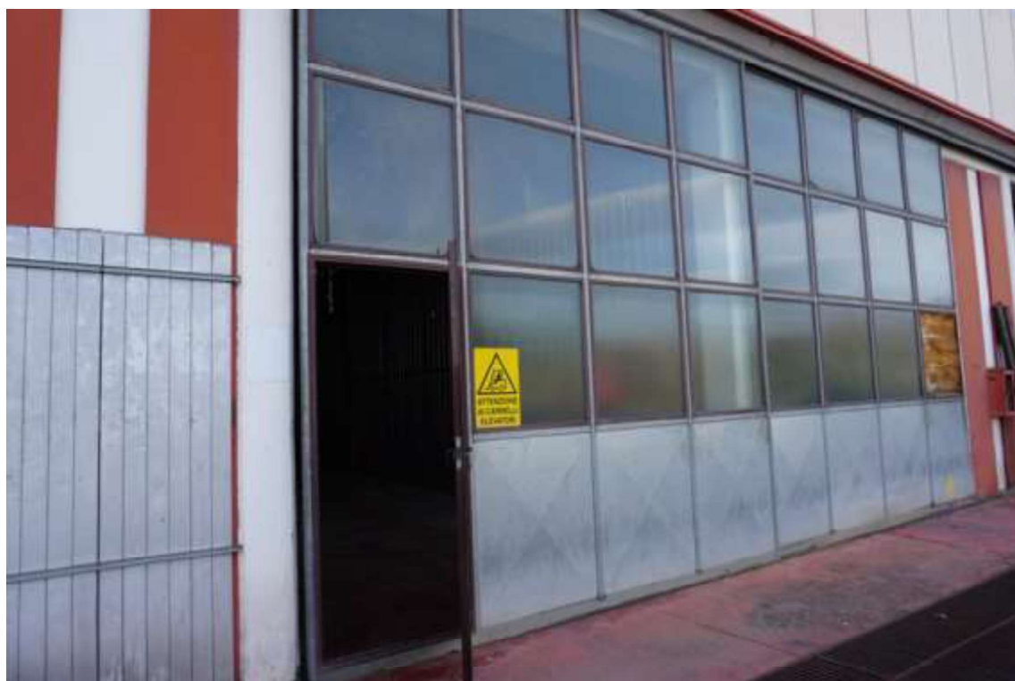
Fig.46 – Vista dell'ingresso del sub.6 (C2)
