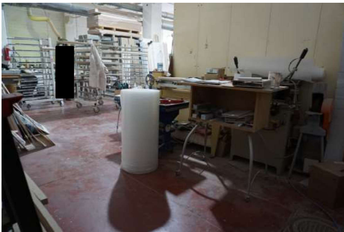
Fig.45 – Vista dell'ingresso e del vano d'ingresso dell'immobile al sub.5
