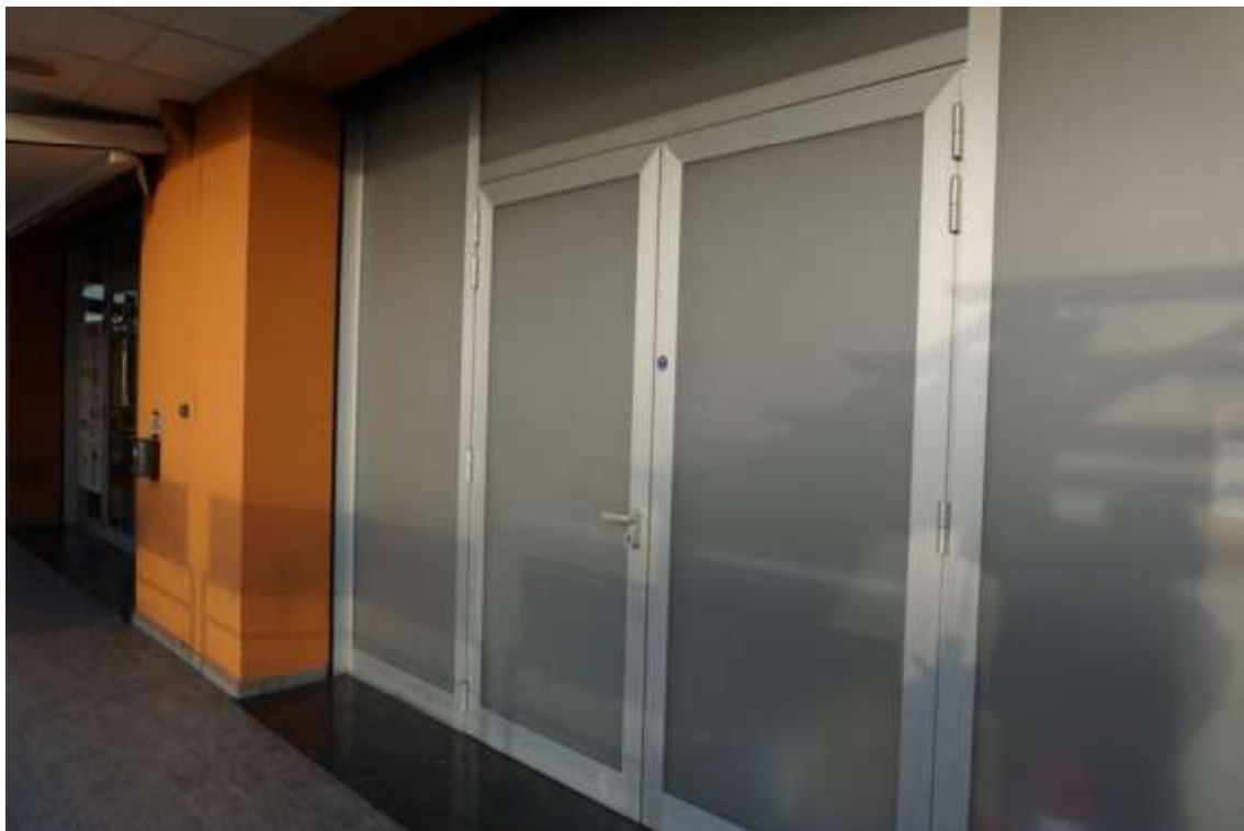
Fig.65 – Vista di uno degli accessi al sub.83 (C1)
