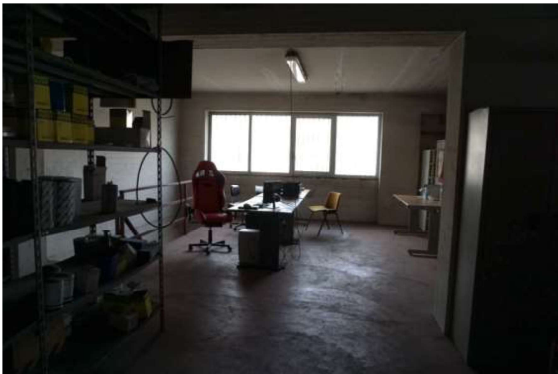
Fig.54 – Vista su mezzanino dell’immobile al sub.7 (D1)
