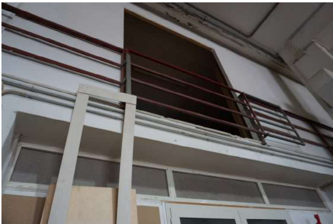
Fig.44 – Vista di dettaglio del mezzanino al sub.5 (C2)
