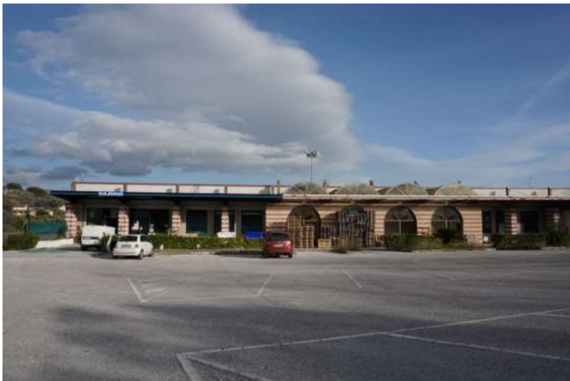
Fig.13 – Vista del fronte sub.18 (C1) e di parte del sub.17 (C1) posto subito accanto
