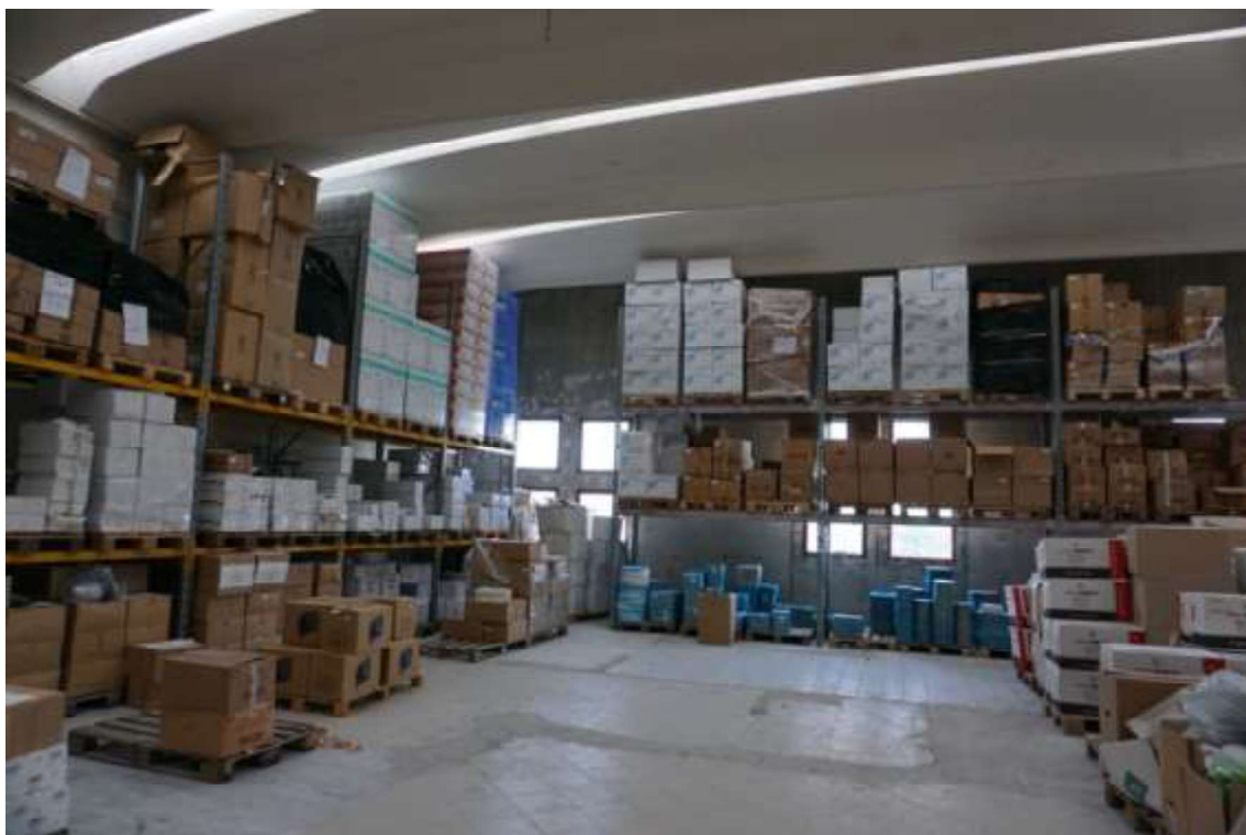
Fig.18 – Vista vano interno sub.18 (C1)
