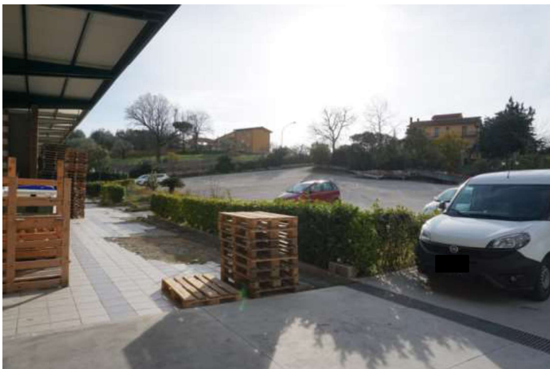
Fig.6 – Vista esterni sub.17-18 da nord verso sud
