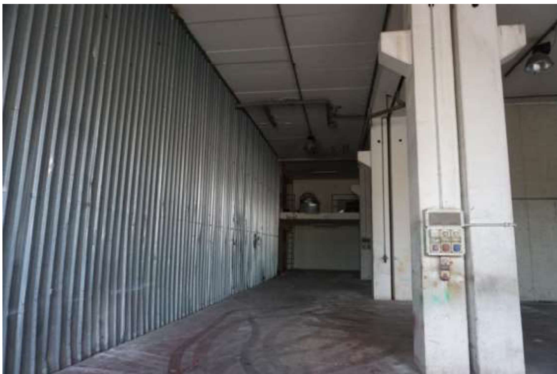
Fig.48 – Vista degli ambienti adibiti a deposito del sub.6 (C2)
