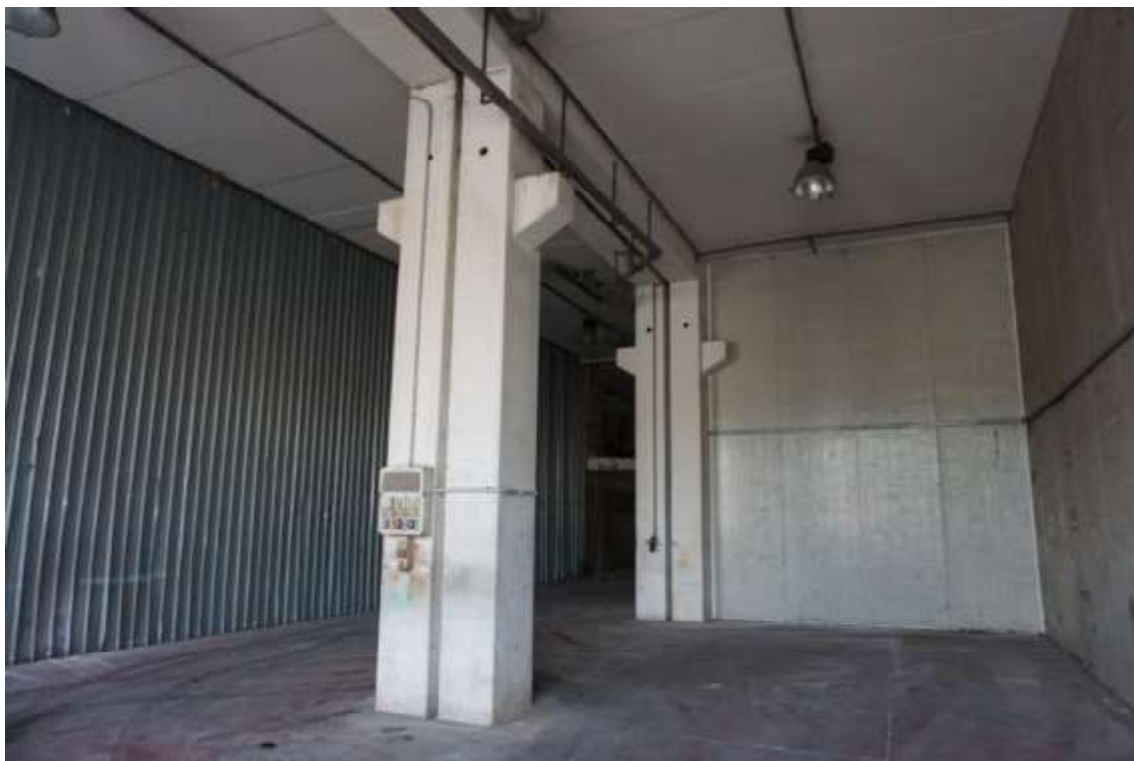
Fig.49 – Vista degli ambienti adibiti a deposito del sub.6 (C2)
