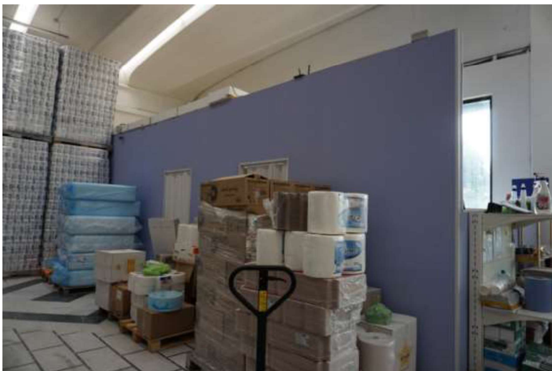
Fig.24 – Vista vano interno sub.18 (C1)
