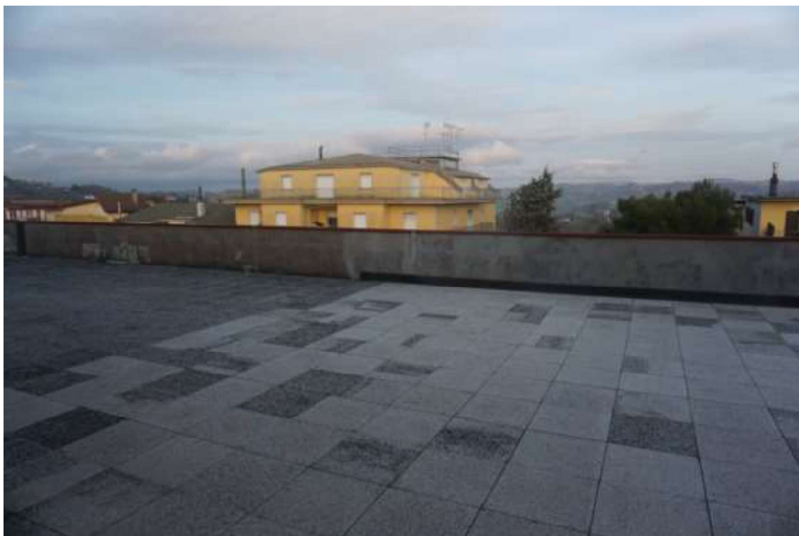
Fig.101 – Vista verso est del terrazzo posto ad est dell’immobile al sub.70 (A10)
