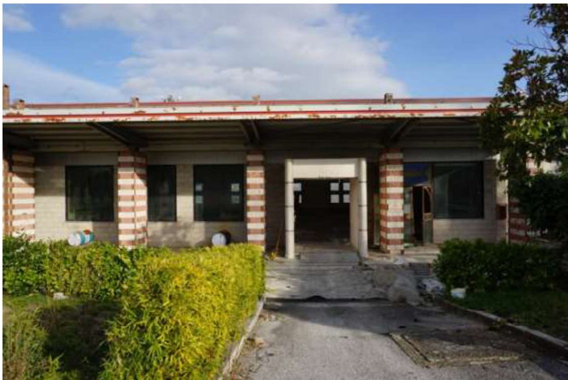
Fig.8 – Vista del fronte porticato dell'immobile al sub.17 (C1)
