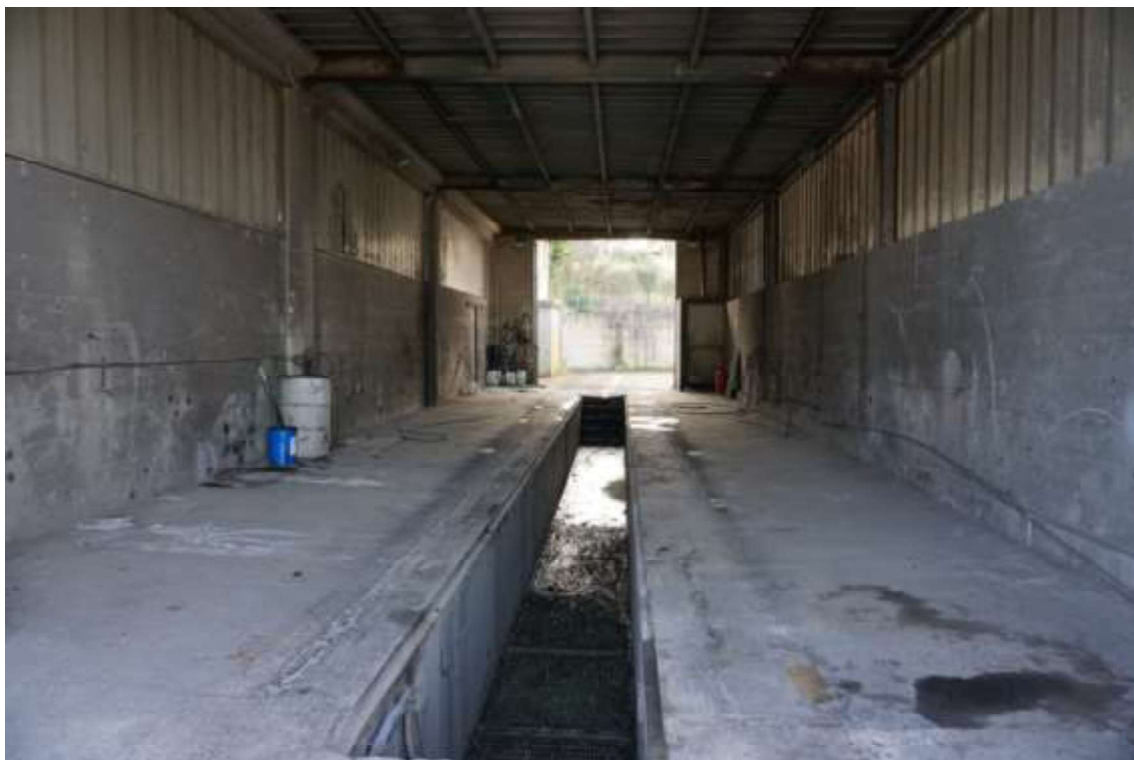
Fig.61 – Vista dell'immobile al sub.13 (C2) ad uso autolavaggio
