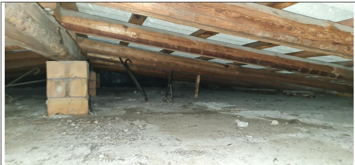
Struttura del manufatto in copertura appoggiato su pile di mattoni
