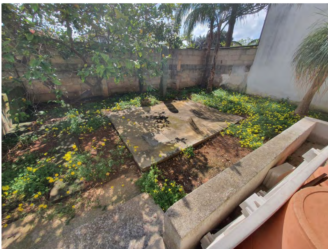
Cortile retrostante comune a P.T. (pozzo nero comune)
