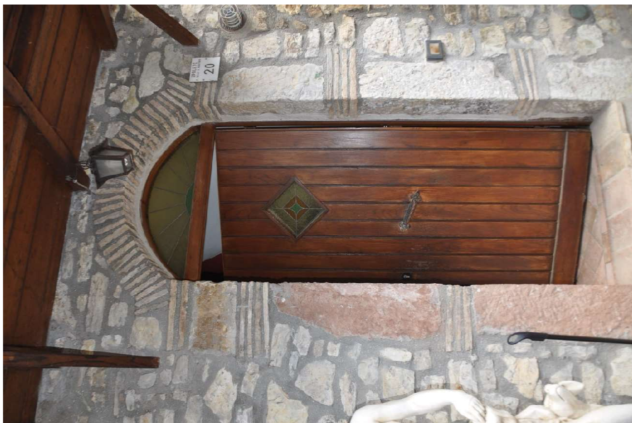
FOTO 5 INGRESSO UNITA' IMMOBILIARE
