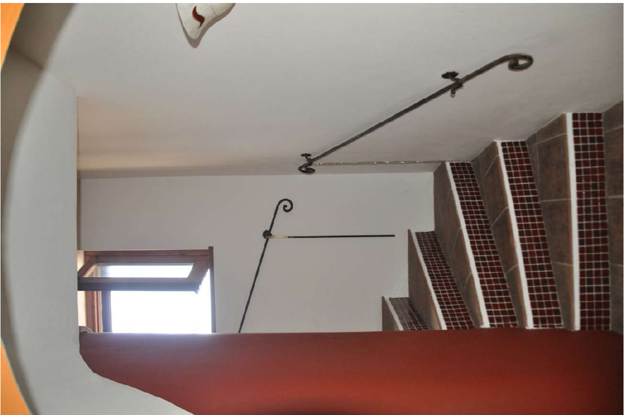
FOTO 16 SCALA INTERNA DI COLLEGAMENTO
