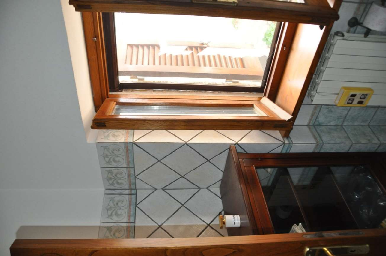
FOTO 19 PIANO TERRA LOCALE BAGNO
