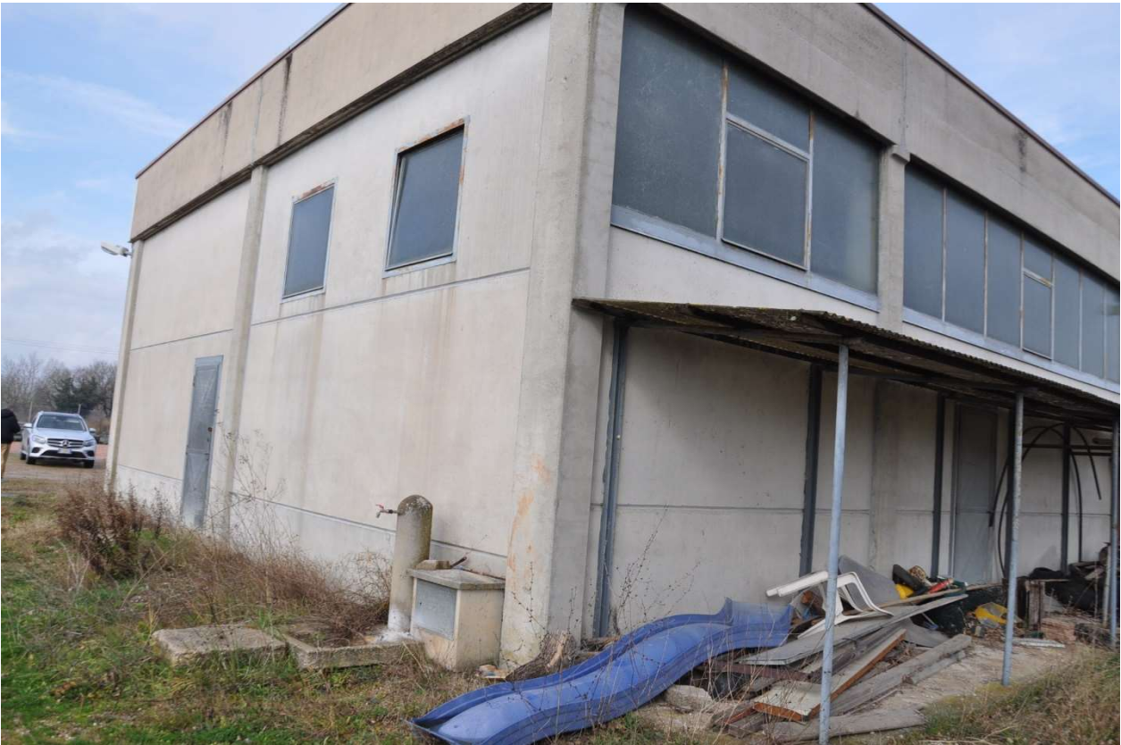
FOTO 3 PROSPETTO FABBRICATO LATERALE DX E POSTERIORE
