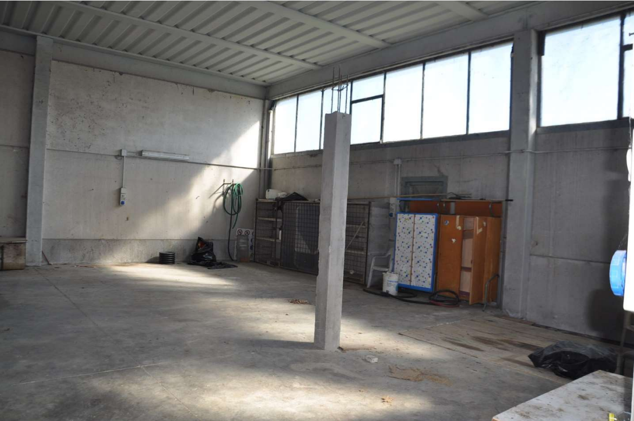
FOTO 10 ZONA INTERNA FABBRICATO
