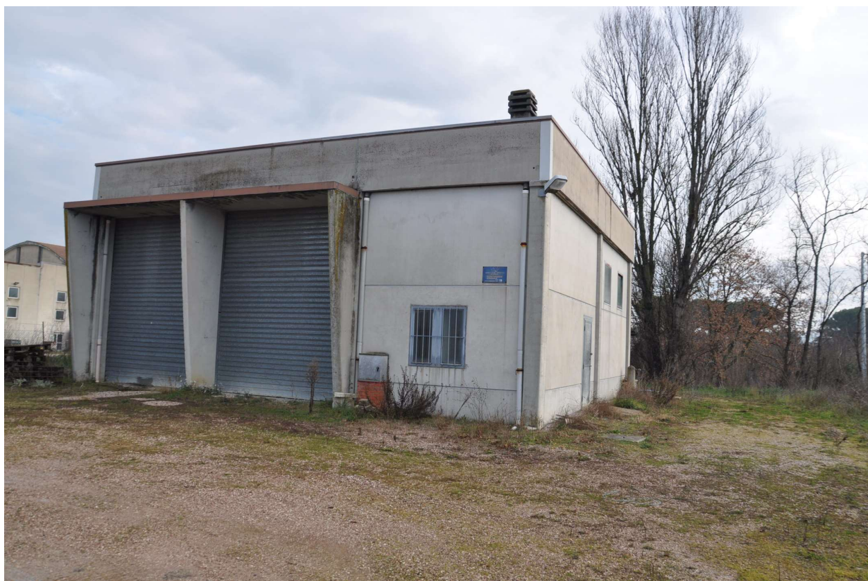
FO TO 1 PROSPETTO FABBRICATO FRONTALE
