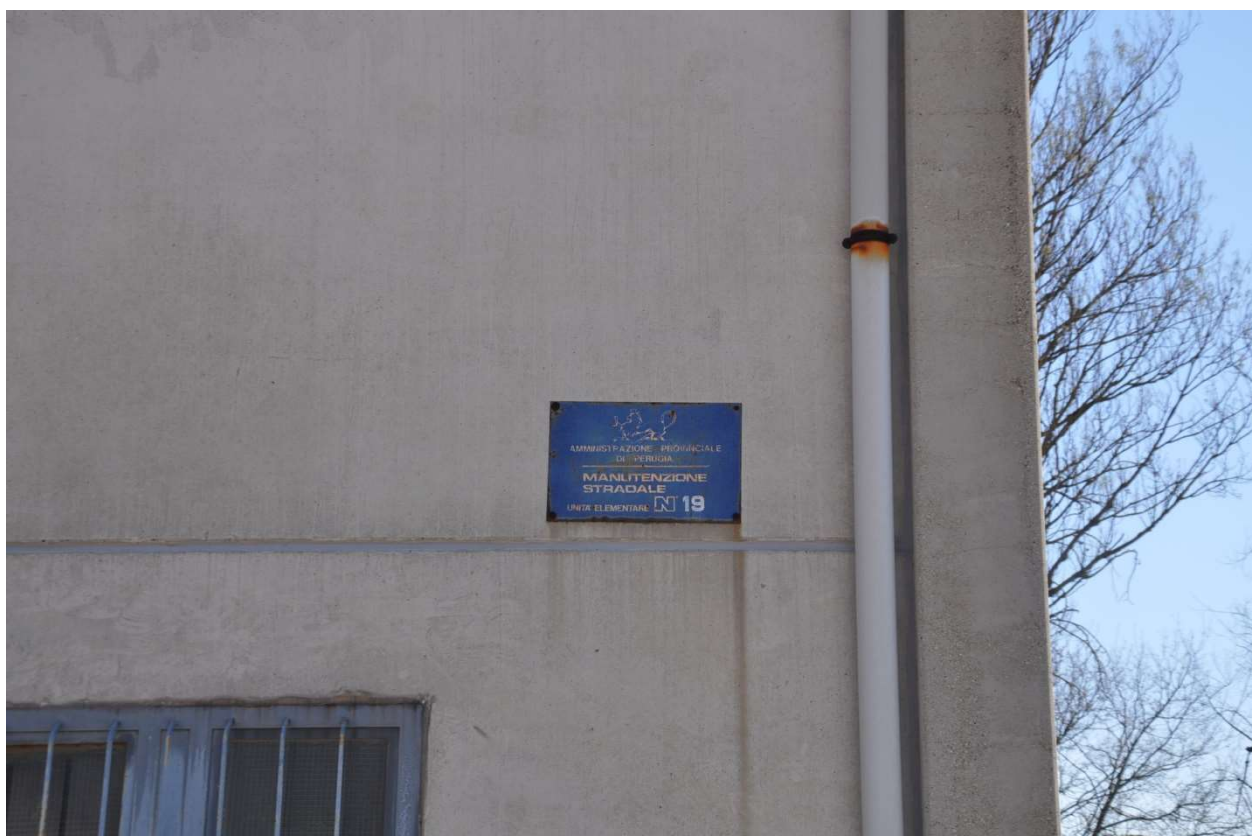
FOTO 14 PARTICOLARE TARGA SU PROSPETTO ANTERIORE
