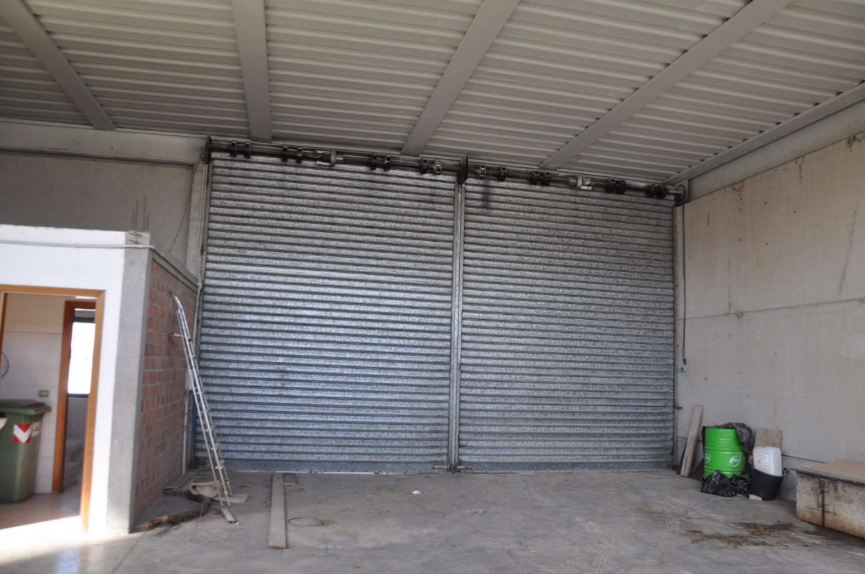
FOTO 9 ZONA INTERNA FABBRICATO
