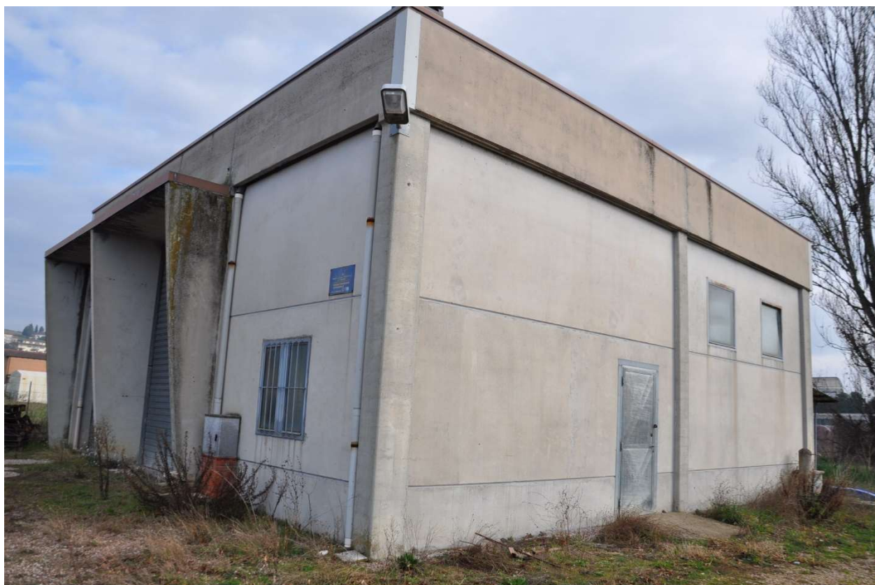
FOTO 2 PROSPETTO FABBRICATO LATERALE DX
