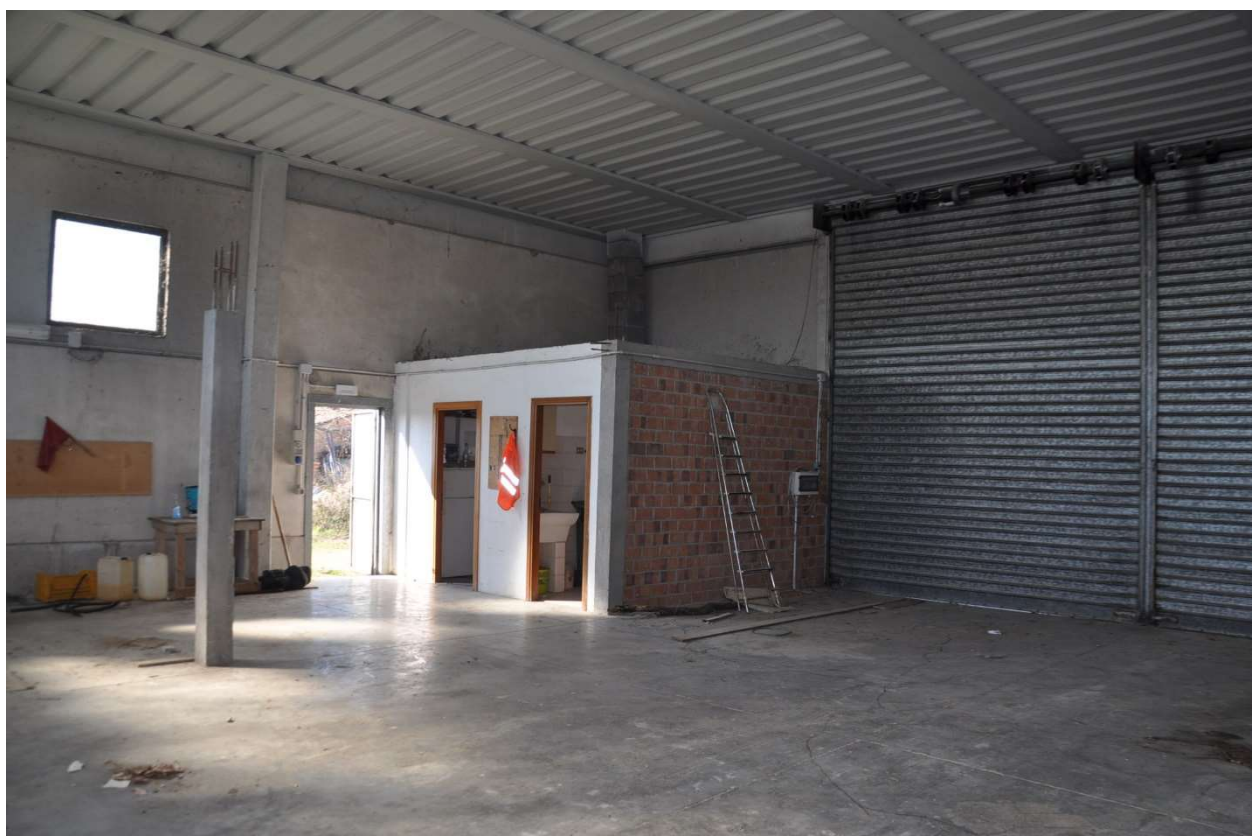
FOTO 8 ZONA INTERNA FABBRICATO
