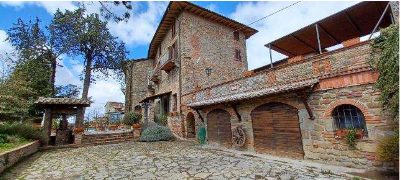
Foto n. 4. Esterno dall'ingresso di via della Fratellanza
