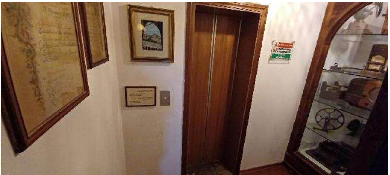
Foto n. 18. Piano terra. Ascensore
