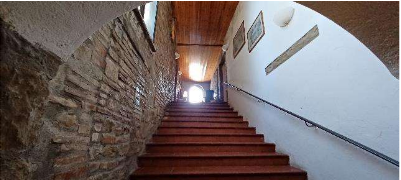
Foto n. 25. Scala da foyer a primo piano lato nord
