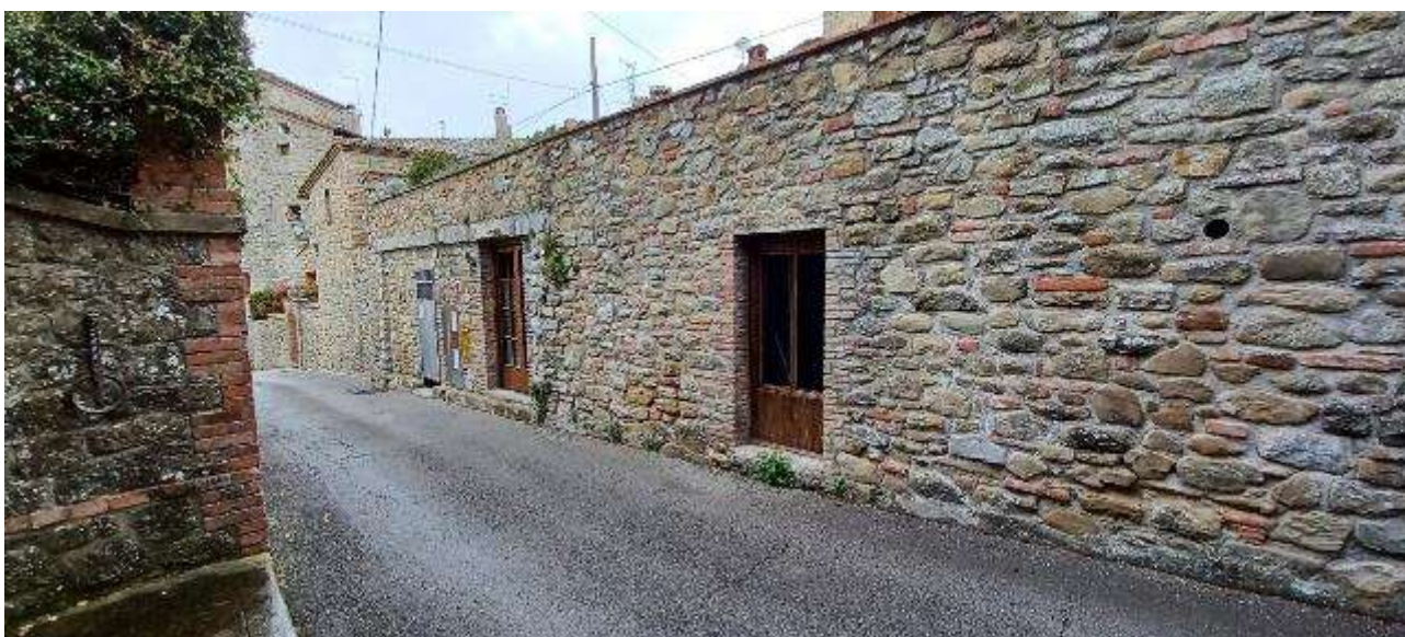
Foto n. 3. Vista esterna da Via della Fratellanza. Accesso CT e seminterrato.
