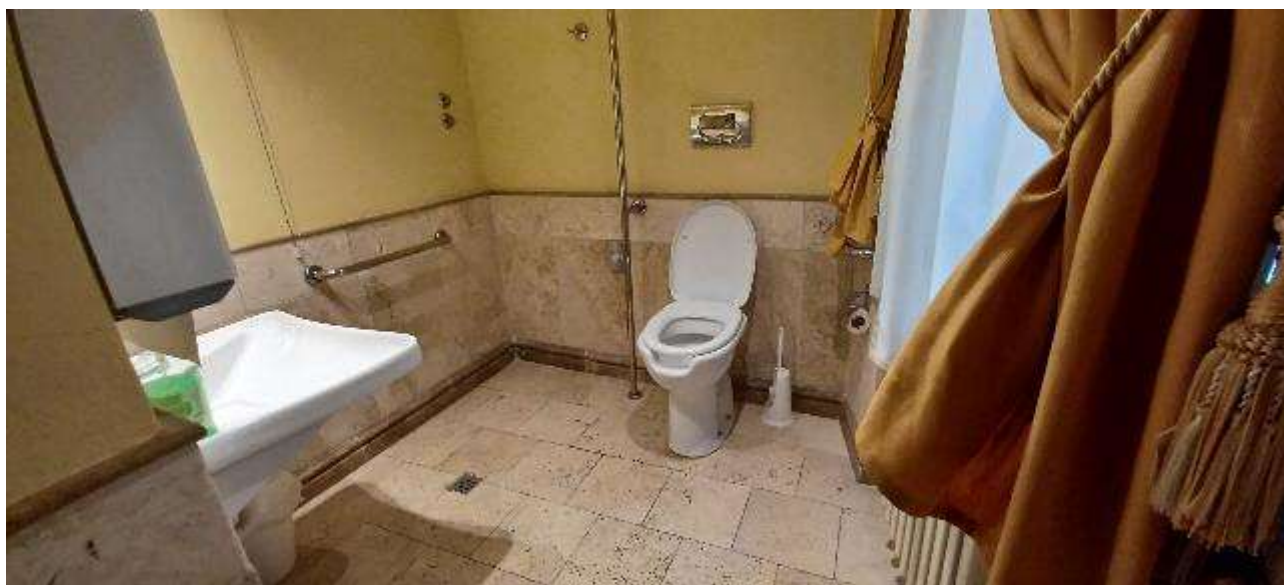
Foto n. 21. Piano terra. Bagno disabili sala ristorante/convegni
