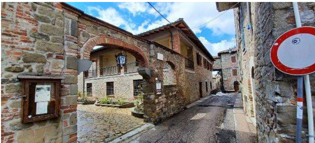
Foto n. 1. Vista esterna da via Rigone.
