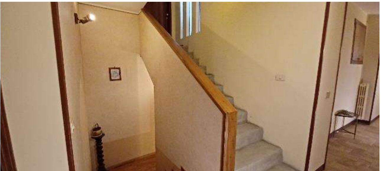
Foto n. 27. Scala interna (lato sud) per l'accesso al sub 3
