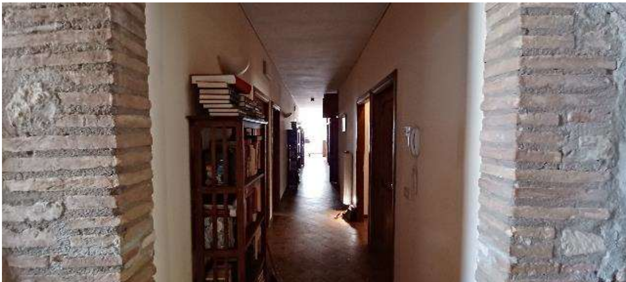
Foto n. 28. Corridoio accesso camere lato nord
