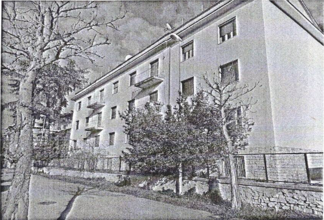
Veduta esterna - fabbricato plurifamiliare sito in Via Fiume Nera, 8/A – Foligno
