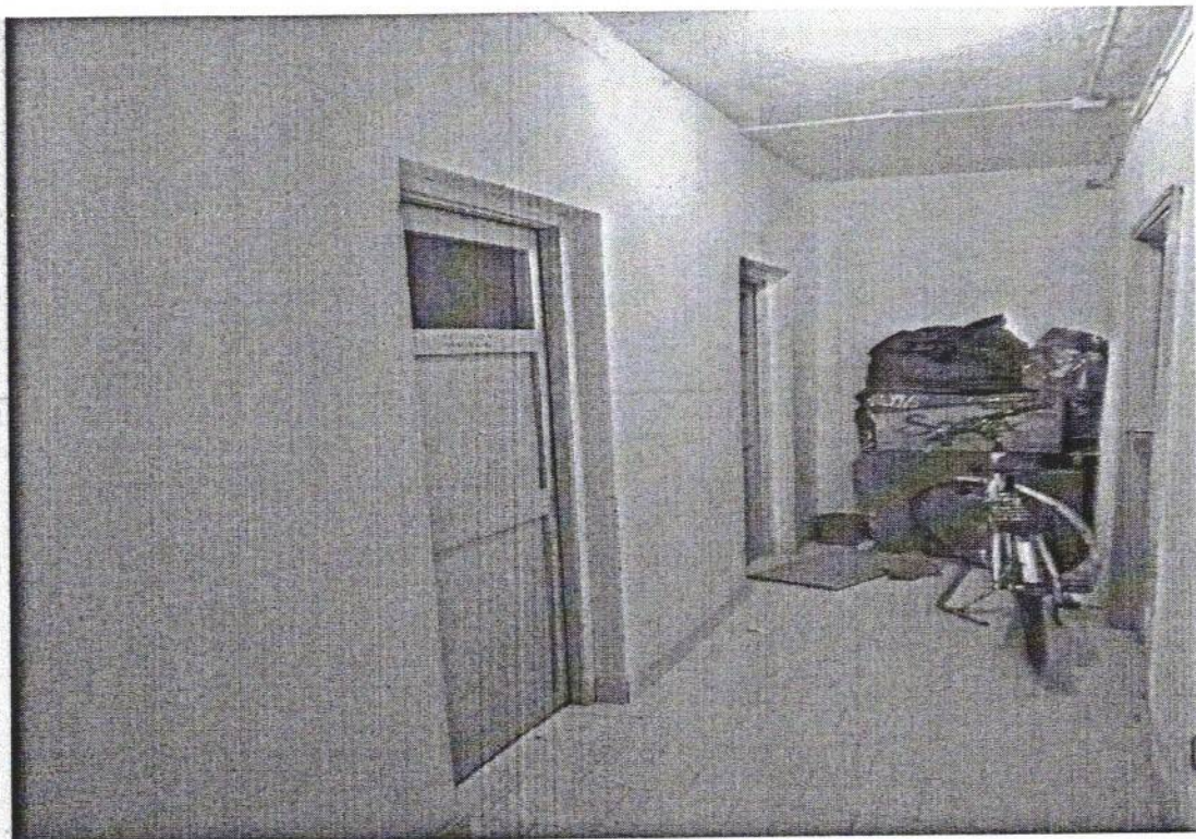
Veduta interna - corridoio comune ed ingresso fondo al piano seminterrato
