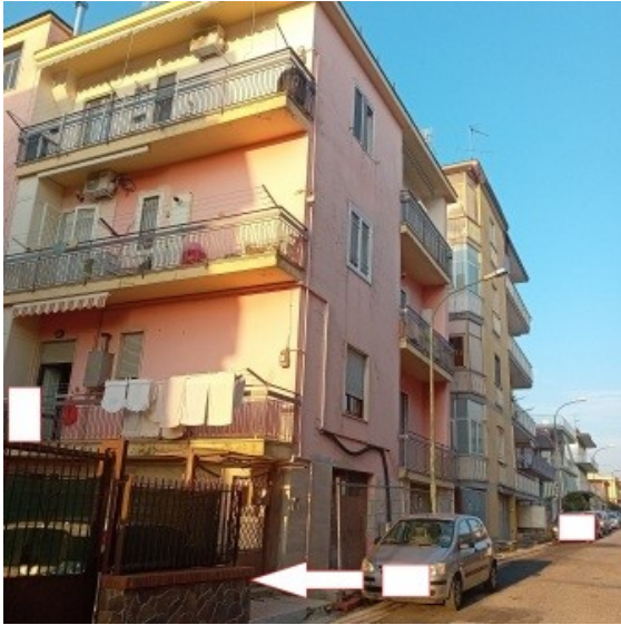
Foto 1 facciata nord/ovest del fabbricato alla via Vincenzo Bellini in Pollena Trocchia con accesso al cortile comune civico n.42
