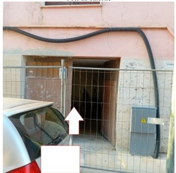
Foto 24 accesso al box auto pertinenziale al piano terra al civico n.40 di via Vincenzo Bellini
